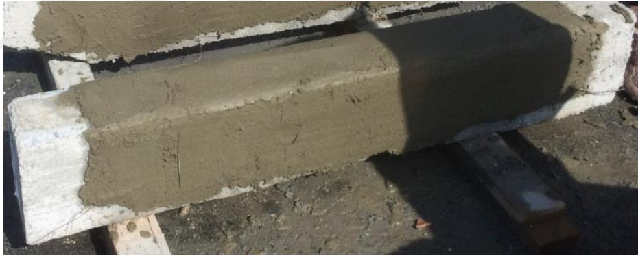
Şekil 2.4 Karbon lifli ızgara kumaşın çimentolu harç yardımıyla betonarme kiriş yüzeyine uygulanması ve sonrasında harcın priz alması için beklenmesi
