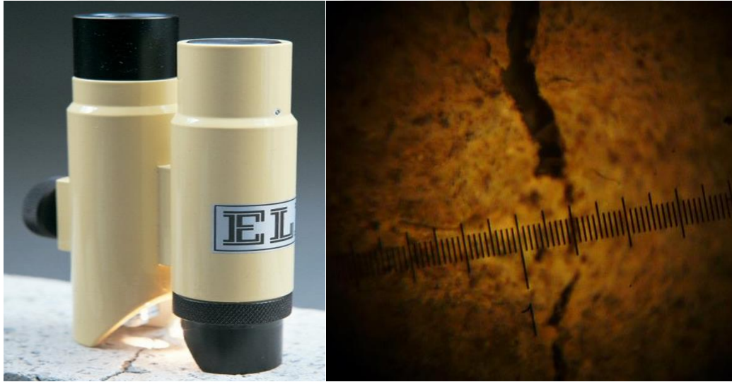
Resim 3.9. YPLDÇK betonu kısıtlanmış rötre çatlaklarının ölçülmesi
