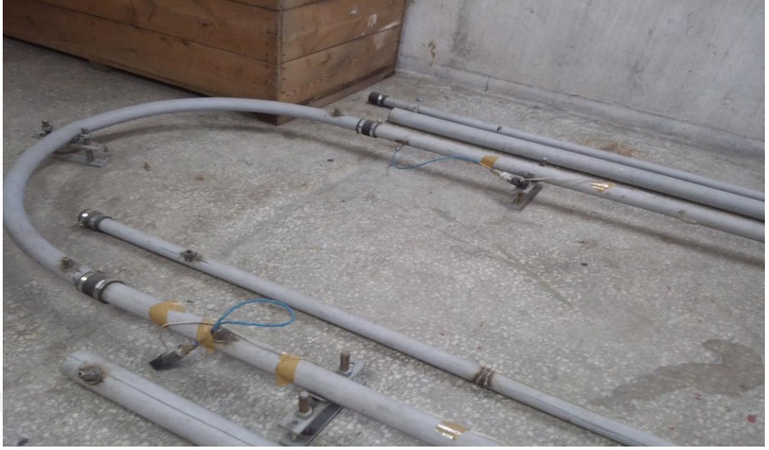
Şekil 3.9 Denemelerde kullanılan pnömatik iletim tesisindeki üç farklı çaptaki boru hattı elemanları, döşenmesi ve yerleştirilmesi (Anonim 2016)
