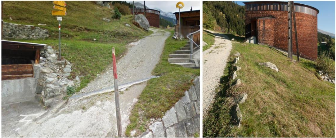
Şekil 5. 8: Asfalt yol (URL-7). Şekil 5. 9: Şapele giden yol (URL-8).
