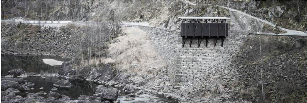
Şekil 5. 48: Taş duvar ve niçin içine konumlanan tuvalet yapısı (URL-16).
