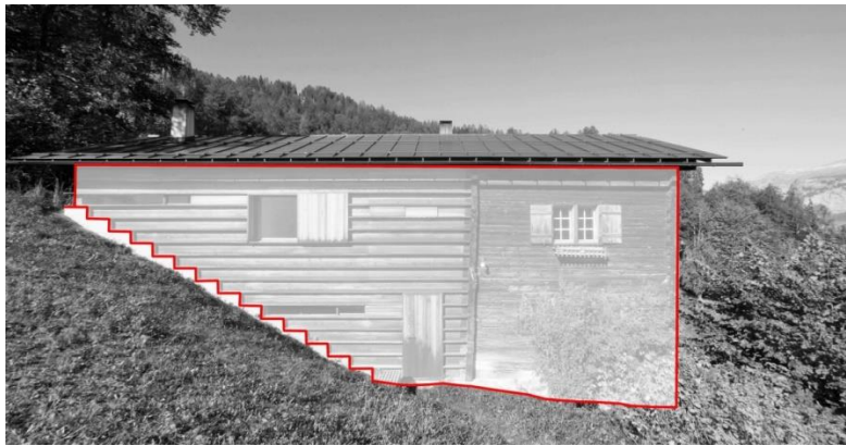
Şekil 5.65 : Gugalun Evi şekil-zemin ilişkisi (Engin T. Bakış).
