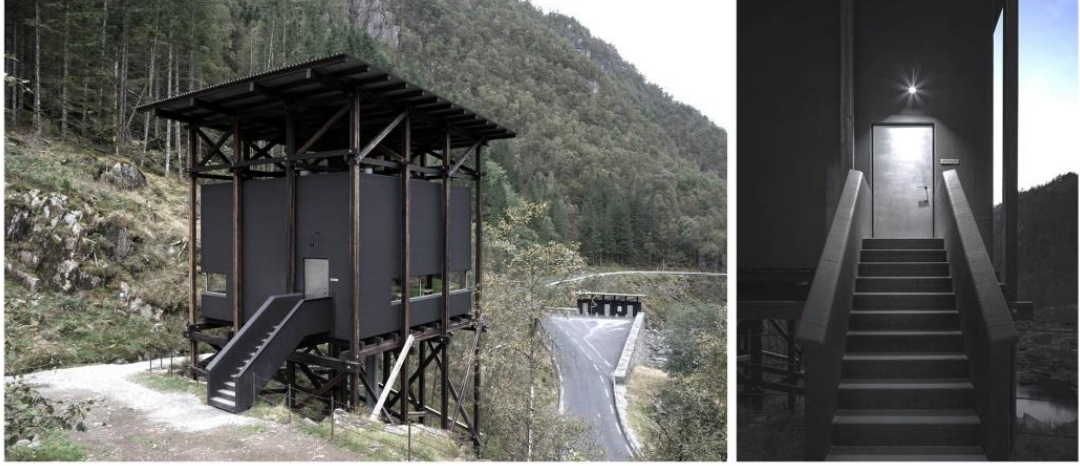
Şekil 5. 39 : Kafe yapısı ve merdiven ilişkisi (URL-15). Şekil 5. 40 : Çinko kapı (URL-16).
