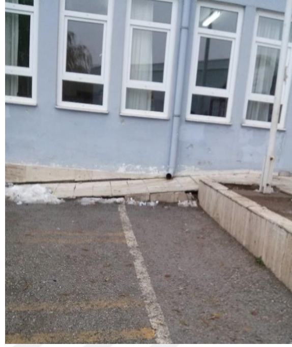
Resim 55: (OHK) Bina giriş rampası
