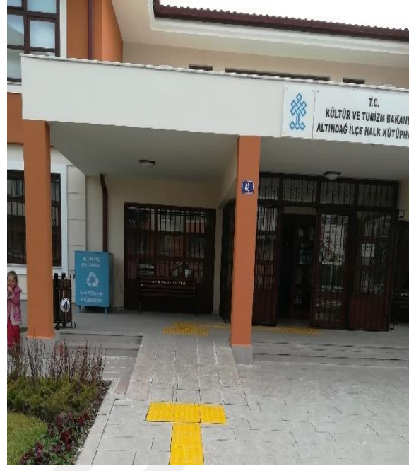
Resim 133: (ADK) Bina girişi rampası
