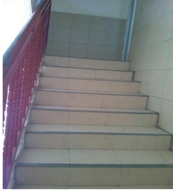
Resim 105: (YHK) Bina içi merdiven ve tırabzanlar
