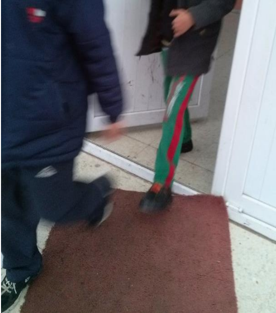
Resim 56: (OHK) Bina kapı eşiği
