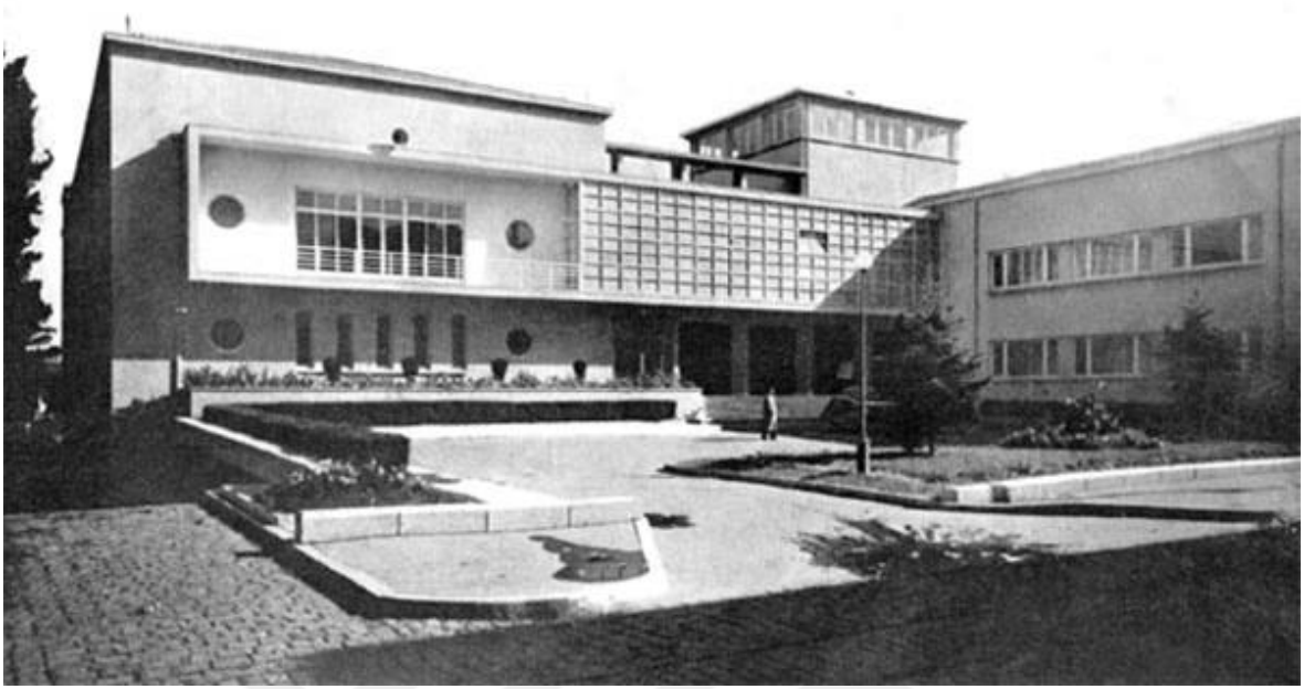
Şekil H.1. Kadıköy Halkevi Ön Cephe Fotoğrafı (Yurdakul, 2018).
