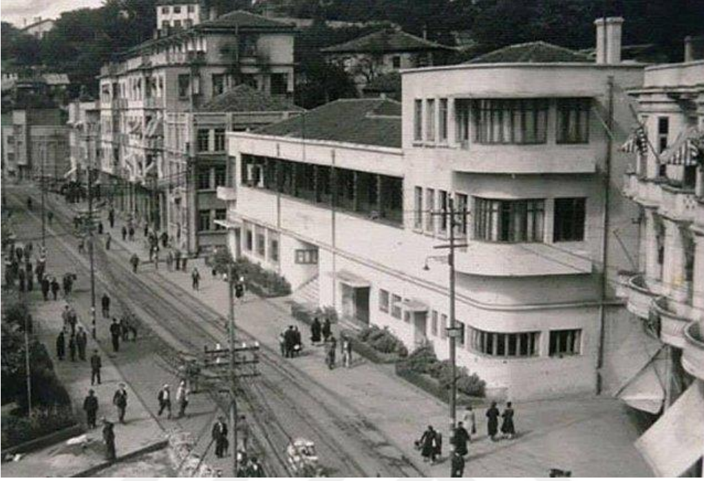
Şekil F. 1. Zonguldak Gazi Paşa Caddesi ve Halkevi Yapısı (Anonim, 2017a).
