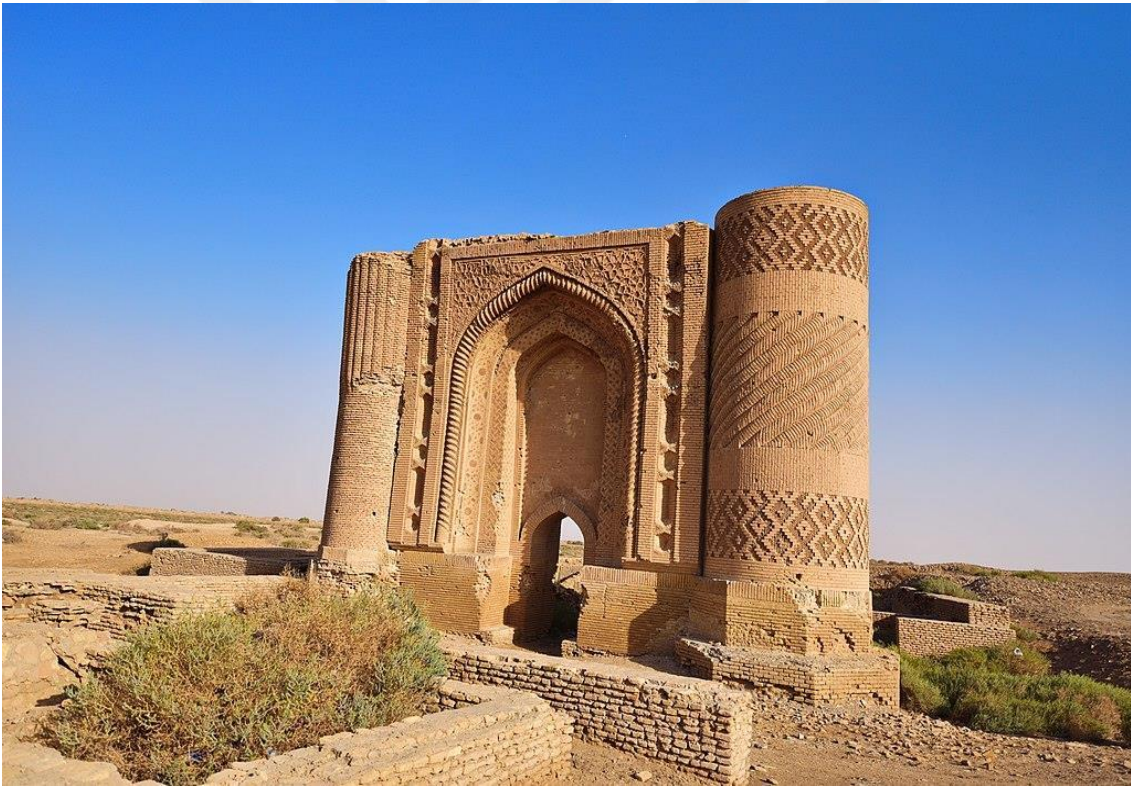
Şehrin Günümüze Kadar Ulaşmış Olan Giriş Kapısı 398
