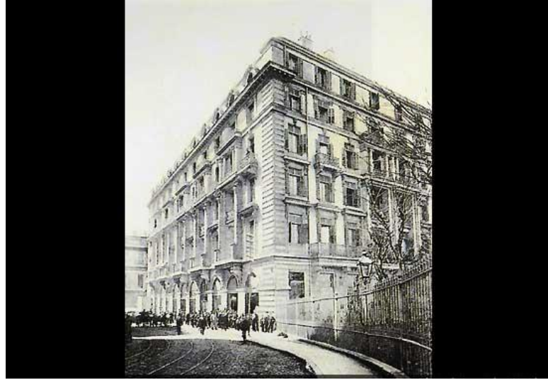
Şekil 2.3: Otel Pera Palace'a Ait Cephe Görünümü
