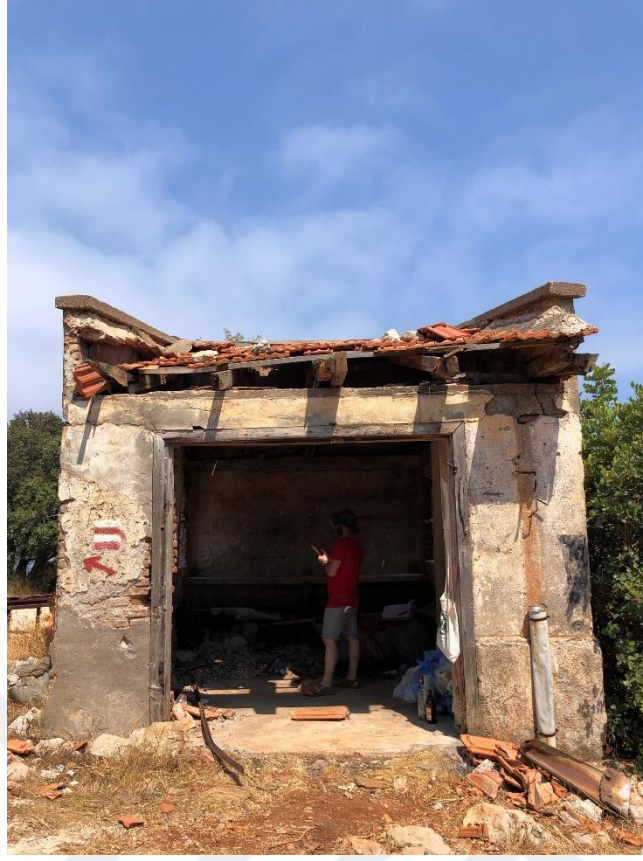
Şekil D. 43 : Ahır yapısı batı cephesi.
