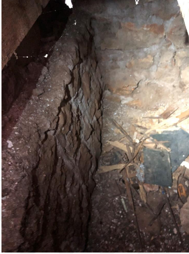
Şekil D. 7 : G05 mekanı alt kısmında bulunan depo.
