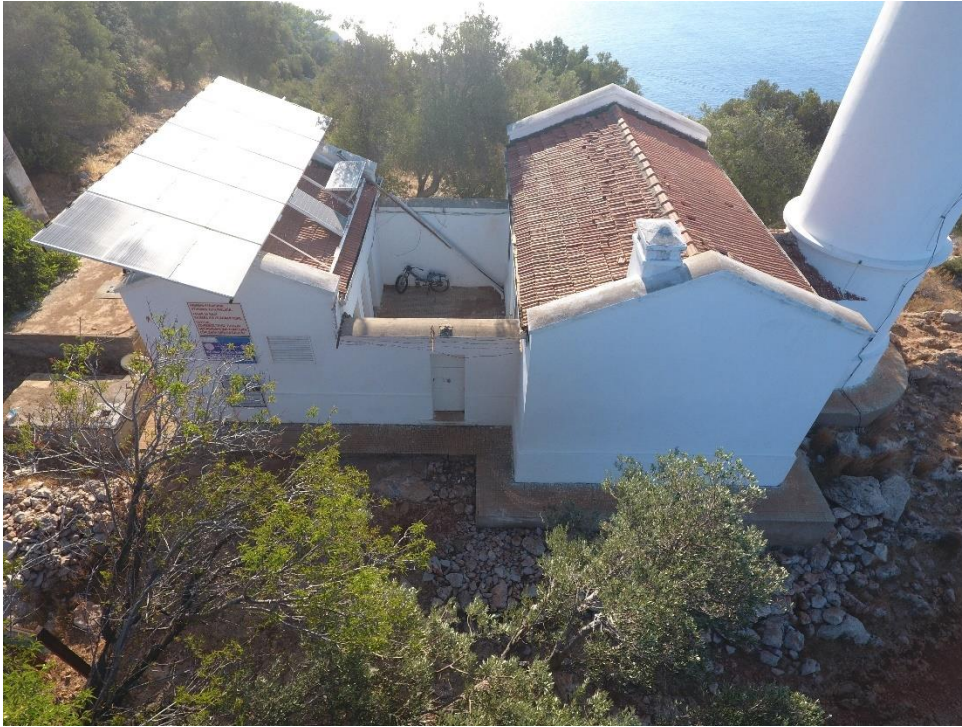
Şekil D. 4 : Deniz feneri giriş cephesini gösteren drone fotoğrafı
