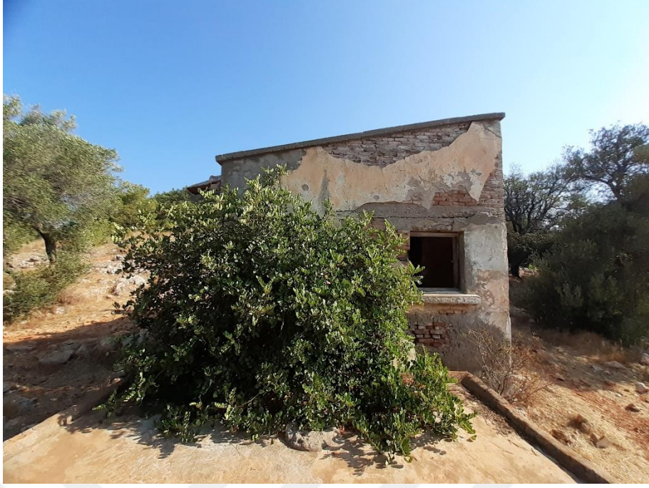
Şekil D. 41 : Ahır yapısı güney cephesi.
