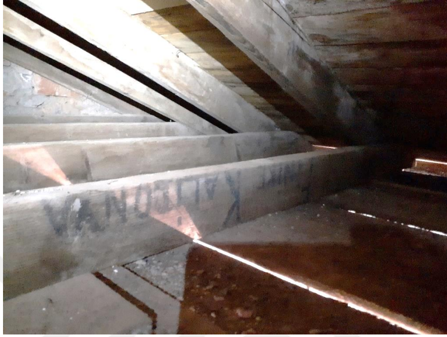
Şekil 4. 1 : Çatı arası, çatı aşığında yazan “KALİDONYA” yazısı.
