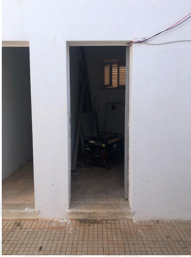
Şekil D. 33 : Avludan (G01) atölyeye (G09) geçişi sağlayan kapı.
