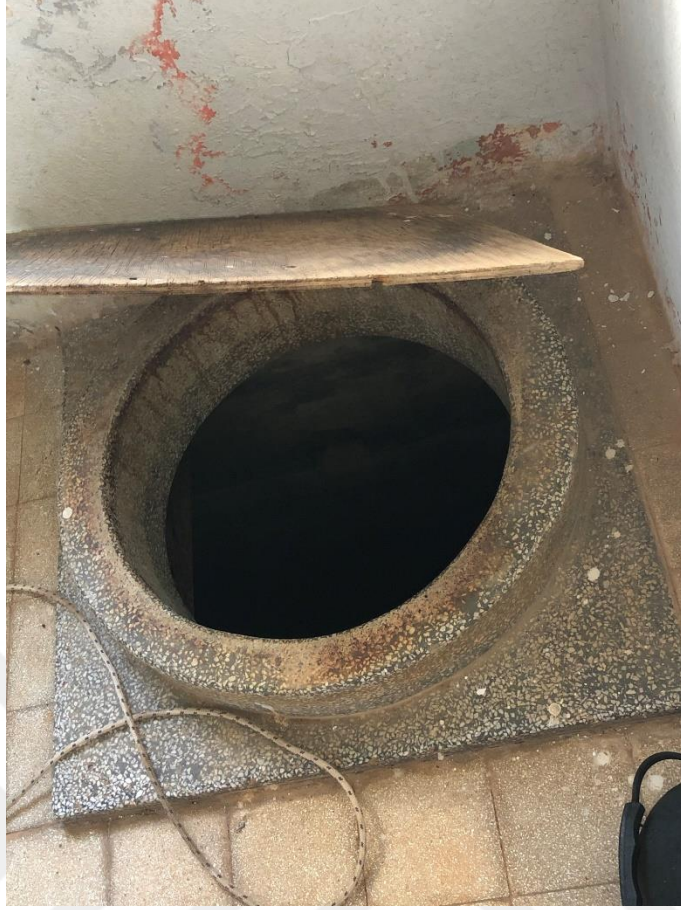
Şekil D. 5 : Mutfak içerisinde erişilen sarnıcın girişi.
