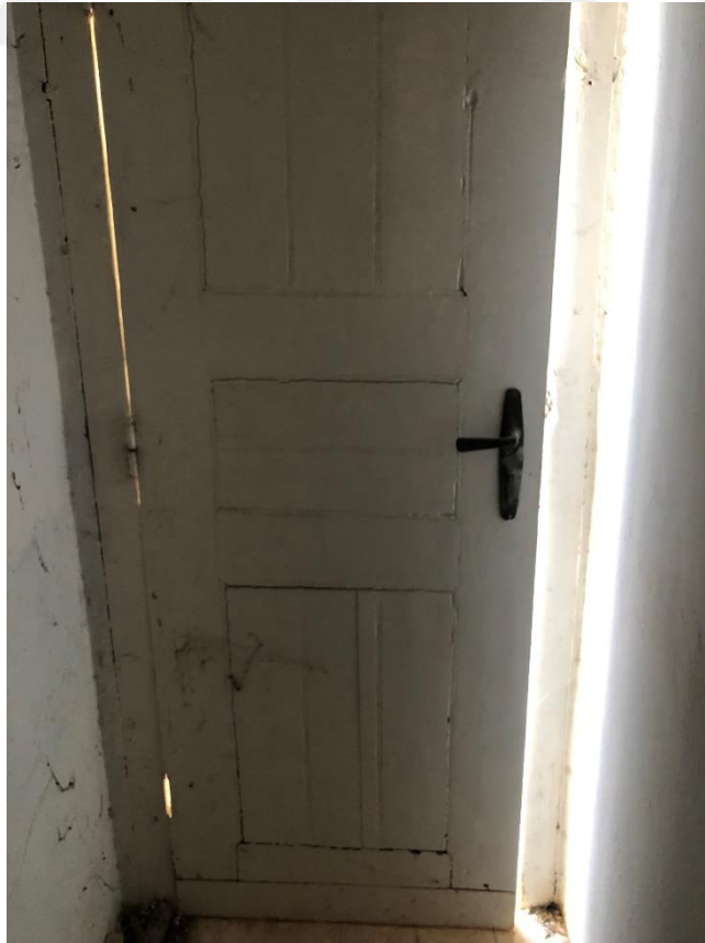
Şekil D. 30 : Tuvalet kapısı, iç görünüş.
