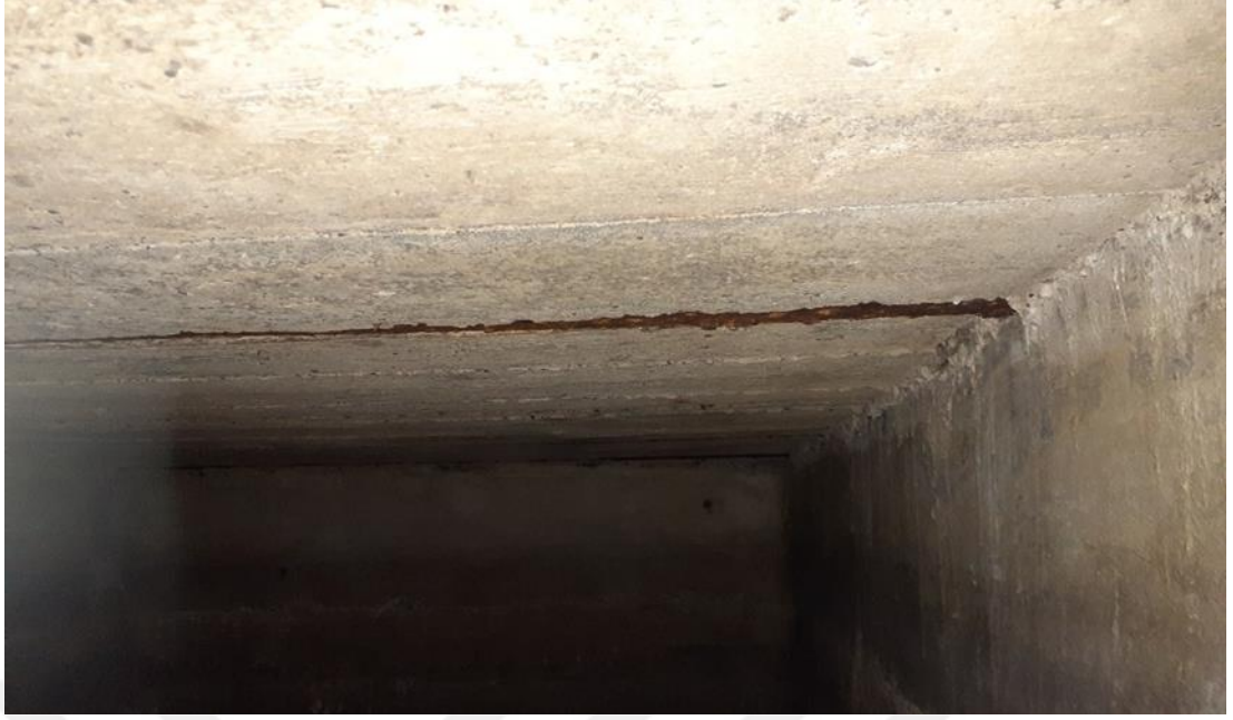
Şekil 4.7 : Mutfak döşemesinin altındaki beton yüzey ve çelik profiller.
