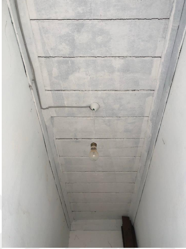
Şekil D. 29 : Tuvalet ahşap tavan kaplaması.
