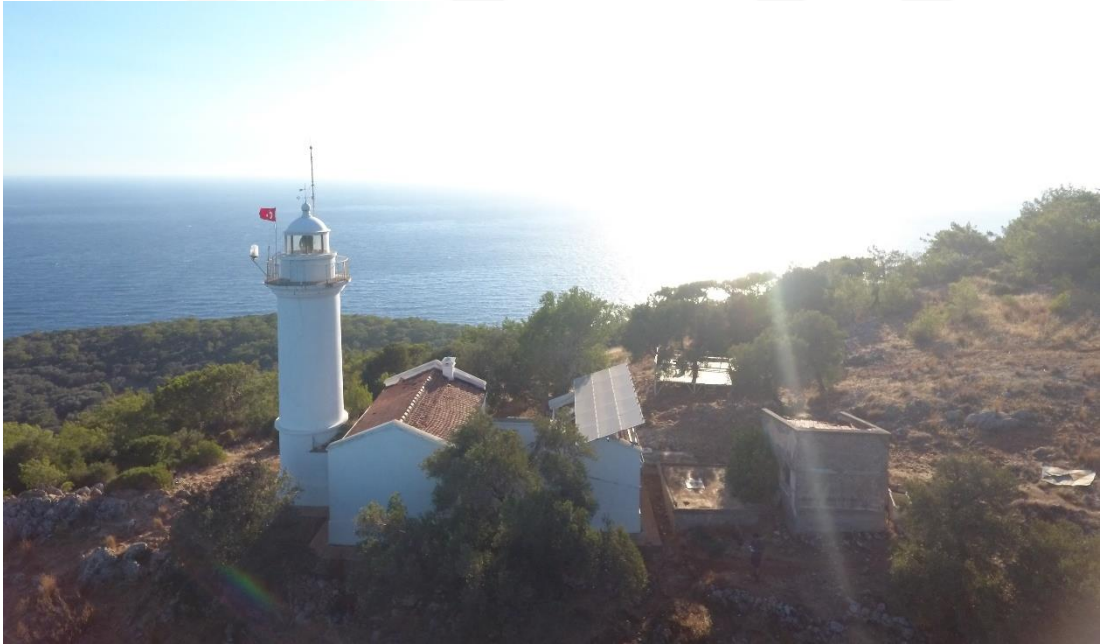
Şekil D. 2 : Deniz feneri ve çevre yapıları içeren drone fotoğrafı.
