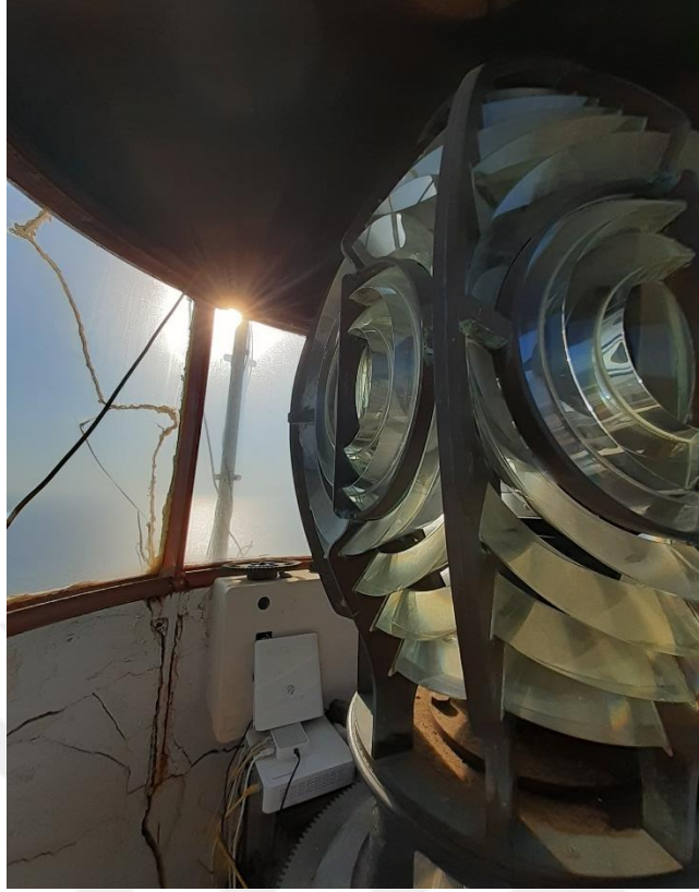
Şekil D. 35 : Fener katı ve fener lenslerini gösterir fotoğraf.
