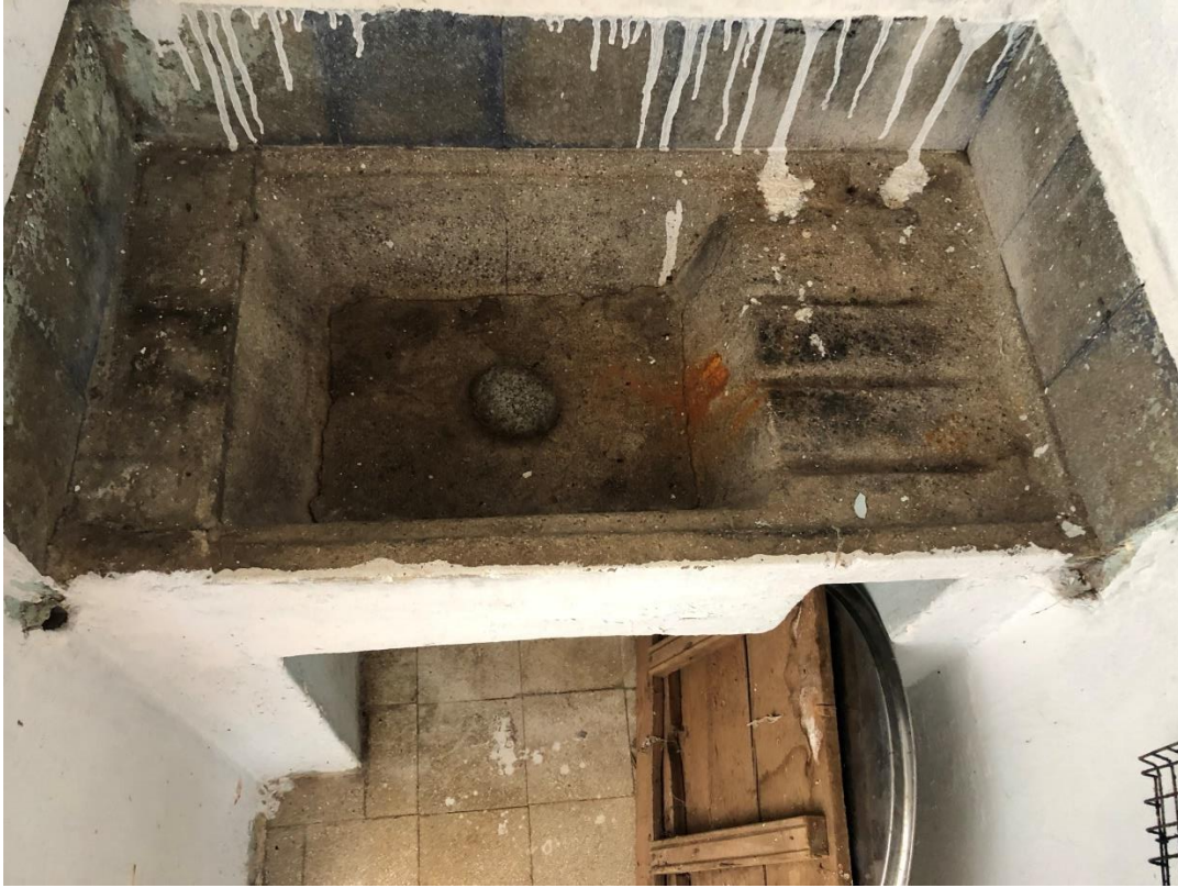
Şekil D. 16 : Mutfak içerisinde bulunan dökme mozaik eviye.
