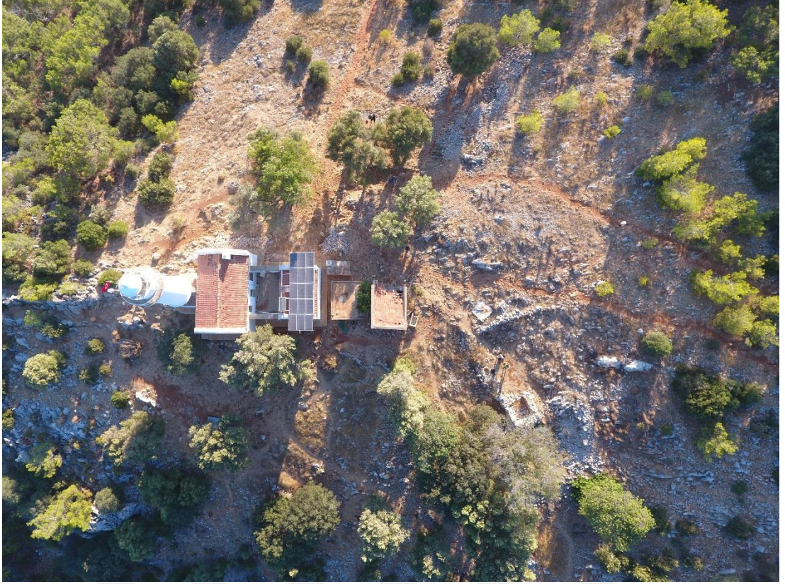
Şekil D. 1 : Deniz feneri ve çevre yapıları içeren drone fotoğrafı.
