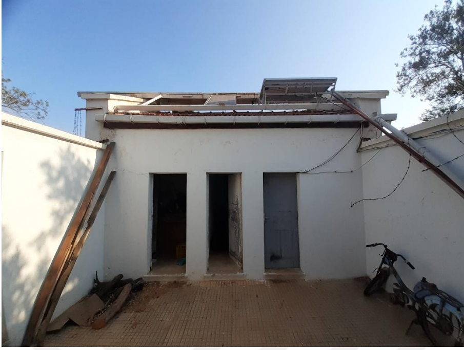
Şekil D. 11 : Avlu kuzey cephesinde bulunan mekanlar.
