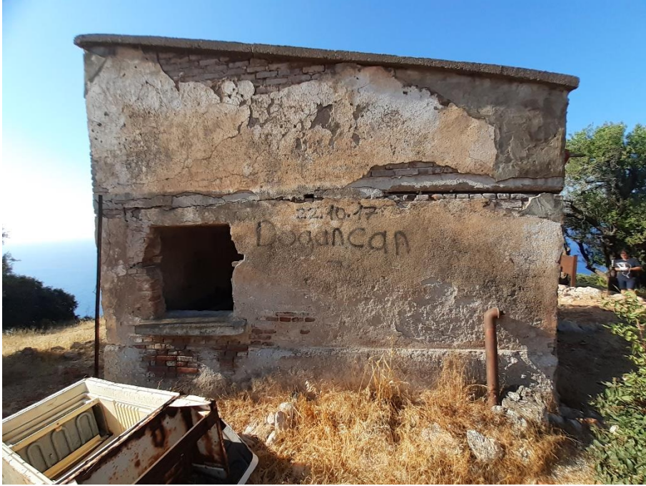
Şekil D. 40 : Ahrır yapısı kuzey cephesi.
