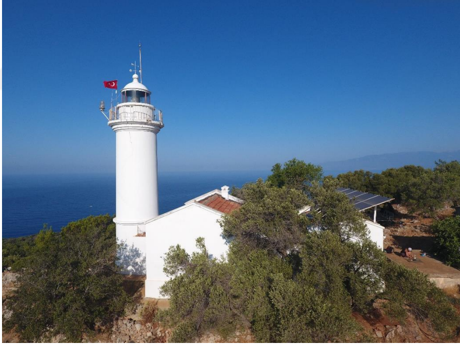
Şekil D. 50 : Fener doğu cephesi görünüşü.
