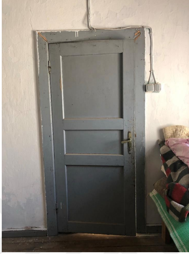
Şekil D. 21 : G05 numaralı mekan kapısı (iç görünüş).
