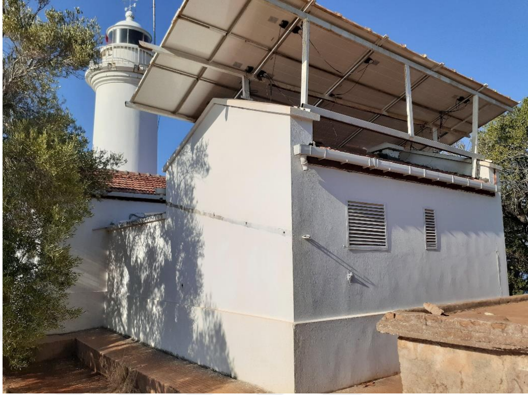
Şekil D. 45 : Yapıya kuzeydoğu tarafından bakış.
