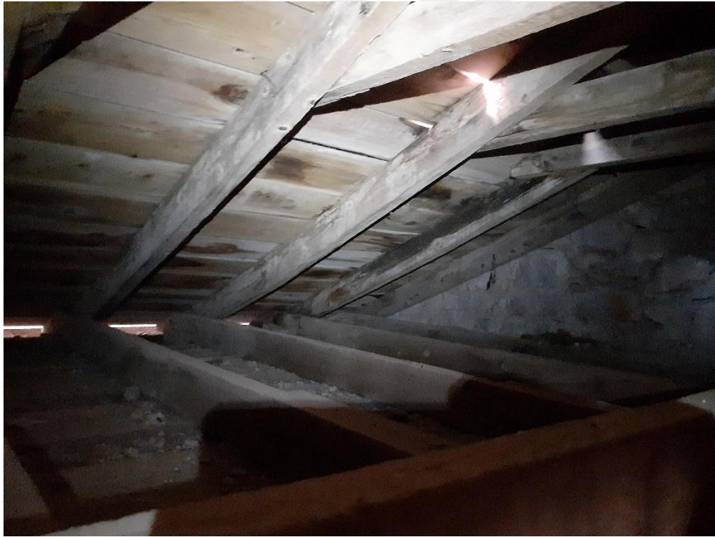
Şekil D. 18 : Mutfak tavanındaki açıklıktan erişilen tavan arası.
