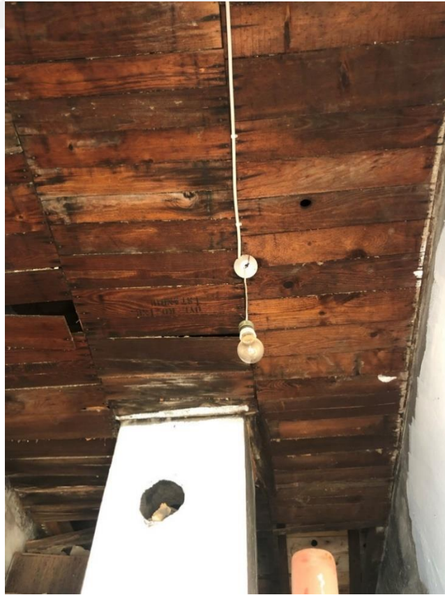
Şekil D. 26 : G07 numaralı mahalın muhdes tavan kaplaması.
