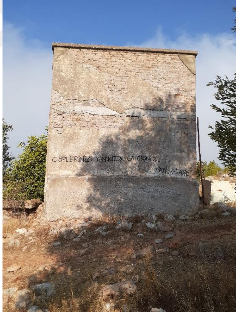
Şekil D. 42 : Ahır yapısı doğu cephesi.
