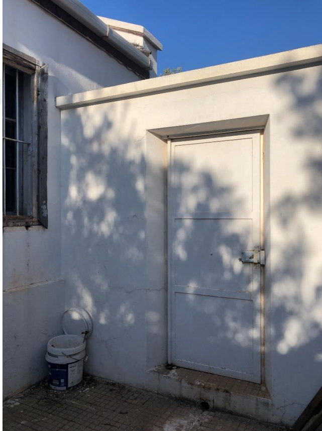
Şekil D. 12 : Avluya girişı saęlayan kapının iç görünüşü.
