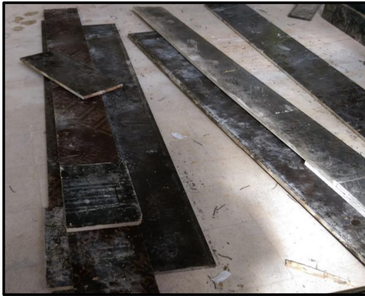
Şekil 2.22. Plywood kalıpların ölçülere uygun kesilmesi (1/1 ölçekli deney)
