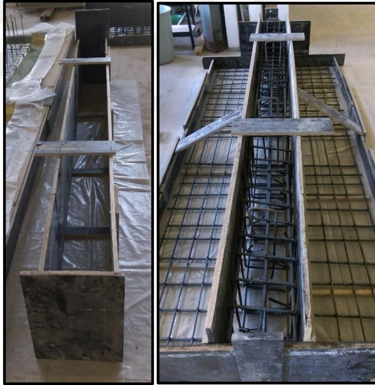
Şekil 2.29. Deney numunelerinin beton dökümüne hazır hale getirilmesi (1/1 ölçekli deney)
