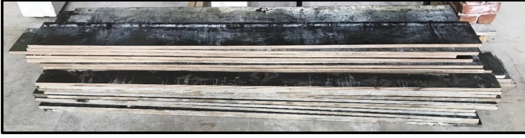
Şekil 2.34. Plywood kalıpların ölçülere uygun kesilmesi (1/2 ölçekli deney)
