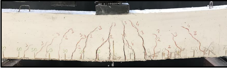
Şekil 3.43. B1-2 kirişinin detaylı çatlak dağılımı
