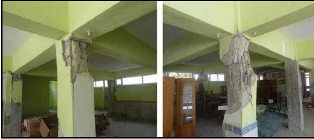
Şekil 1.12. Kuvvetli kiriş-zayıf kolon riski (Doğangün, Ural, Sezen, Güney ve Fırat, 2013)
