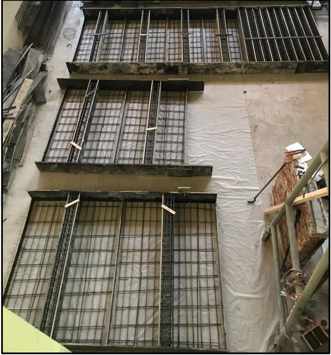
Şekil 2.39. Deney numunelerinin beton dökümüne hazır hale getirilmesi-2 (1/2 ölçekli deney)
