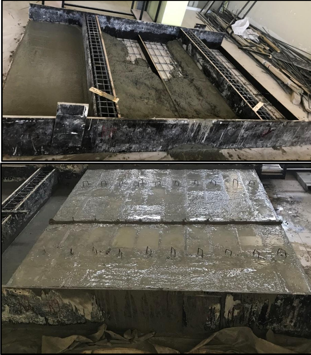
Şekil 2.40. Deney numunelerinin beton dökümünün yapılması (1/2 ölçekli deney)
