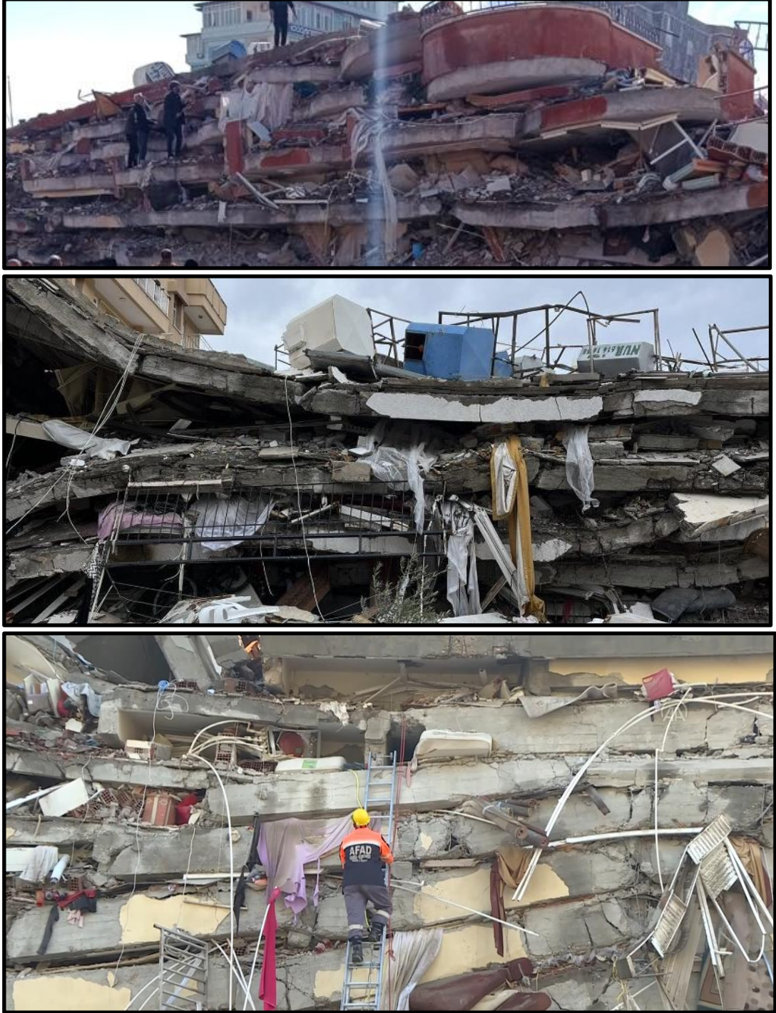
Şekil 1.5. 6 Şubat 2023 Kahramanmaraş Pazarcık ve Elbistan depremlerinde kuvvetli kiriş-zayıf kolon tasarımından kaynaklı yıkımlar
