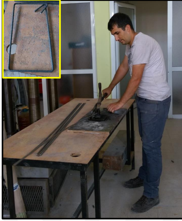
Şekil 2.26. Etriyelerin hazırlanması (1/1 ölçekli deney)
