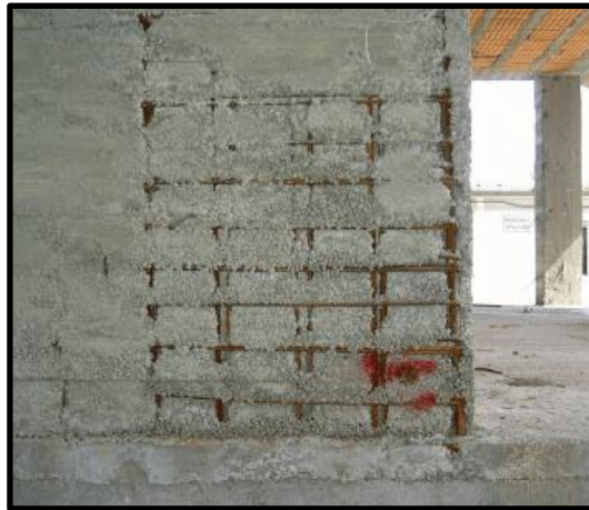
řekil 1.11. Birleřim blgelerinde segregasyona baęlı oluřan donatı korozyonu (Turkchem, 2021)
