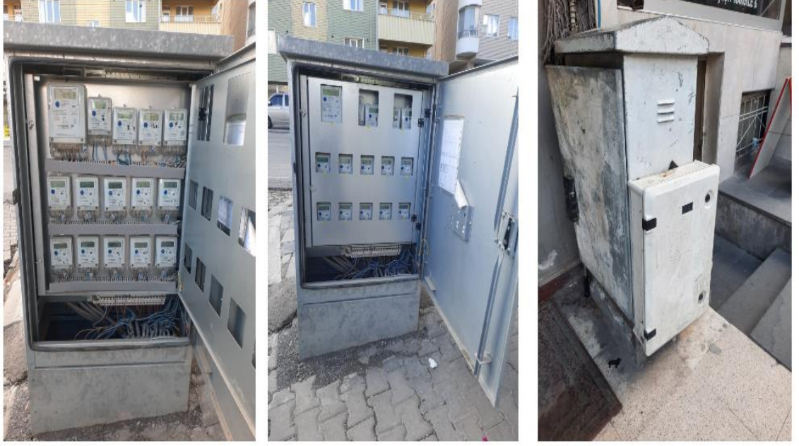
Şekil 3.4. Box panoya sayaç montajı
