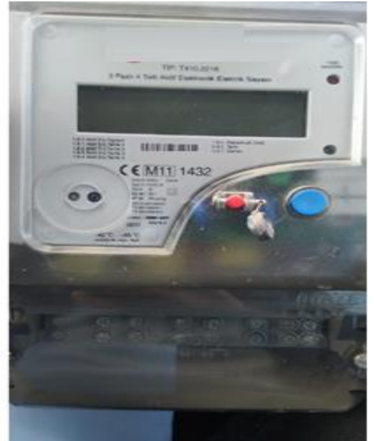
Şekil 3.14. Radyo frekans ile kumanda sistemi yöntemiyle kaçak kullanım
