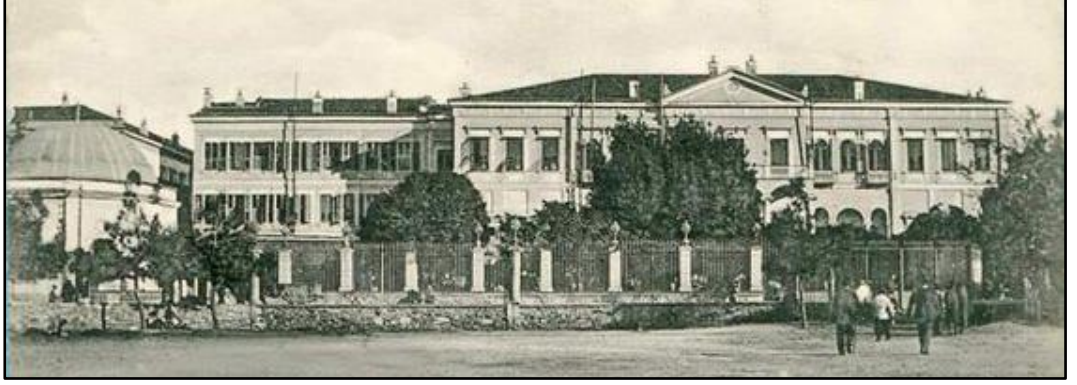
Şekil 3.3. Voyvoda Konağı (Hükümet Konağı) (Pinterest, 2023).
