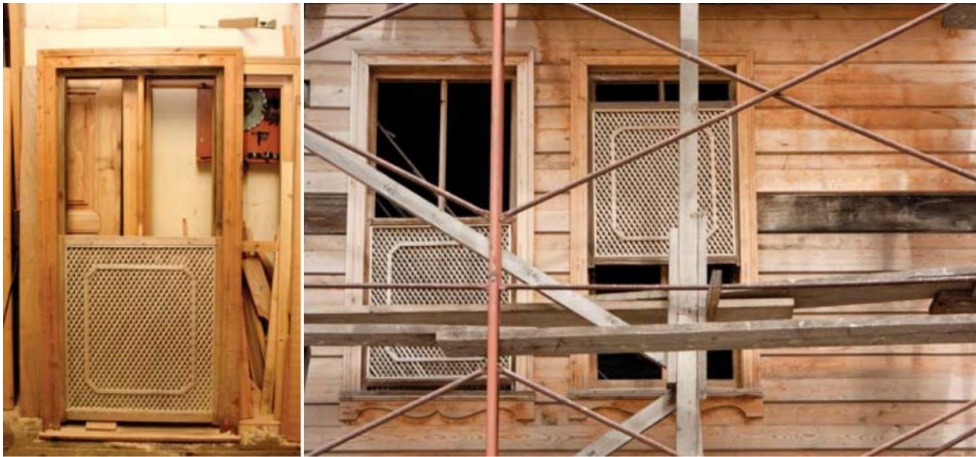
Şekil 2. 29 : Onarımı bitmiş atölyedeki pencere ve kafesi (sol), onarım sonrası yerine monte edilmiş pencereler (sağ) (Köroğlu & Kudde, 2013).
