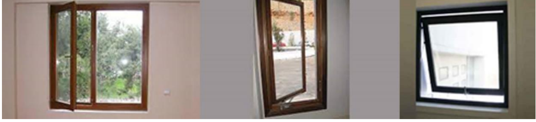
Şekil 2. 8: Fransız tipi (solda), İngiliz tipi (ortada), vasistas (sağda)
