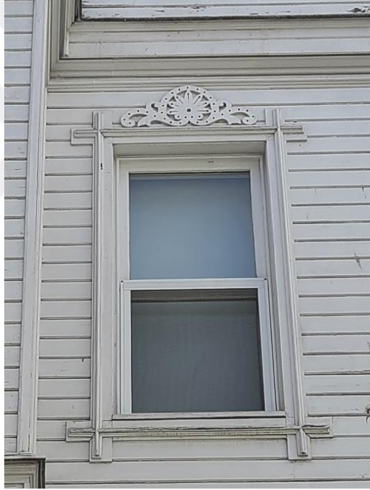
Şekil 4. 22: Örneklem giyotin pencere örneği, Dubaracı Sokak no 13 / Arnavutköy
