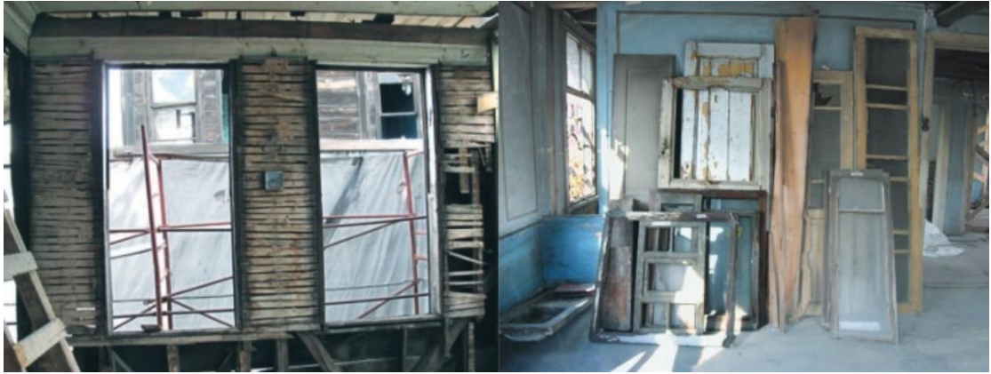
Şekil 2. 28 : Sökülme sonrası pencere boşlukları (sol), onarıma için toplanmış mimari öğeler (sağ) (Köroğlu & Kudde, 2010).
