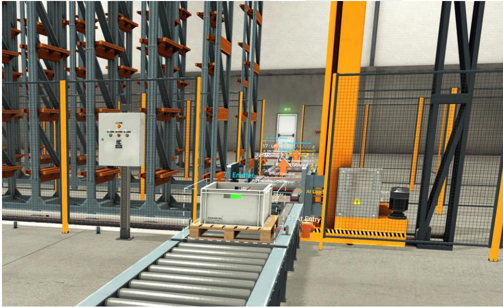
Şekil 45 Factory IO Simülasyon temsili Warehouse
