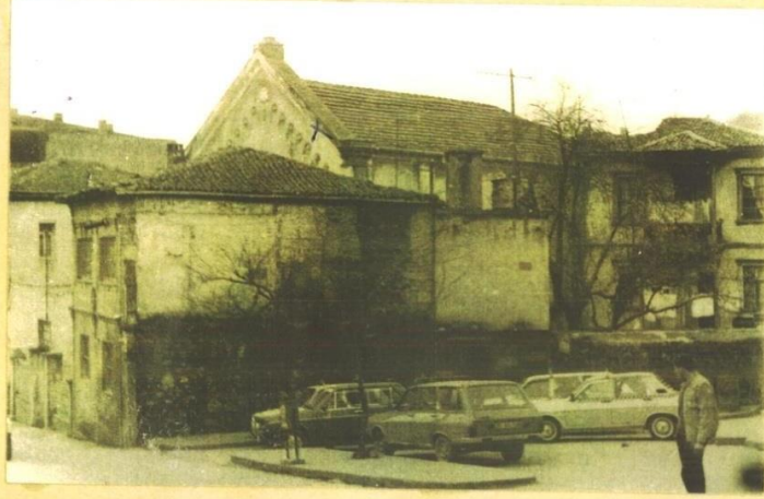
Fot.7- Fevzipaşa Caddesinden kilisenin kuzeybatısının görüntüsü
