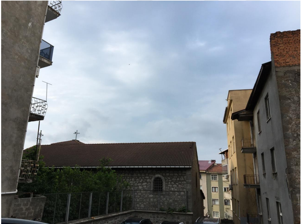
Görsel 11. Trabzon Santa Maria Katolik Kilisesi Güney Cephe
