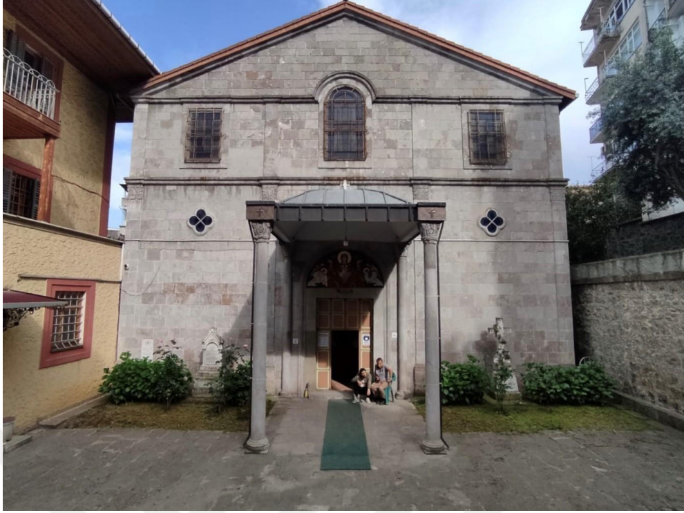
Görsel 16. Trabzon Santa Maria Katolik Kilisesi Batı Cephe
