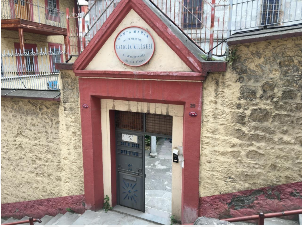
Görsel 10. Trabzon Santa Maria Katolik Kilisesi Bahçe Kapısı
