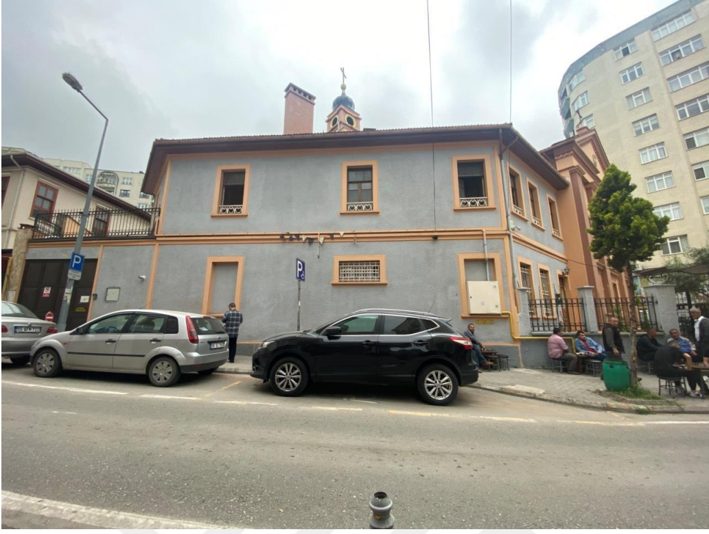
Görsel 72. Samsun Mater Dolorosa Katolik Kilisesi Doğu Cephe (Ek Bina)
