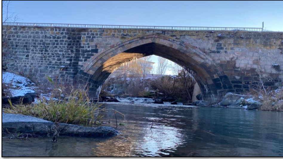
Fotoğraf 3. 10. Malazgirt (Hatun) Köprüsü Mansap Görünüşü
