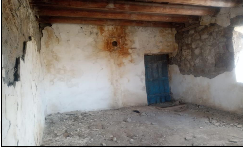
Fotoğraf 5. 1. Tarihi Malazgirt Evlerinde Kesme Bazalt Taşları, Toprak Zemin ve Toprak Tavanı Taşıyıcı Kerestelerden Görünüm (Nurettin Köyü)
