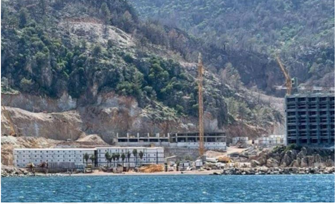
Şekil 3.13. Milli park sınırları içinde bulunan otel inşaatı (Cumhuriyet, 2022)
