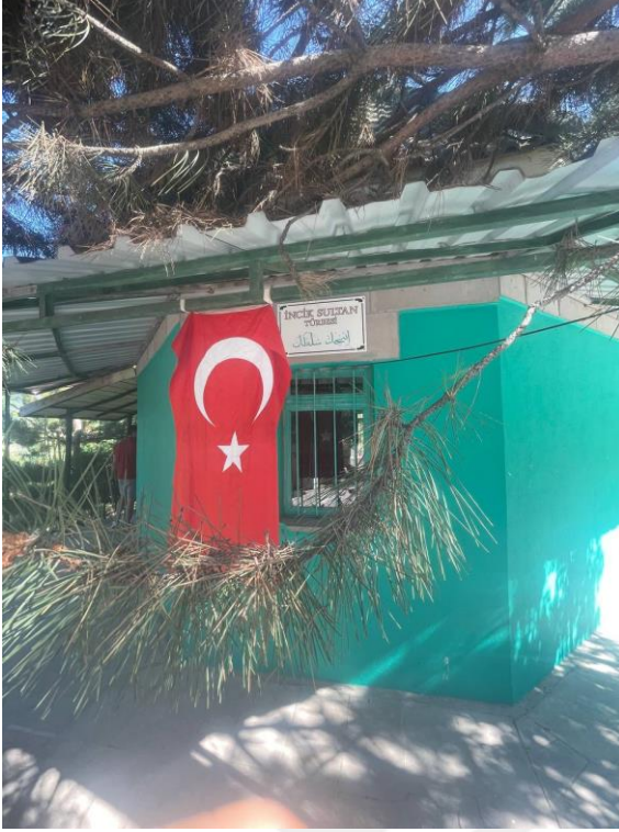
Ek-1.17. İncik Sultan Türbesi / Çamlıdere
