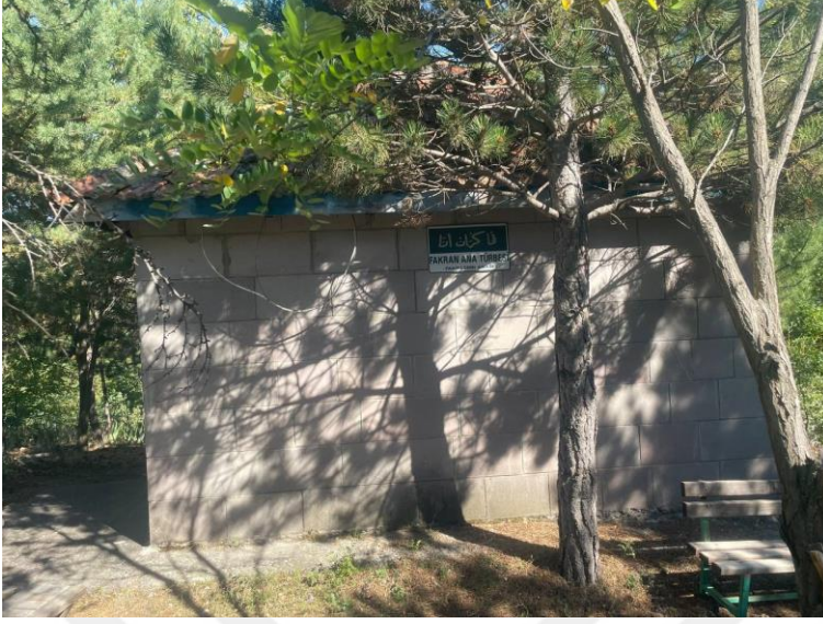
Ek-1.13. Fakran Ana Türbesi / Çamlıdere
