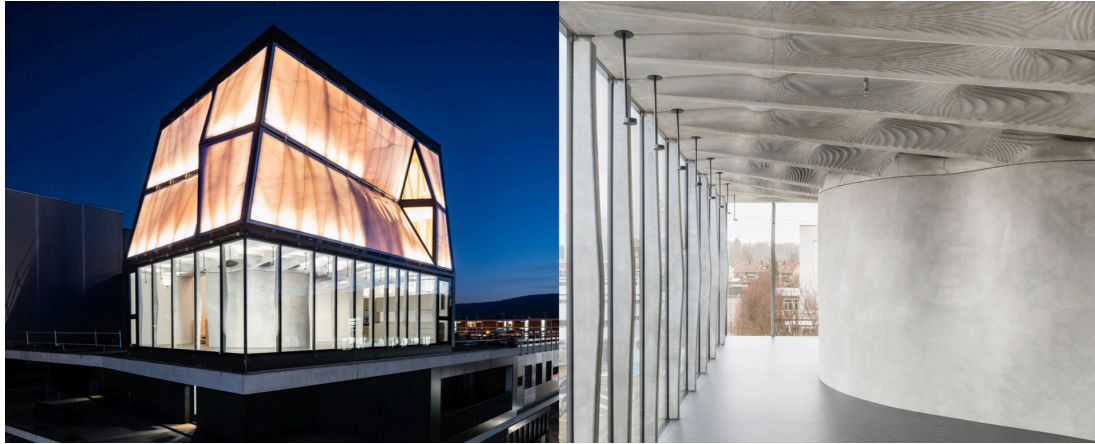
Şekil 2.7: Sol, DFAB HOUSE gece görünüşü. Fotoğraf, Roman Keller. Sağ, DFAB HOUSE iç mekan, serbest biçimli kalıp duvarlar akıllı döşemeyi destekliyor. Fotoğraf, Roman Keller. (URL-18)
