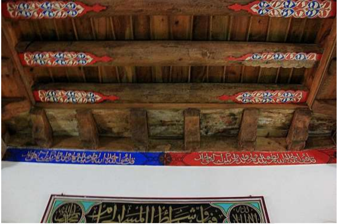
Fotoğraf 4.71.1. Beyşehir Köşk Köyü Mescidi Kirişi
