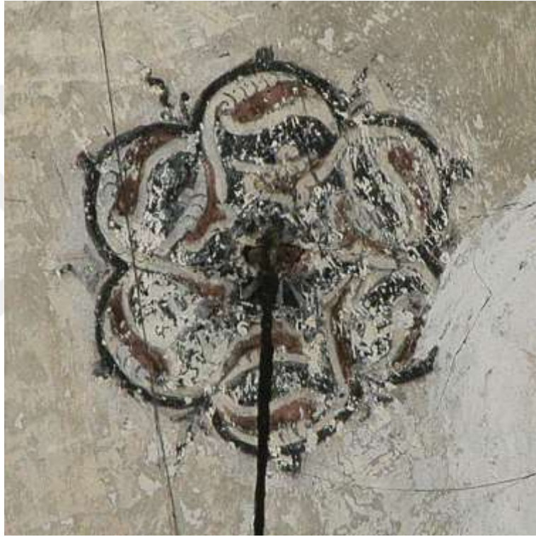
Fotoğraf 4.79. Rüstem Paşa Türbe Kubbesi / Detay
