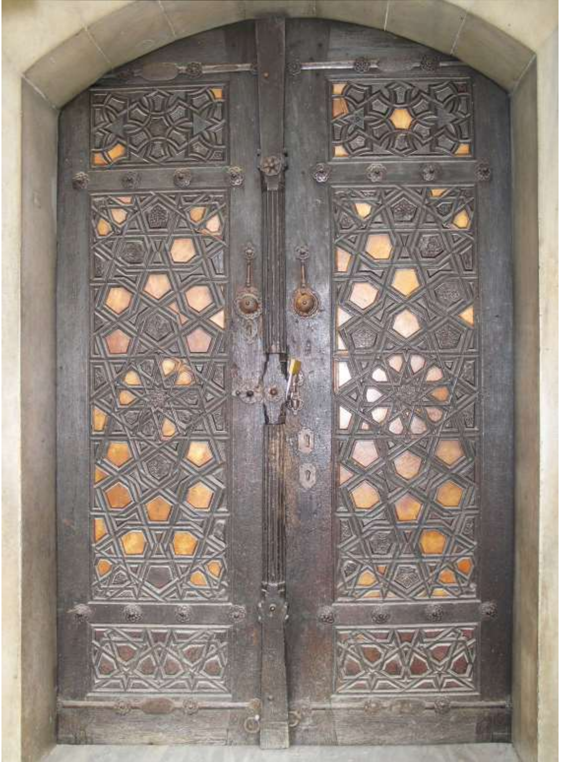
Fotoğraf 4.9.1.Cem Sultan Türbe Kapı Kanadı / Genel
