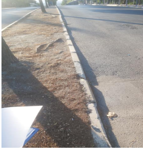
Şekil 4.14 Refüj A Bölüm 2 Y doğrultusuna ait görüntü
