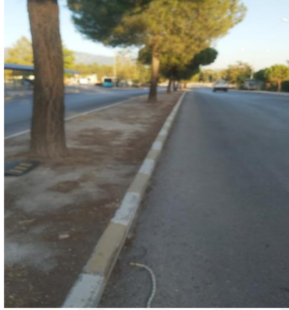
Şekil 4.18 Refüj A Bölüm 3 Y doğrultusuna ait görüntü
