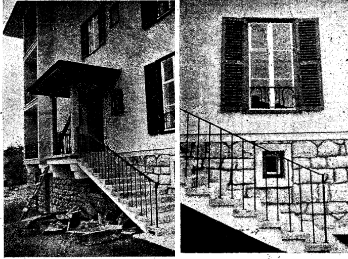
Şekil 6.1 : Kavaklıdere'deki apartmanın giriş bölümü (Kavaklıdere'de bir apartman, 1949).
