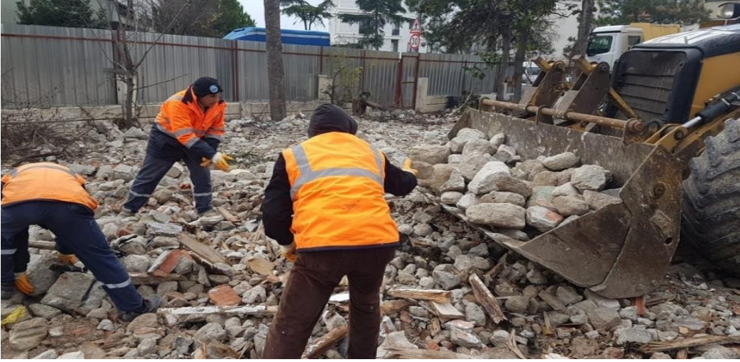
Şekil 4.4 İnşaat yıkıntı atıklarının el ile ayrıştırılması
