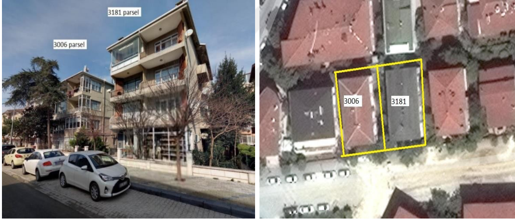
Şekil 4.2 5 MPa Dayanıma Sahip Yapının Yıkım Öncesi
