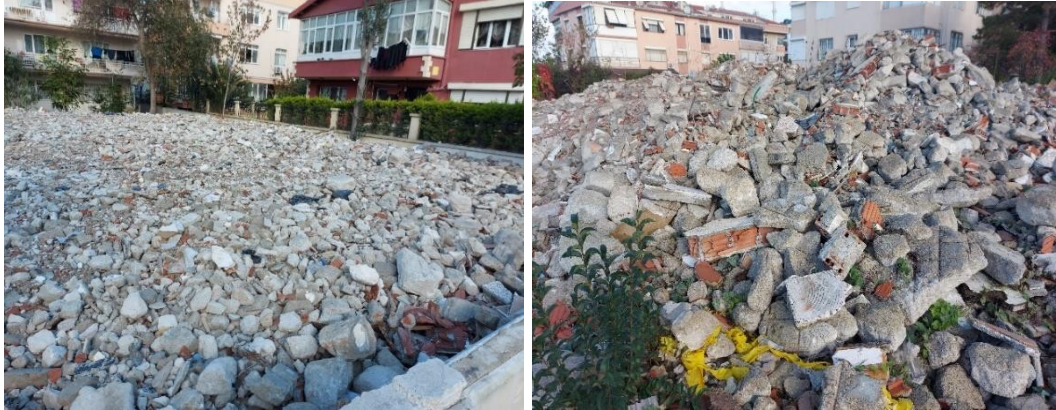
Şekil 4.3 5 MPa dayanıma sahip yapının yıkım sonrasındaki inşaat atıkları
