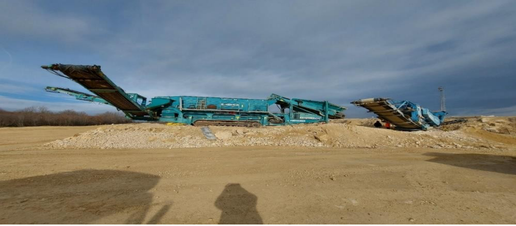
Şekil 4.5 İnşaat yıkıntı atıklarının kırılması işlemi
