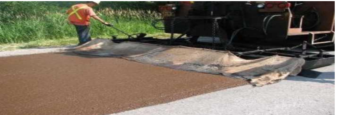
Şekil 13. Örtme tabakası uygulaması
