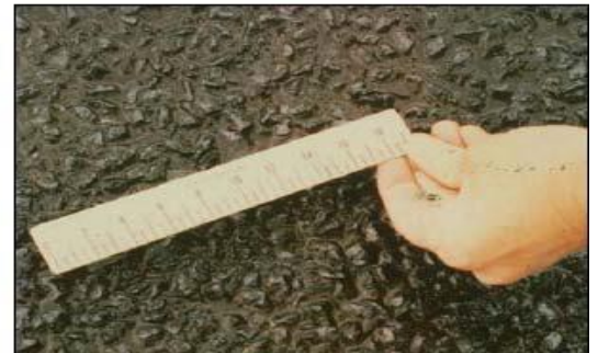
Şekil 10. Karartma tabakası uygulama öncesi ve sonrası yol yüzeyi
