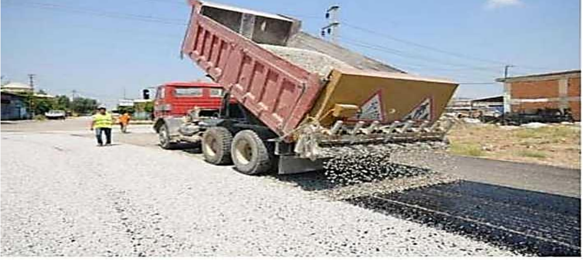
Şekil 8. Sathi kaplama yapımı
