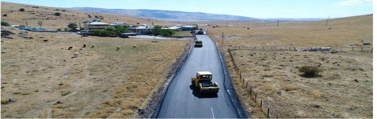
Şekil 17. Bitümlü Sıcak Karışım Silindiraj Uygulaması
