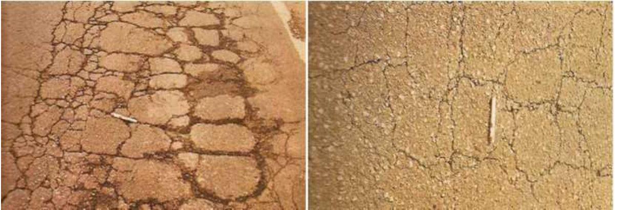
Şekil 24. Farklı şiddetlerde yorulma çatlakları
