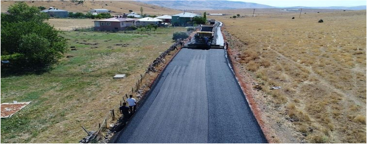
Şekil 16. Bitümlü Sıcak Karışımın Finişer ile Serimi
