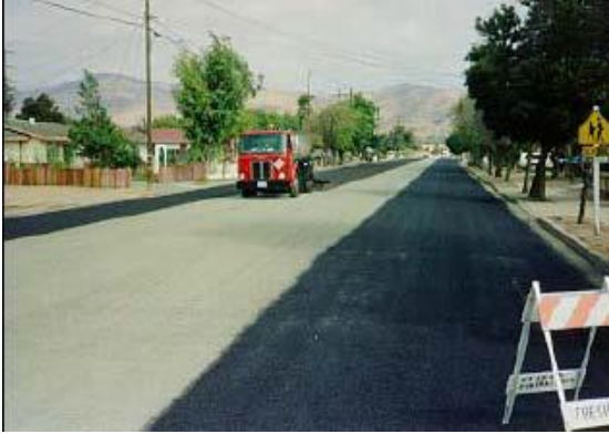
Şekil 9. Uygun yüzey üzerine karartma tabakası uygulaması
