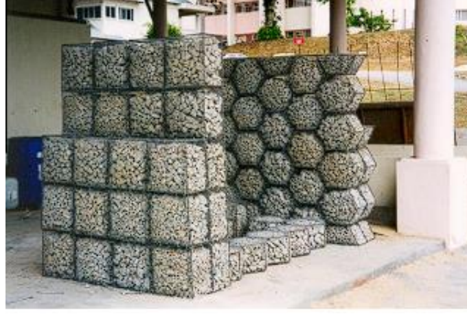
Şekil 8. Farklı tiplerde inşa edilmiş sandık tipi istinat yapıları (Ramli, Karasu ve Dawood, 2013).
