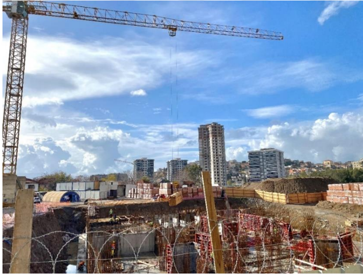
Şekil 4.18. Örnekköy Mahallesi kentsel dönüşüm projesi 3. etap inşaatı
