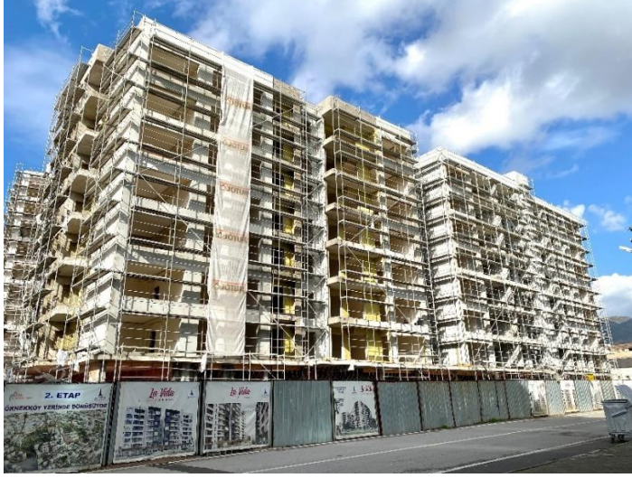
Şekil 4.17. Örnekköy Mahallesi kentsel dönüşüm projesi 2. etap inşaatı
