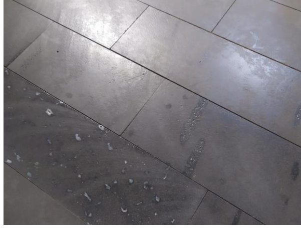
Şekil 50. Doğal taş (bazalt) zemin malzemesi
