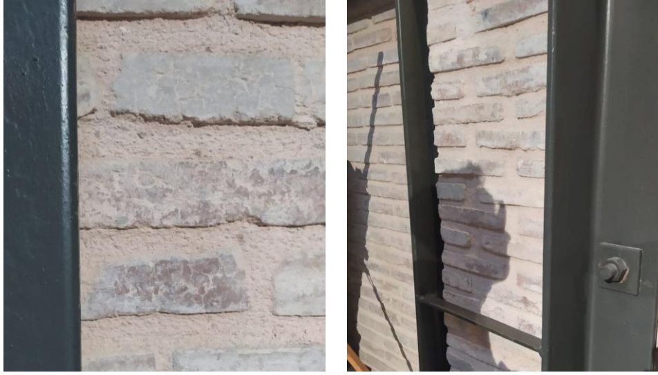
Şekil 48. Tuğla duvar ve konstrüksiyon
