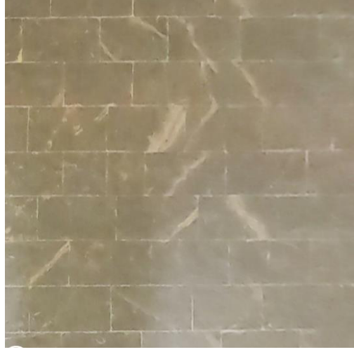
Şekil 75. Martyrion bölümü zemin doğal taş malzemesi
