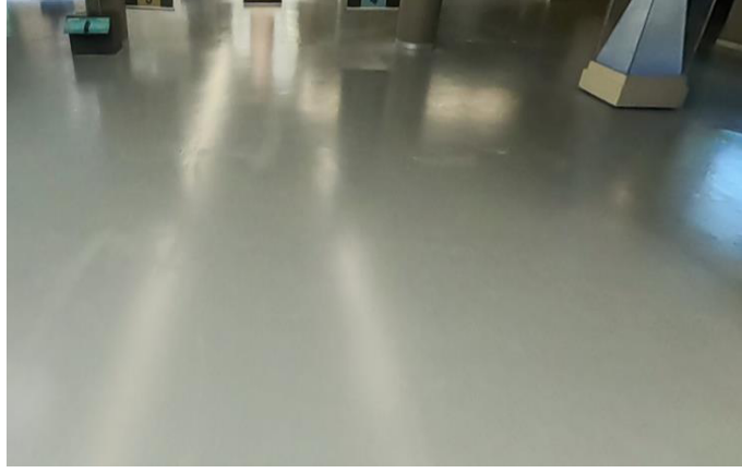
Şekil 68. Sergileme alanı epoksi zemin malzemesi
