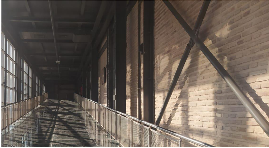
Şekil 49. Tuğla duvar ve konstrüksiyon
