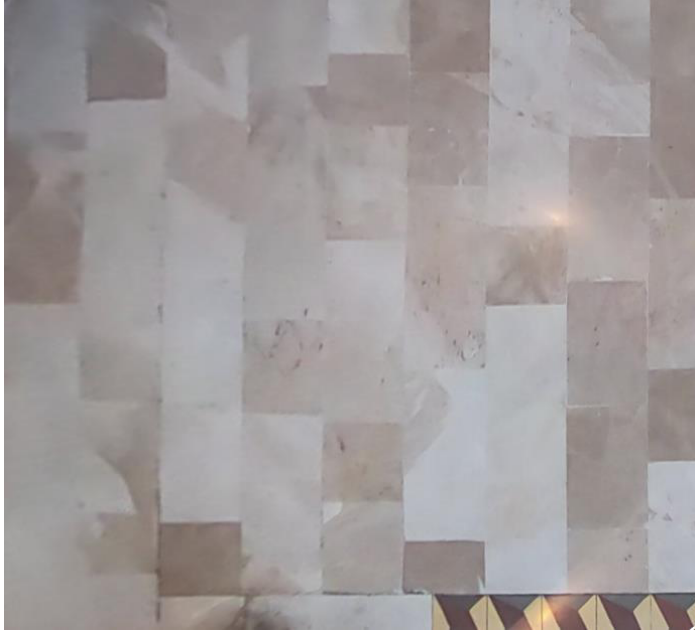
Şekil 62. Giriş bölümü doğal taş zemin malzemesi
