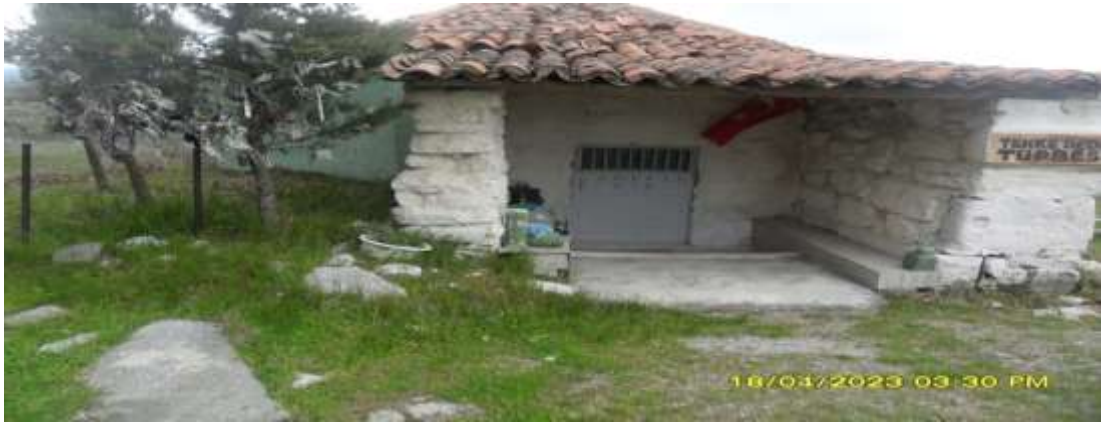
Fotograf. 96 Çoban Dede / Tekke Dede Türbesi- Güneşli – (Bergama)
