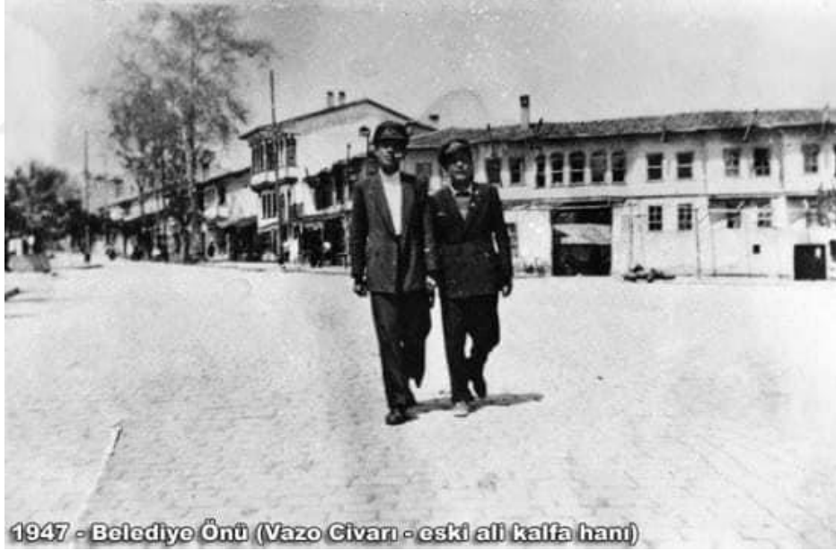
Şekil 4.38 1947 belediye önü vazo civarı (Kütahya Belediyesi Arşivi)
