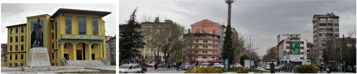
Şekil 4.32 Valilik binası ve meydanı çevreleyen yapılar (2021)
