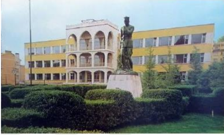
Şekil 4.37 1958 Belediye Binası (Kütahya Belediyesi Arşivi)
