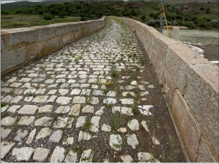
Resim 4.24. Köprü Döşemesinde Kullanılan Arnavut Kaldırım Taşı (Kaya Kişisel Fotoğraf Arşivi, 2023)
