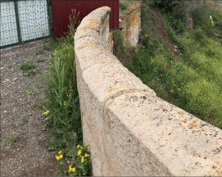
Resim 4.16. Köprü Korkuluk Detay Fotoğrafı (Kaya Kişisel Fotoğraf Arşivi, 2023)
