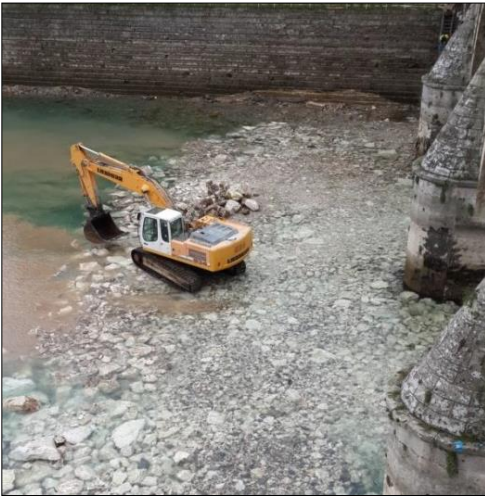
Resim 4.66. Köprülerde Yapılan Tahkimat İşlemi (Kaya Kişisel Fotoğraf Arşivi, 2013)
