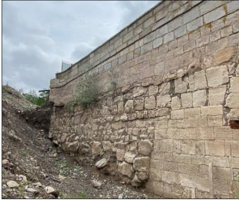
Resim 4.52. Develioğlu Köprüsü Tempan Duvarı Farklı Duvar Örgü Dizilişleri (Kaya Kişisel Fotoğraf Arşivi, 2023)
