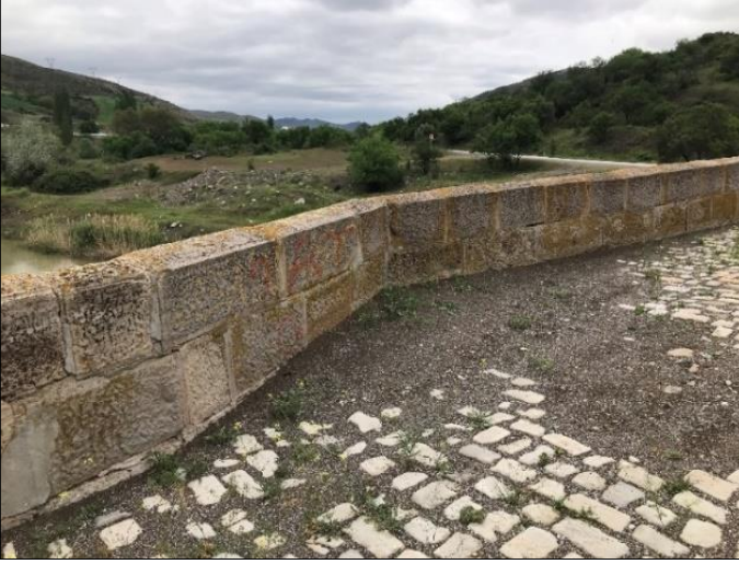
Resim 4.22. Köprü Döşemesinde Kullanılan Arnavut Kaldırım Taşı (Kaya Kişisel Fotoğraf Arşivi, 2023)
