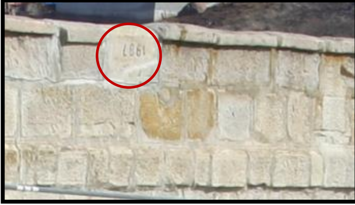
Resim 4.35. 1987 Yılı Onarımı Sonrası Köprü Korkulukları Arasında Yer Alan Taş Bloğu (KGM Arşivi, Dilaver, 2012:75)
