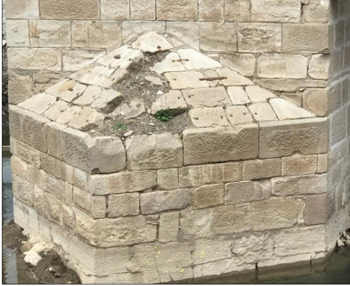
Resim 4.44. Selyaranda Görülen Taş ve Derz Malzeme Kayıpları (Kaya Kişisel Fotoğraf Arşivi, 2023)
