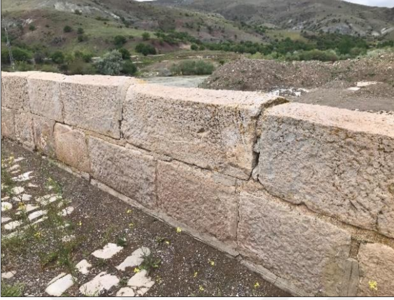
Resim 4.15. Köprü Korkuluk Detay Fotoğrafı (Kaya Kişisel Fotoğraf Arşivi, 2023)
