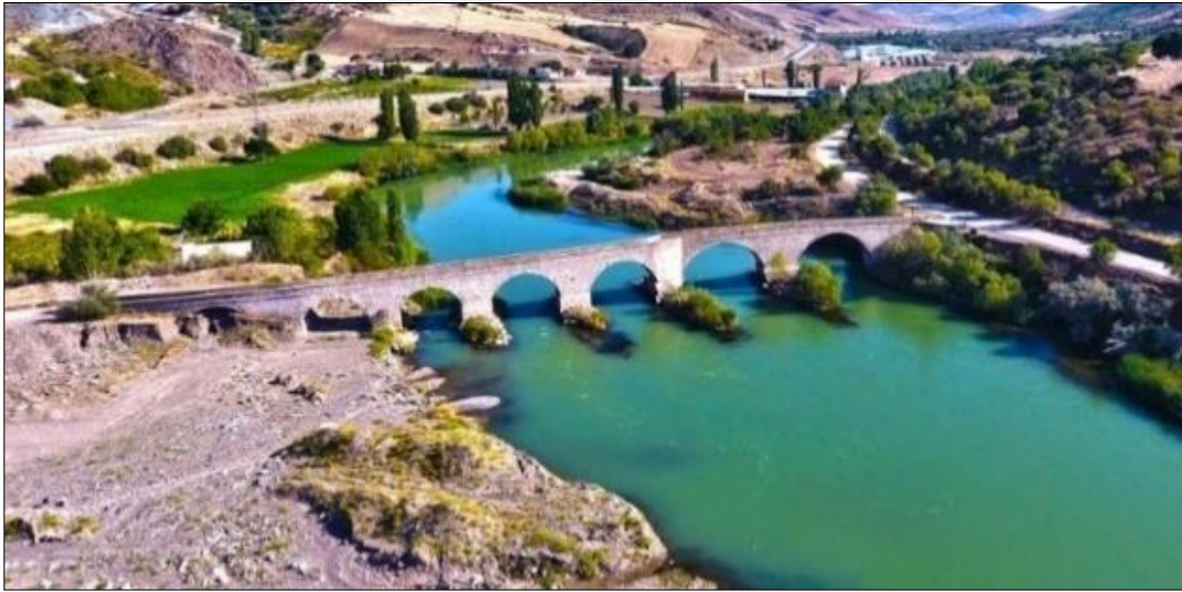
Resim 4.1. Develioğlu Köprüsü Fotoğrafi (URL-9)
