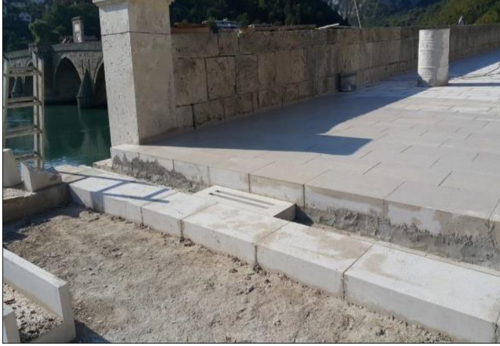
Resim 2.5. Drina Köprüsü (Visegrad-Bosna Hersek) Çörten İçin Oluk Detayı (Kaya Kişisel Fotoğraf Arşivi, 2014)
