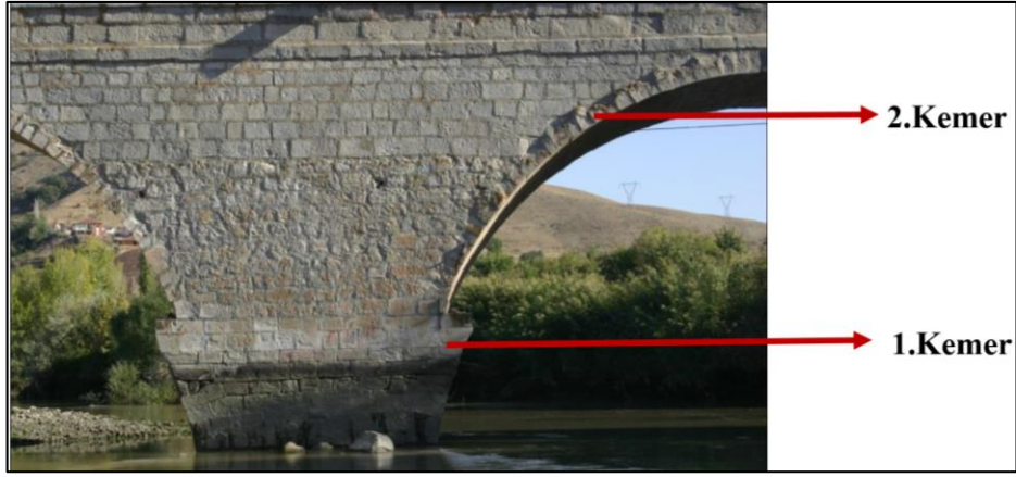
Resim 4.25. Köprü Ayaklarında Uygulanan Kemer Formunda Taş Dizilimi (KGM Arşivi, Dilaver, 2012:53)
