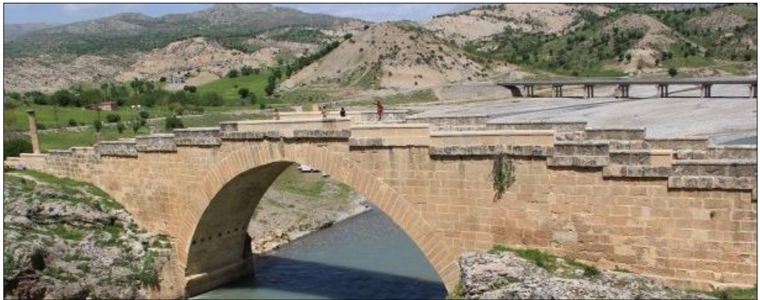
Resim 2.2. Cendere Köprüsü (Adıyaman) Tempan Duvarı- Korkuluk-Korniş Örneği (URL-1)
