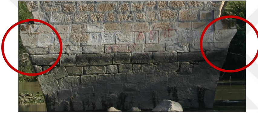
Resim 4.26. Köprü Ayaklarında Uygulanan Kemer Formunda Taş Dizilimi (KGM Arşivi, Dilaver, 2012:54)
