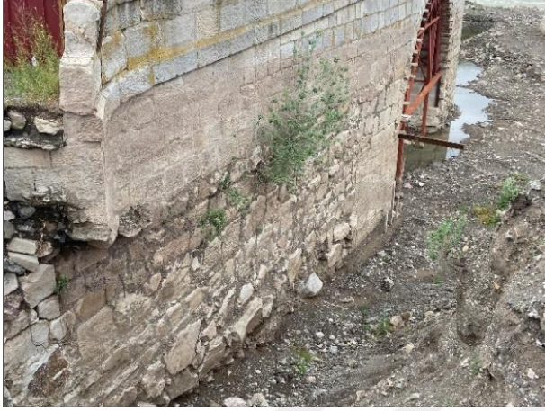
Resim 4.59. Köprü'nün Tempan Duvarında Görülen Bitkisel Oluşumlar (Kaya Kişisel Fotoğraf Arşivi, 2023)
