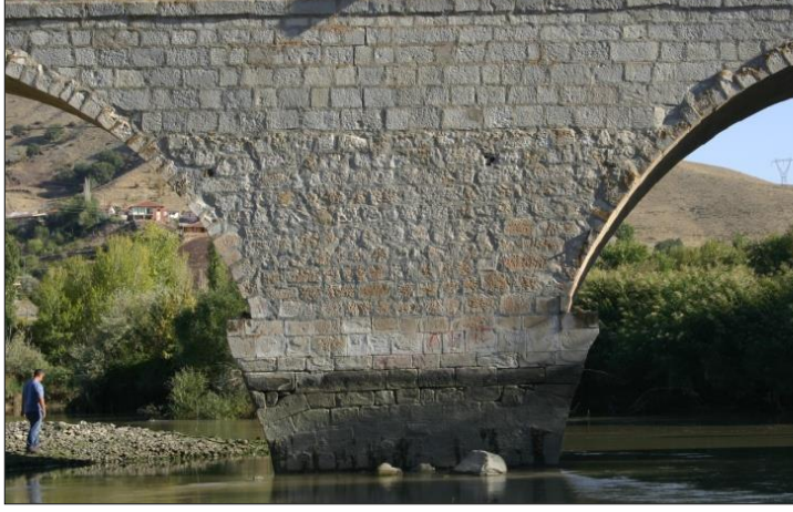
Resim 4.10. Mansap Yönü Köprü Kemer Ön Görünüşü (KGM Arşivi, Dilaver, 2012:53)
