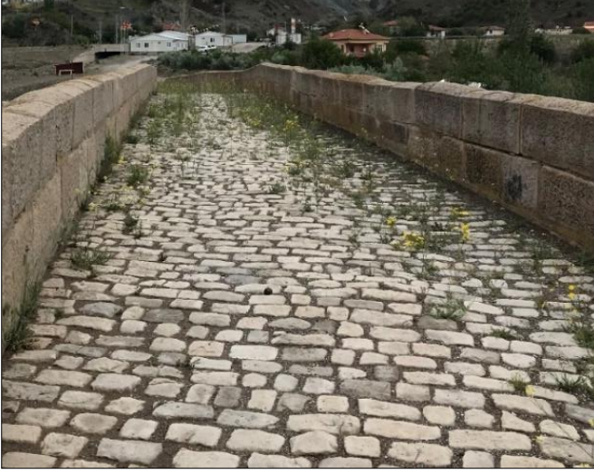
Resim 4.21. Köprü Döşemesinde Kullanılan Arnavut Kaldırım Taşı (Kaya Kişisel Fotoğraf Arşivi, 2023)
