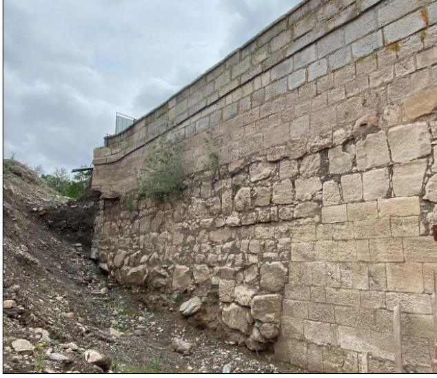
Resim 4.17. Tempan Duvarı Farklı Dönemlere Ait Taş Dizilişi (Kaya Kişisel Fotoğraf Arşivi, 2023)
