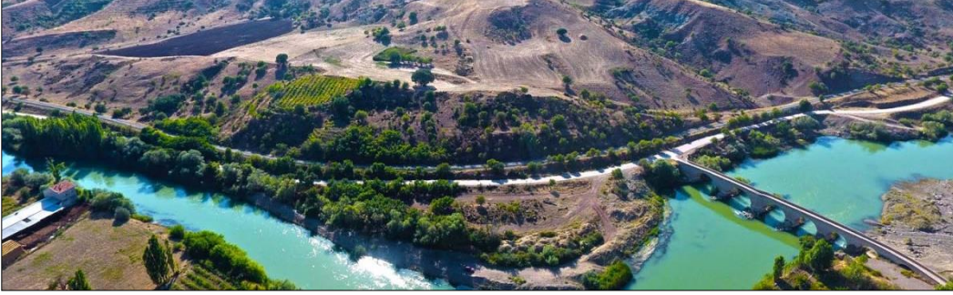
Resim 4.5. Kalecik Develioğlu Köprüsü Kuşbakışı Görünüm (URL-10)
