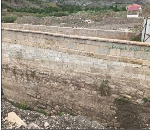
Resim 4.50. Develioğlu Köprüsü Tempan Duvarı Farklı Duvar Örgü Dizilişleri (Kaya Kişisel Fotoğraf Arşivi, 2023)
