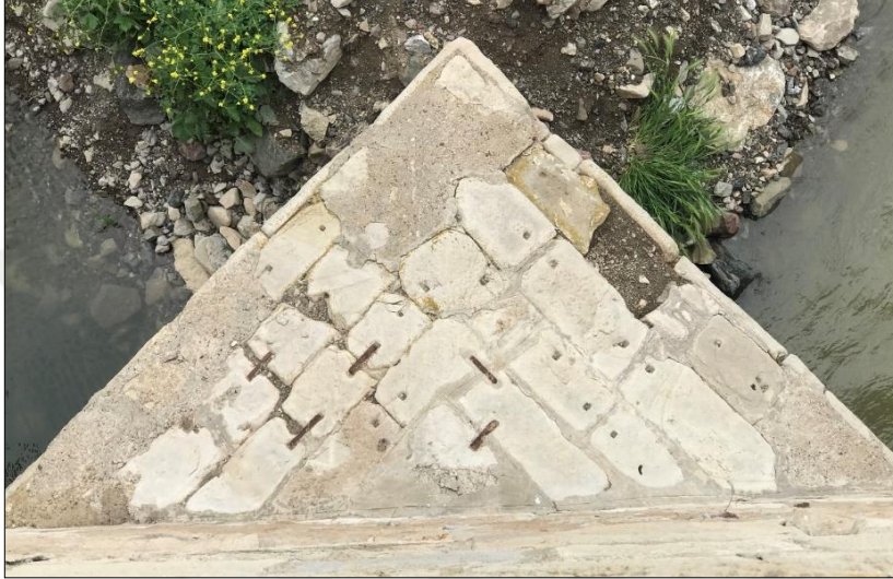
Resim 4.58. Köprü Selyaranlarında Yer Alan Taşları Bağlayan Demir Kenetler (Kaya Kişisel Fotoğraf Arşivi, 2023)
