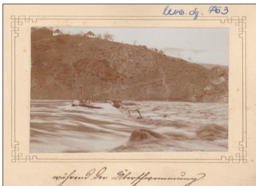
Resim 4.48. 1873 Yılında Meydana Gelen Sel Baskınında Drina Köprüsünün Hasarlı Durumu (Vişegrad-Bosna Hersek Belediye Arşivi, 2015)
