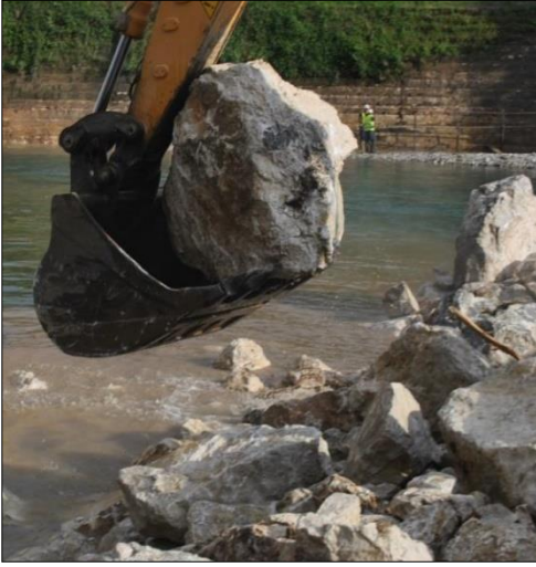
Resim 4.65. Köprülerde Yapılan Tahkimat İşlemi (Kaya Kişisel Fotoğraf Arşivi, 2013)
