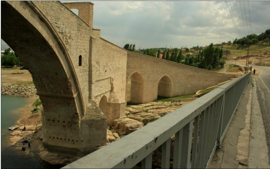
Resim 2.3. Tarihi Malabadi Köprüsü-Tempan Duvarı Korkuluk Örneği (KGM Arşivi, 2009:15)
