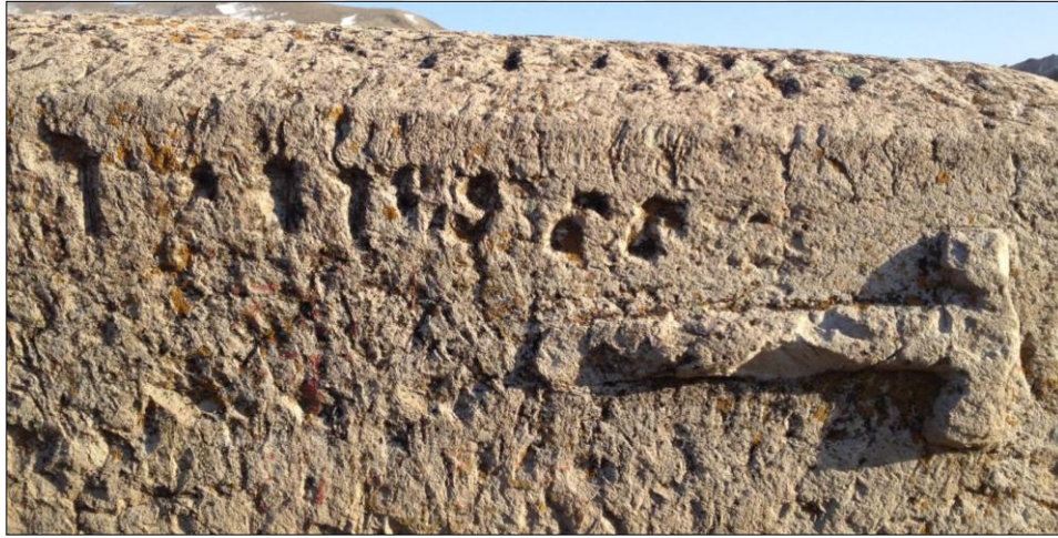
Resim 4.27. Köprü Korkuluk İç Yüzeyinde Bulunan Çekiç Formlu Kabartma (KGM Arşivi, Dilaver, 2012:59)
