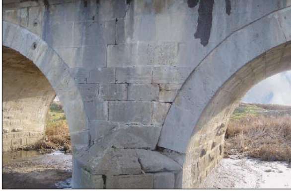
Resim 3.6. Uzunköprü Ayak Deformasyonu (Yüksel, 2009:66)
