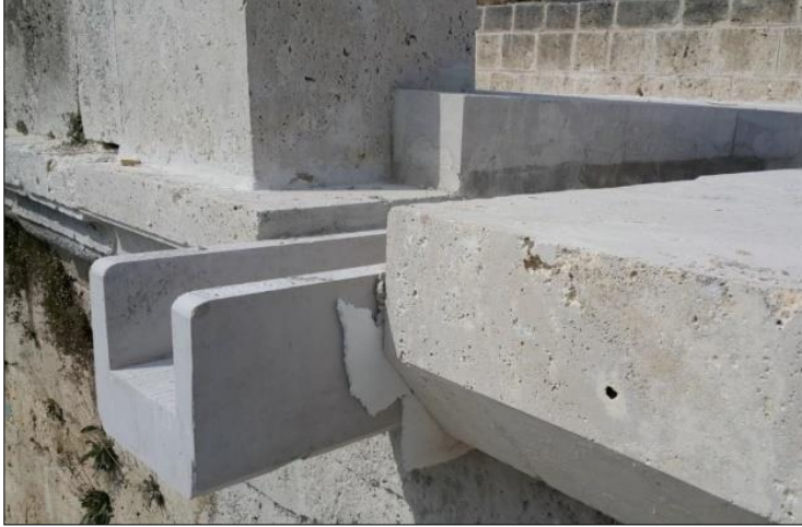
Resim 2.6. Drina Köprüsü (Visegrad-Bosna Hersek) Çörten Detayı (Kaya Kişisel Fotoğraf Arşivi, 2014)
