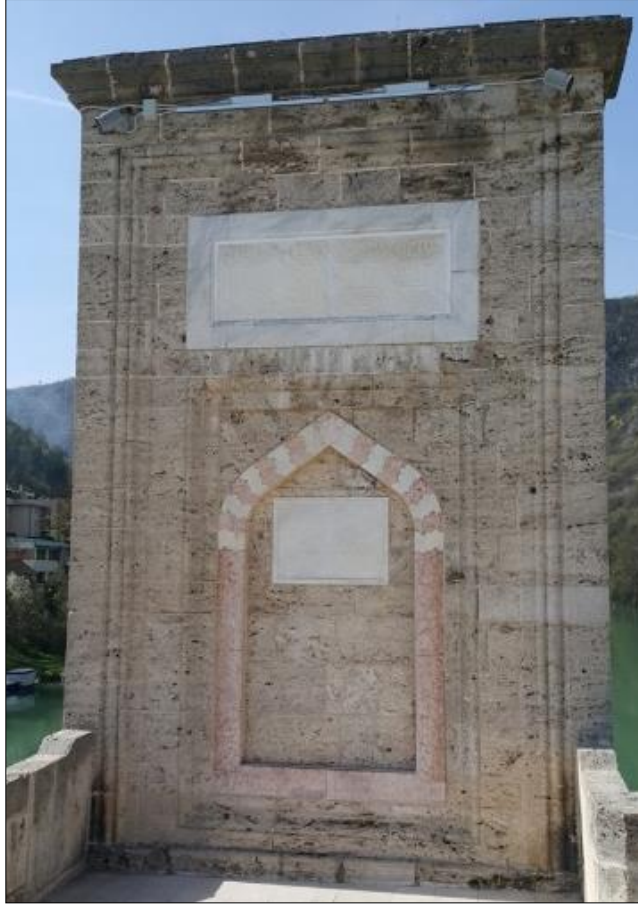
Resim 2.1. Drina Köprüsü Kitabe (KGM Arşivi, Drina Köprüsü Teknik Rapor, 2015:31)
