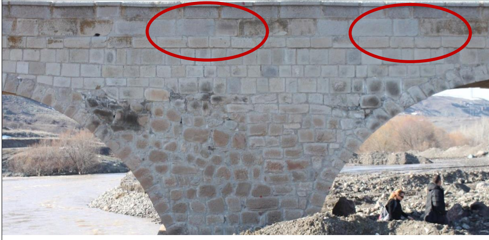
Resim 4.38. 1987 Yılında Yapılan Korkuluk Taşı Onarımları (KGM Arşivi, Dilaver, 2012:74)
