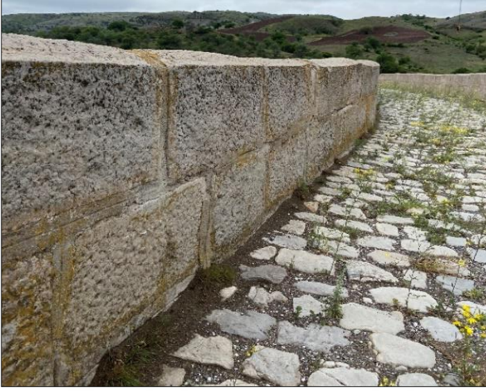
Resim 4.23. Köprü Döşemesinde Kullanılan Arnavut Kaldırım Taşı (Kaya Kişisel Fotoğraf Arşivi, 2023)
