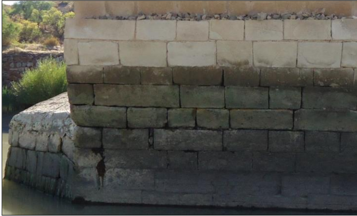
Resim 4.8. Selyaran Yan Görünüşü ve Kemer Karnı (KGM Arşivi, Dilaver, 2012:55)
