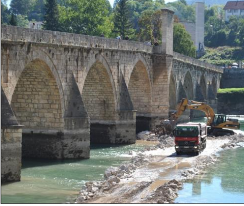
Resim 4.64. Köprülerde Tahkimat Öncesi Yapılan Derivasyon İşlemi (Kaya Kişisel Fotoğraf Arşivi, 2013)
