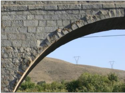
Resim 4.6. Köprünün Kemer Taşlarının Düzensiz Sıralanışı (KGM Arşivi, Dilaver, 2012:11)
