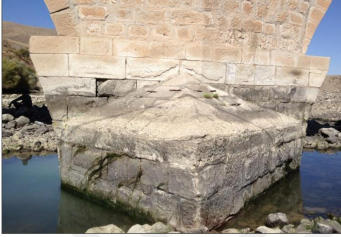
Resim 4.7. Selyaran Ön görünüşü Memba Yönü (KGM Arşivi, Dilaver, 2012:56)
