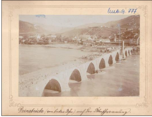
Resim 4.49. 1873 Yılında Meydana Gelen Sel Baskınında Drina Köprüsünün Hasarlı Durumu (Vişegrad-Bosna Hersek Belediye Arşivi, 2015)
