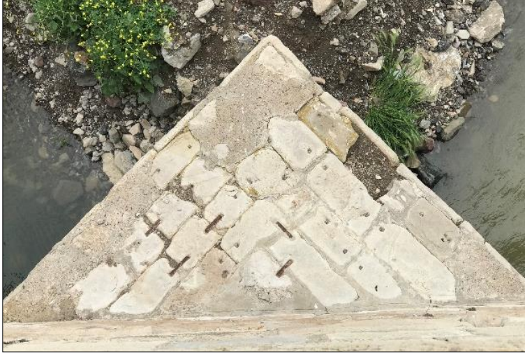
Resim 4.37. 1987 yılında yapılan Selyaran Külahlarnın Çimento Esaslı Tamir Harçları (Kaya Kişisel Fotoğraf Arşivi, 2023)
