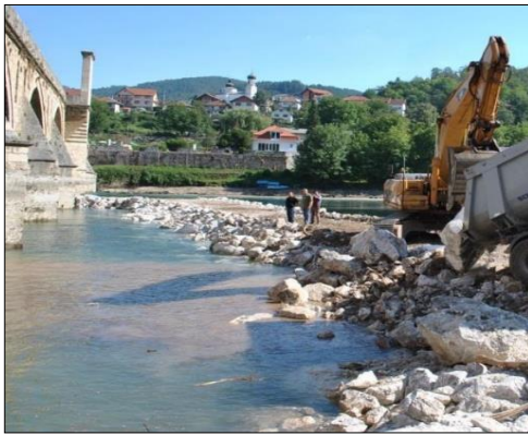
Resim 4.63. Köprülerde Tahkimat Öncesi Yapılan Derivasyon İşlemi (Kaya Kişisel Fotoğraf Arşivi, 2013)
