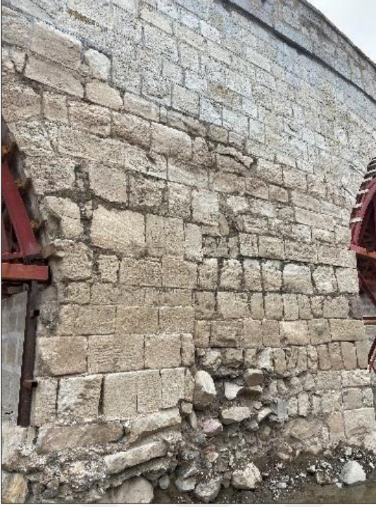
Resim 4.53. Develioğlu Köprüsü Tempan Duvarı Farklı Duvar Örgü Dizlişleri (Kaya Kişisel Fotoğraf Arşivi, 2023)
