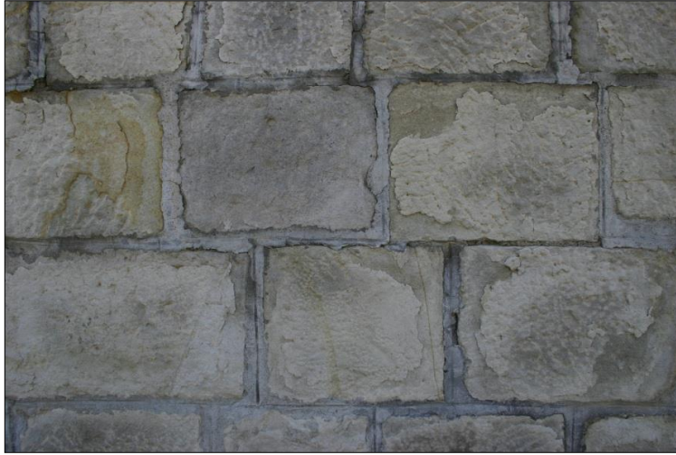
Resim 4.36. 1987 yılında yapılan Derz Onarımları (KGM Arşivi, Dilaver, 2012:77)
