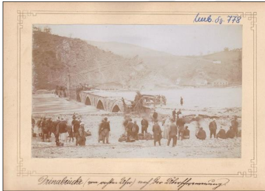
Resim 4.47. 1869 Yılında Meydana Gelen Sel Baskınında Drina Köprüsünün Hasarlı Durumu (Vişegrad-Bosna Hersek Belediye Arşivi, 2015)
