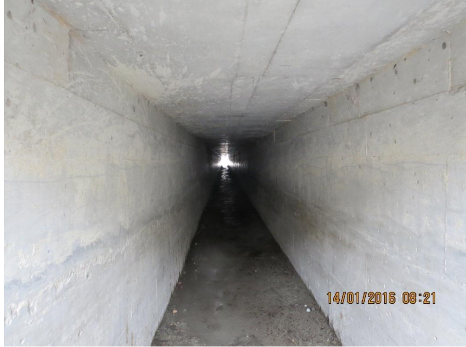
řekil 3.3 Anadolu Otoyolu’nda geirgenliėi saėlayan yapı tiplerinden menfez örneėi (Fotoėraf:A.O. Sayar)
