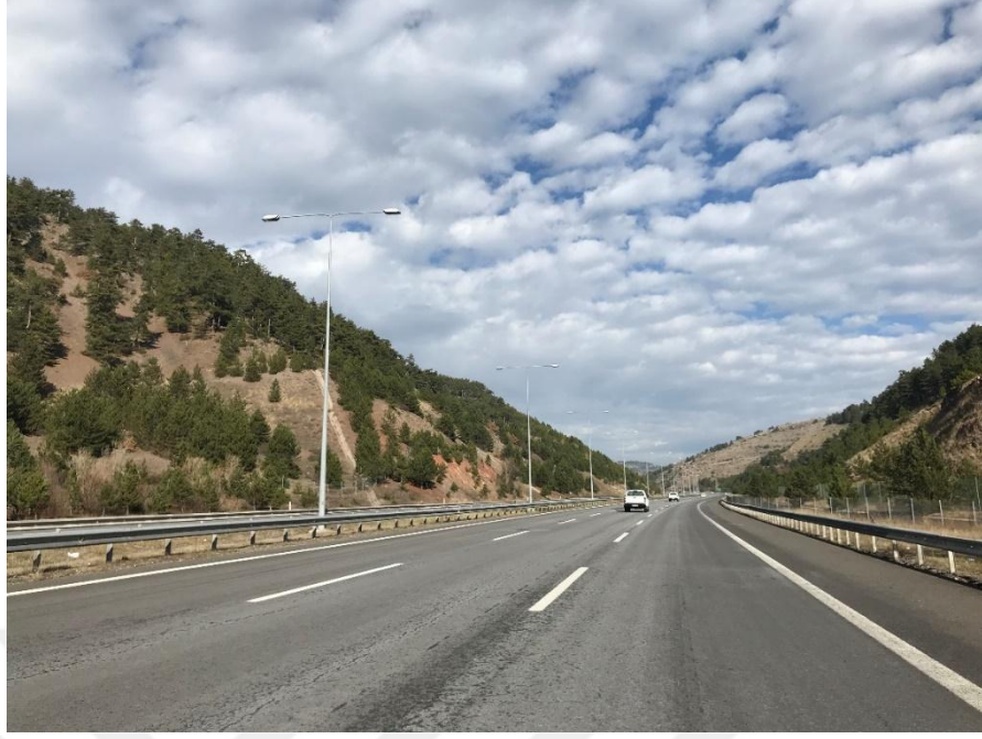
Kanala düşen kızıl geyik bireyinin olduğu ekolojik köprü yapımına uygun bölge
