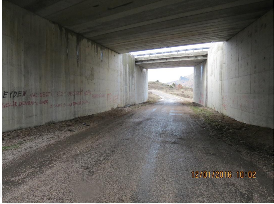
Şekil 3.4 Anadolu Otoyolu'nda geçirgenliği sağlayan yapı tiplerinden altgeçit örneği (Foto:A.O. Sayar)
