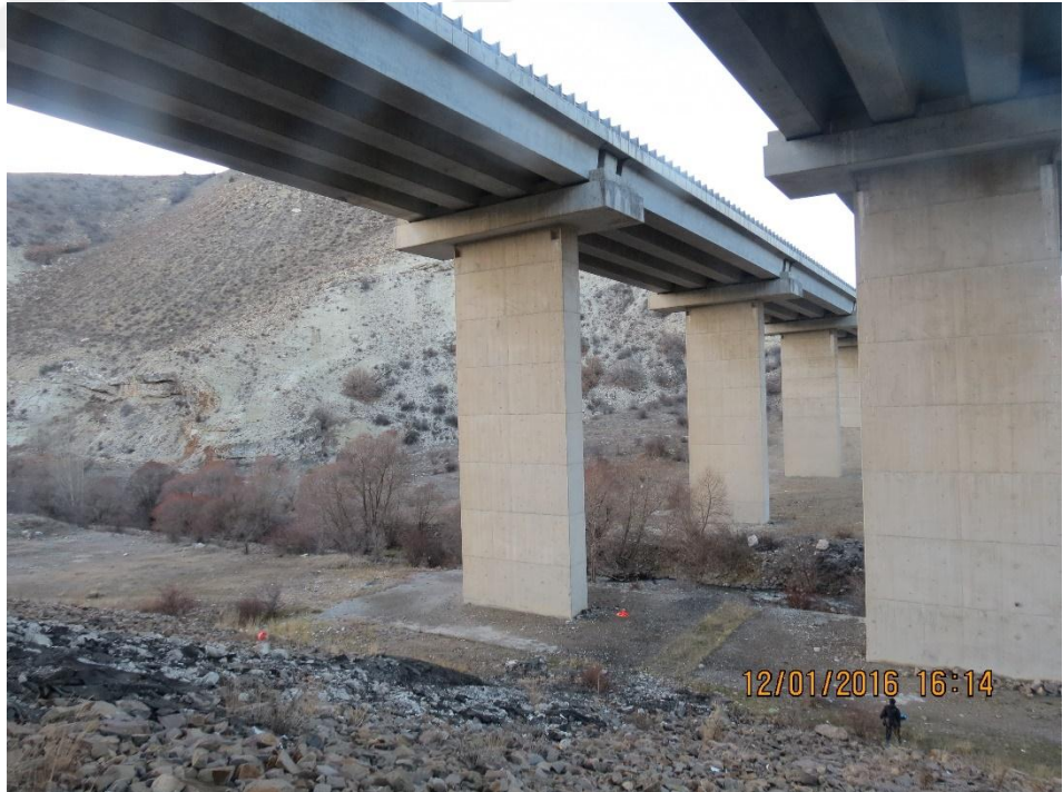
Şekil 3.5 Anadolu Otoyolu'nda geçirgenliği sağlayan yapı tiplerinden viyadük örneği (Foto: A.O. Sayar)
