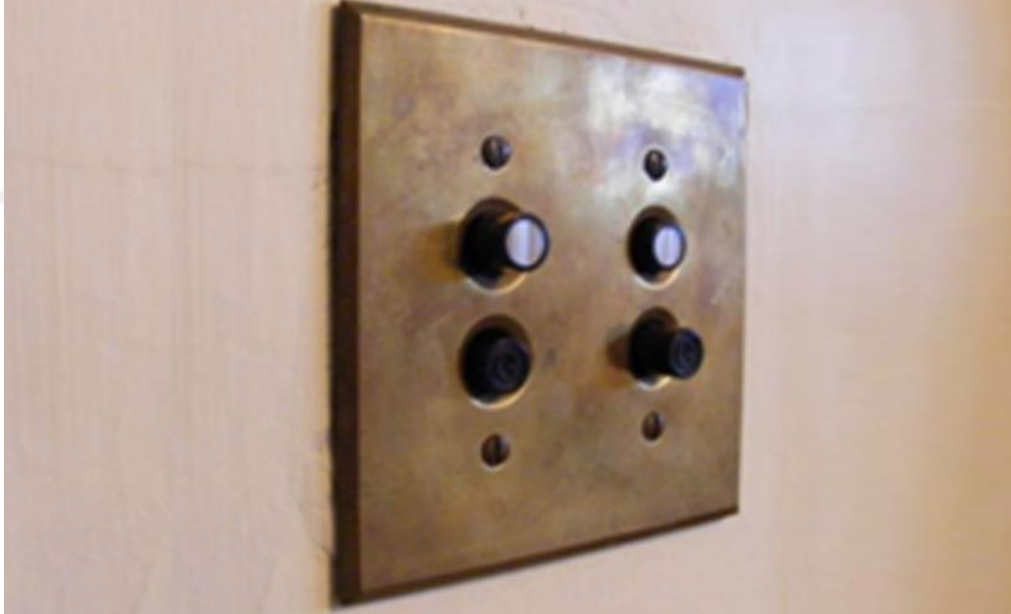
Şekil 2.9: 1910-1920 yıllarına ait bir push-button anahtar (Restoringross, 2017)
