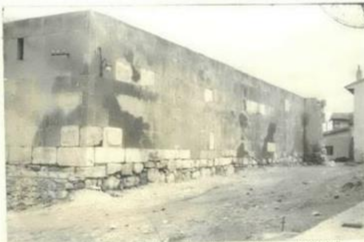
Foto:8 Hanın güney cephesinin önündeki sokaktan görünüşü.
