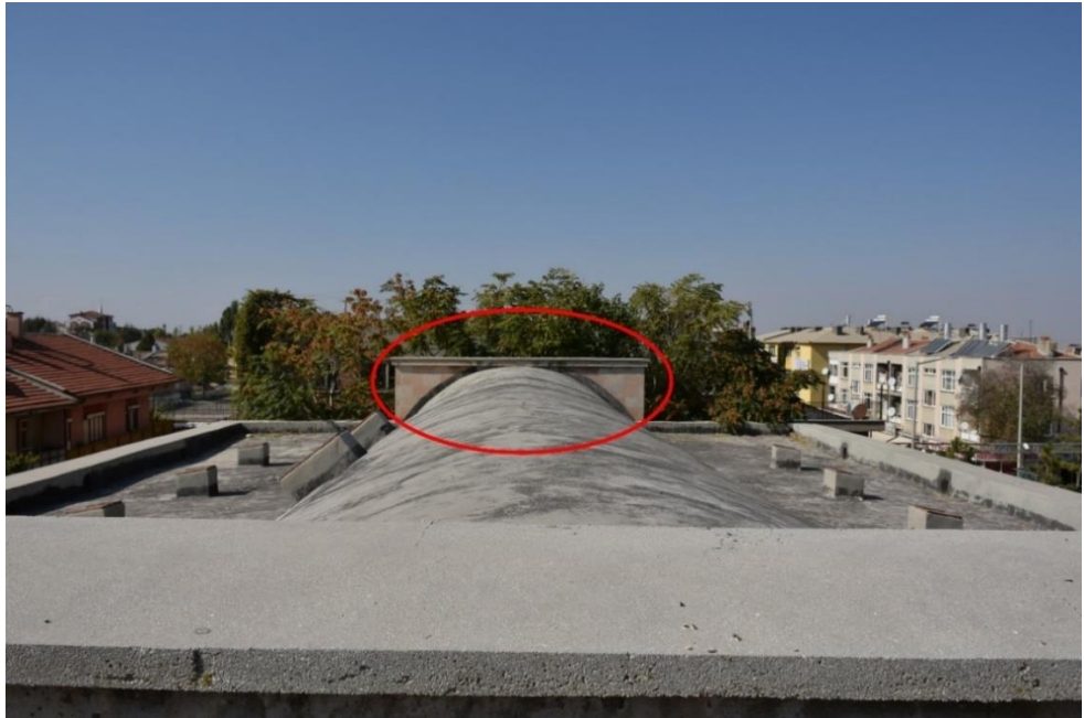
Şekil 4.22: Kadın Hanı çatı muhdes kalkan duvar (Bayram, 2019)
