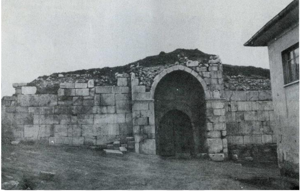
Şekil 4.17: 1987 öncesi Kadın Hanı doğu cephesi (VBM)
