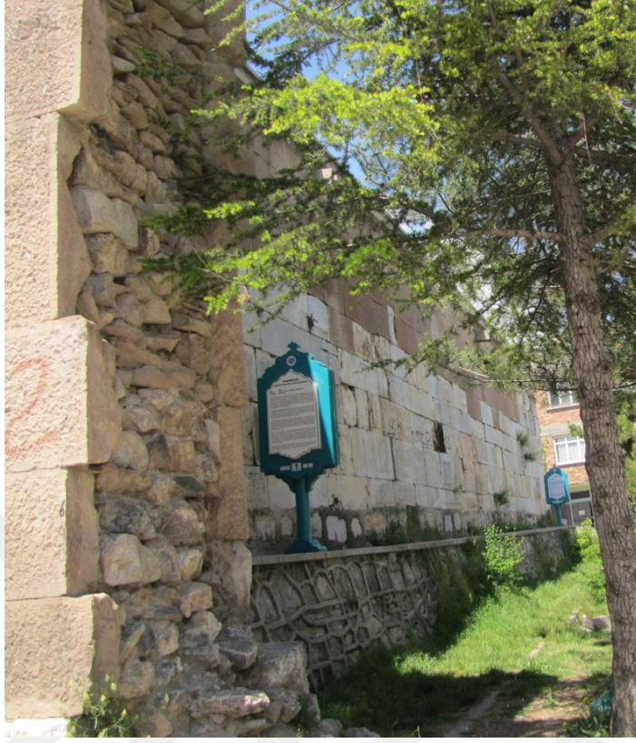
Şekil 3.24: Kadın Hanı kuzey cephesi (VBM, 2014)
