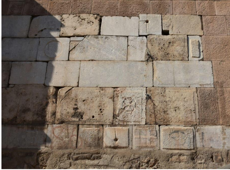
Şekil 3.14: Kadın Hanı doğu cephesi devşirme malzeme örnekleri (Bayram, 2019)
