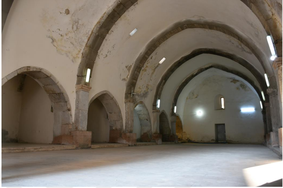
Şekil 4.26: Kadın Hanı iç mekanda oluşturulan bağımsız bölümler ve muhdes kapı (Bayram, 2019)
