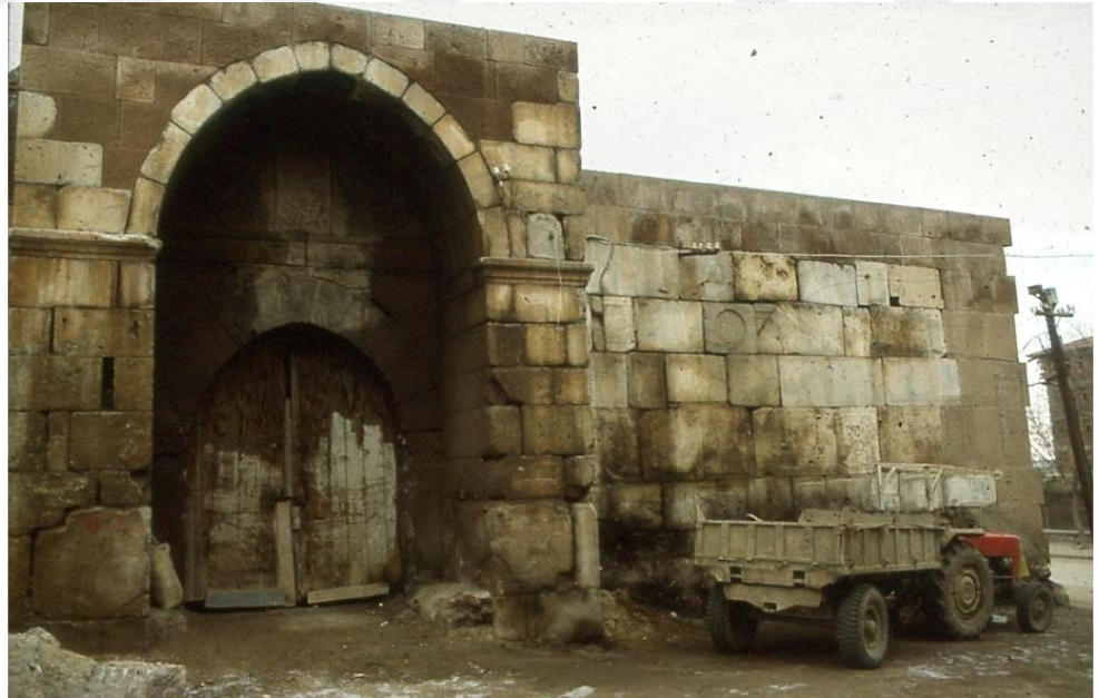
Şekil 4.21: 1987 yılı Kadın Hanı onarım sürecinde doğu cephesi (VBM)
