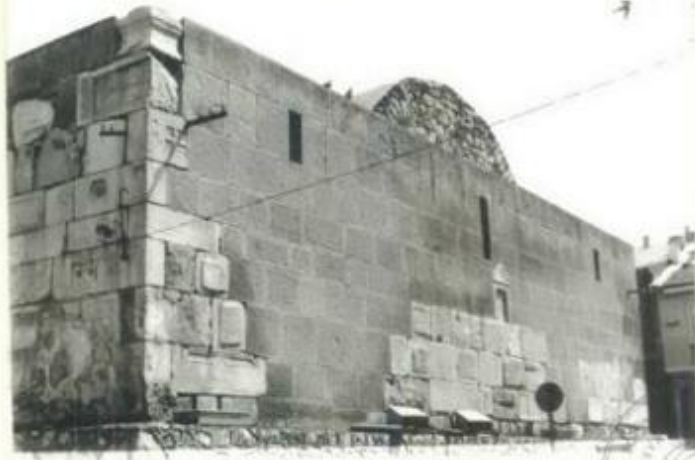
Foto:6 Hanın batı cephesinin kuzeyde bulunan caddeden görünüşü.
