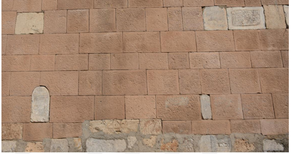
Şekil 3.15: Kadın Hanı güney cephesi devşirme malzeme örnekleri (Bayram, 2019)
