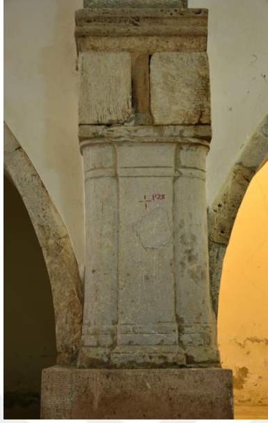
Şekil 3.18/19: İç mekanda yassı bodur sütun ve figürlü payenin taşıyıcı olarak kullanımı (Bayram, 2019)
