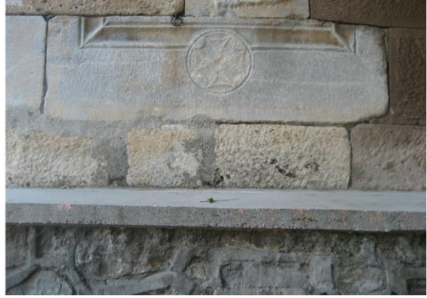
Şekil 4.5/6: Kadın Hanı cephelerden devşirme taş örnekleri (Bayram,2019)
