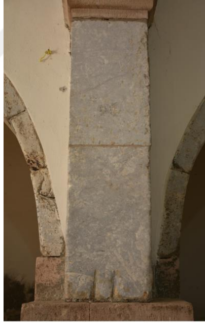
Şekil 3.20/21: İç mekanda yazıtlı mezar stelinin ve devşirme blok taşın taşıyıcı olarak kullanımı (Bayram, 2019)
