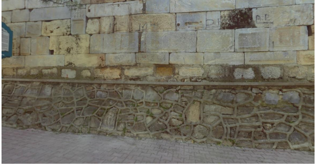
Şekil 3.25: Kadın Hanı kuzey cephesi (Bayram, 2019)
