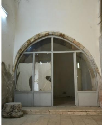
Şekil 4.27/28: Kadın Hanı iç mekan muhdes metal cam doğramalar (Bayram, 2019)
