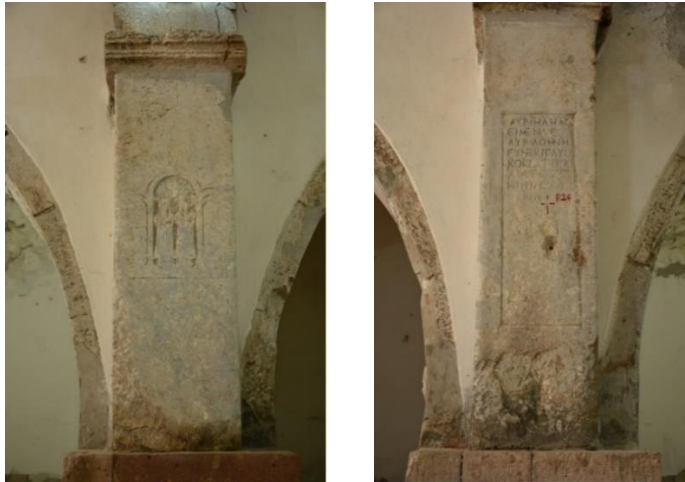
Şekil 4.3/4: Kadın Hanı iç mekana ait devşirme taş sütun örnekleri (Bayram,2019)
