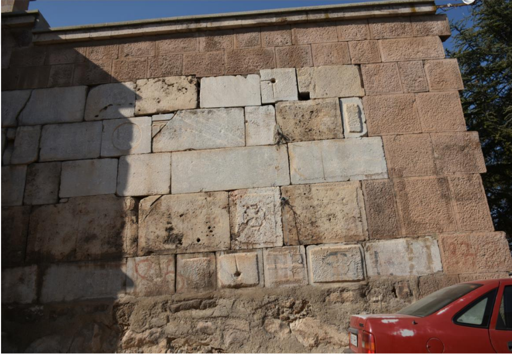
Şekil 3.43: Doğu cephesi parça kaybı, kırılması, yüzey aşınması ve yüzey kirliliği (Bayram, 2019)
