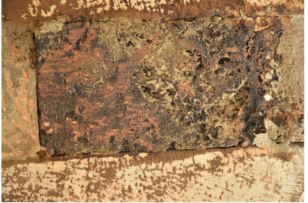
Şekil 3.44: Kesme taş yüzey aşınması (Bayram, 2019)
