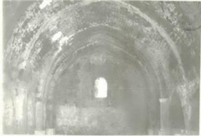
Foto: 13 Orta sahınlıktaki tonoz ve altındaki lokviye kemerlerinden genel görünüş.
