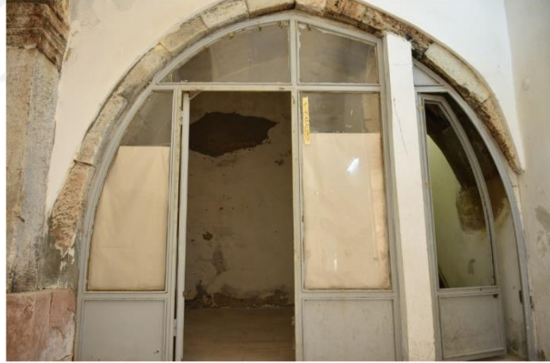
Şekil 4.27/28: Kadın Hanı iç mekan muhdes metal cam doğramalar (Bayram, 2019)
