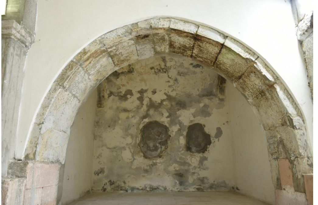
Şekil 3.40: İç mekan yan sahin cephe duvarı yüzey bozulması (Bayram, 2019)
