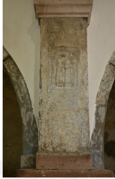
Şekil 3.18/19: İç mekanda yassı bodur sütun ve figürlü payenin taşıyıcı olarak kullanımı (Bayram, 2019)
