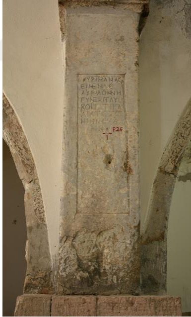
Şekil 3.20/21: İç mekanda yazıtlı mezar stelinin ve devşirme blok taşın taşıyıcı olarak kullanımı (Bayram, 2019)
