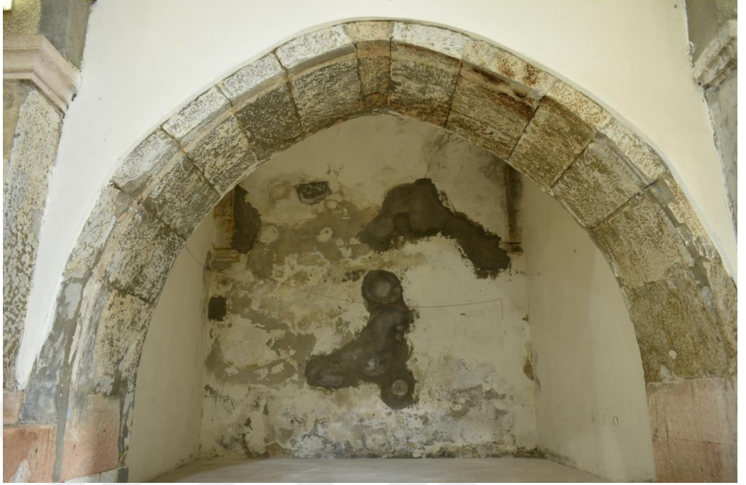
Şekil 3.39: İç mekan yan sahin cephe duvarı yüzey bozulması (Bayram, 2019)
