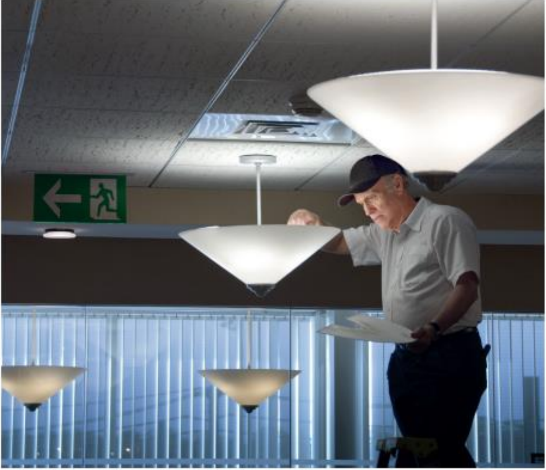
Şekil 4.6. Genel mekan temizliği
