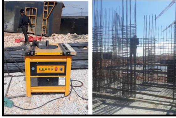
Şekil 4.31. Demir İşçiliği Hazırlama ve demir İşçiliği Montaj
