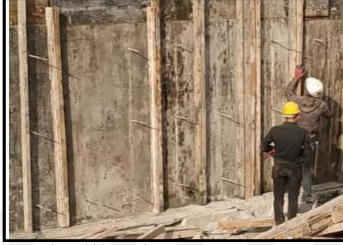
Şekil 4.13. Ahşap Kalıp Sabitlenmesi
