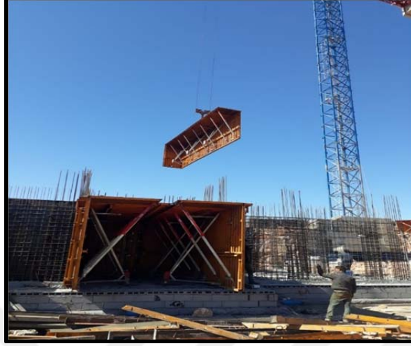
Şekil 4.5. Tünel Kalıp Kurulumu
