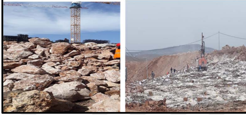
Şekil 4.28 İncelenen İnşaat Sahalarının Arazi ve patlatma Hazırlık Süreci
