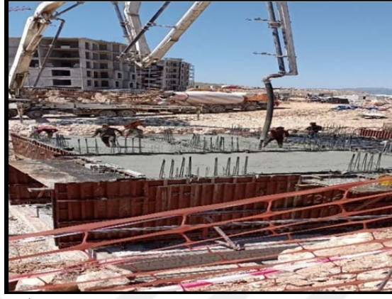
Şekil 4.29. Beton Dökümü
