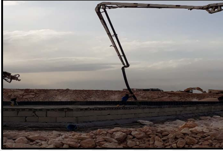
Şekil 4.4. Koruma Betonu Dökümü
