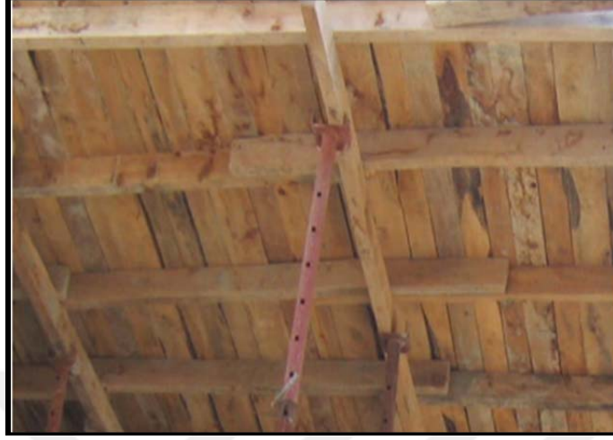
Şekil 4.14. Taşıyıcı kirişe ızgara yerleşimi (MEGEP, 2011)
