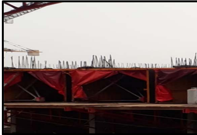
Şekil 4.8. Betonun priz alması için LPG ile ısıtılması
