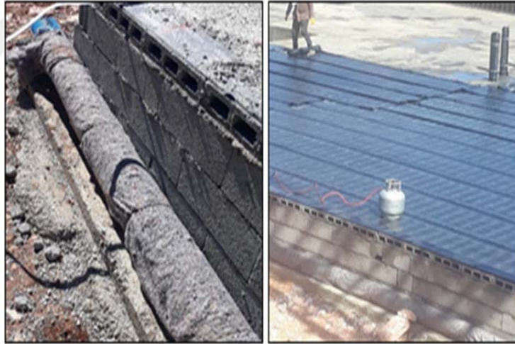
Şekil 4.3. İzolasyon ekibi tarafından membran ile yalıtımı
