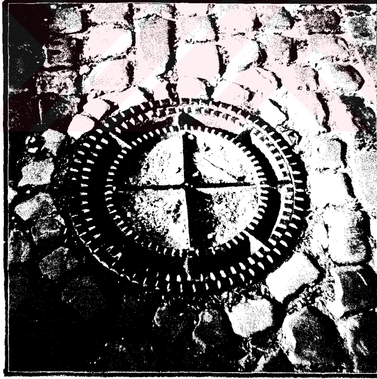
Şekil 4.33 Prag kentinden kanalizasyon kapakları farklı oldukları halde birbirleriyle uyumlular
