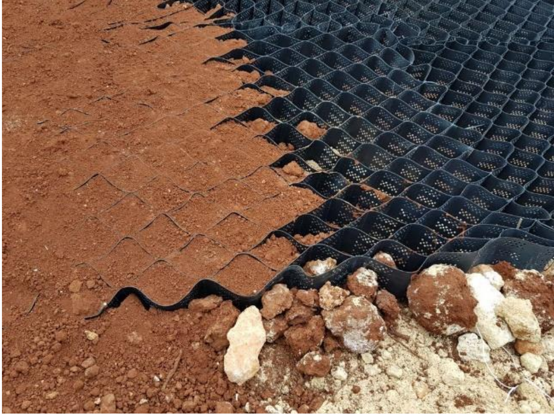
Resim 2.1. Geocellin serilmesi ve hücrelerinin doldurulması (Geoplas, www.geoplas.com.tr )
