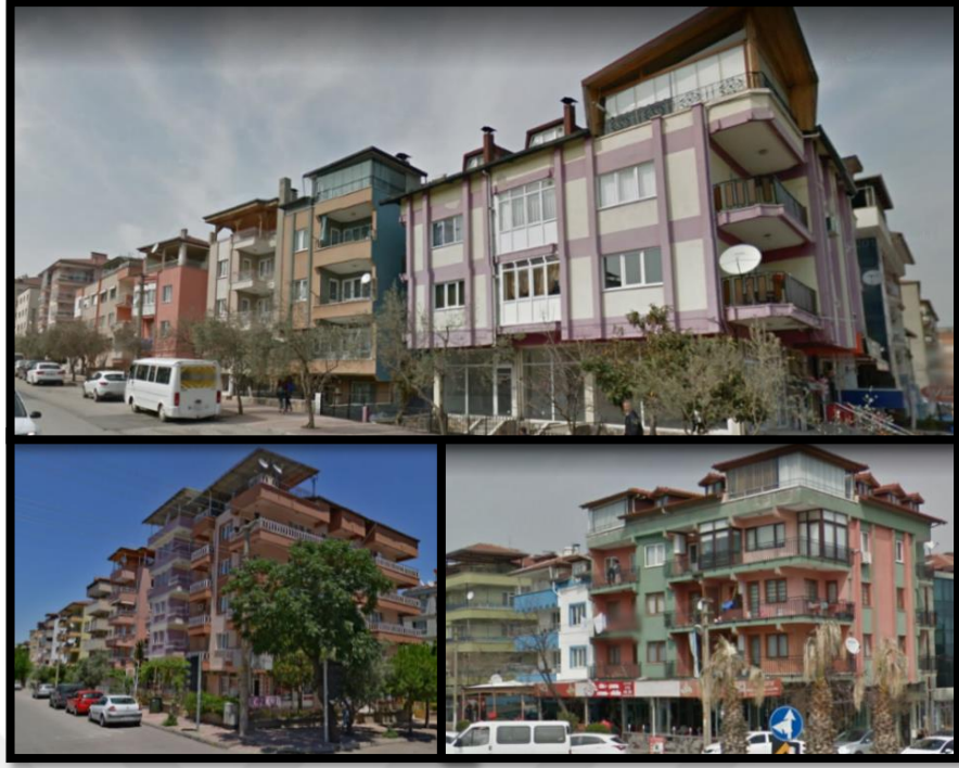
Şekil 3.24: Çatı Kullanımının Oluşturduğu Doku (Çelik 2020 Arşivi)
