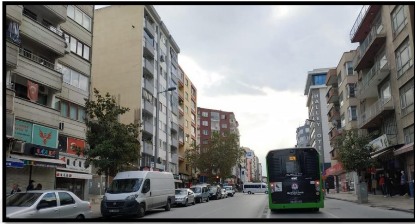
Şekil 3.18: Çıkmaların Yapıldığı ve Yapılmadığı Durumlarda Cephelerde Oluşan Görünüm (Çelik 2020 Arşivi)
