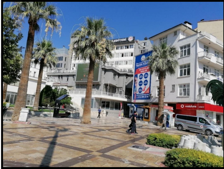
Şekil 3.39: Denizli Büyükşehir Belediye Binası (Çelik 2020 Arşivi)
