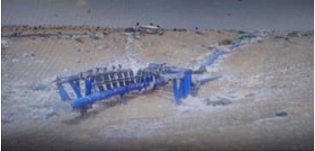
Şekil 19. Erzurum katı atık sahası kollektör sistemi
