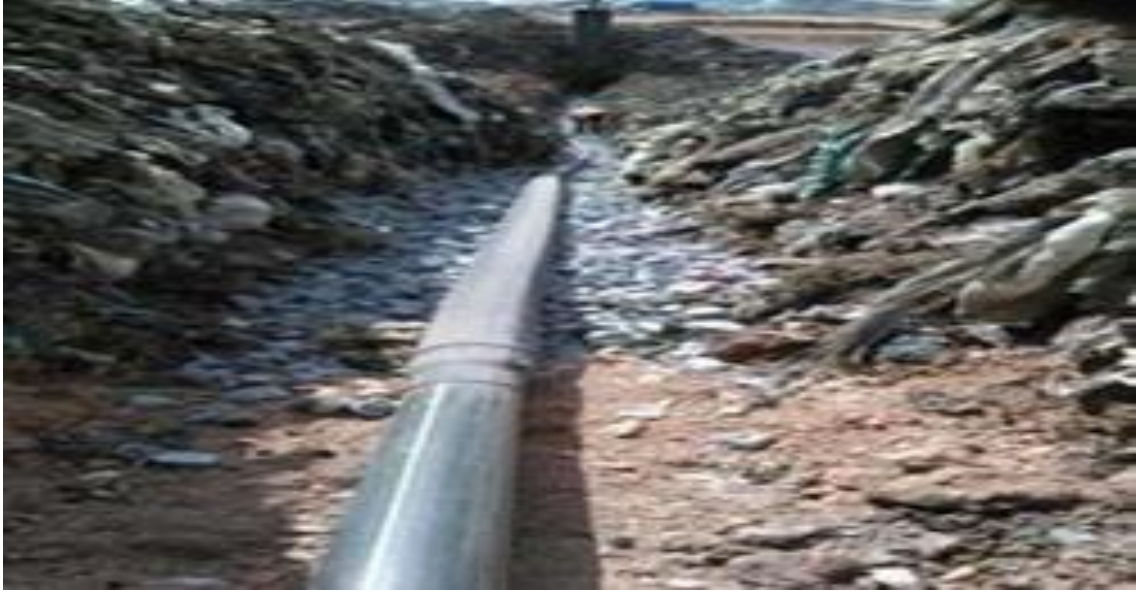
Şekil 18. Erzurum katı atık sahası çöp altı borulama uygulaması
