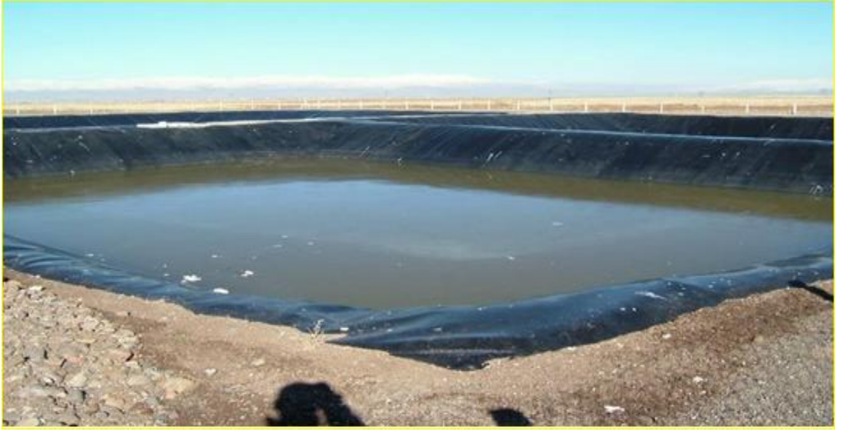
Şekil 13. Sızıntı suyu toplama havuzları
