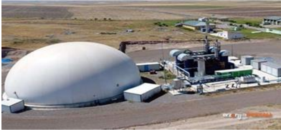
Şekil 16. Erzurum metan gazından elektrik üretim tesisi genel görünümü
