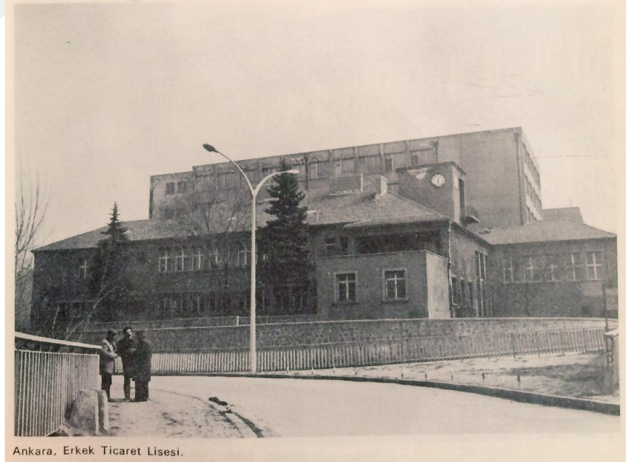
Şekil 4.46. Batı Cephesi birinci kat, dört bölümlü iki açılan kanatlı tepe pencere sistemli özgün pencere tipolojisi (Sözen 1984)
