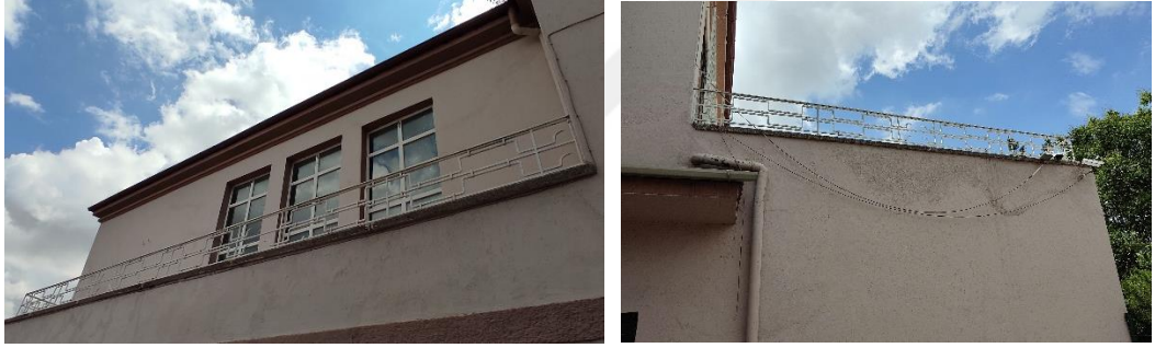
Şekil 4.44. A) B) Özgün teras ve balkon korkuluk detayları (Baloğlu 2022)
