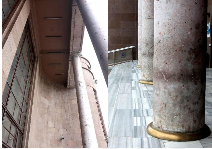
Şekil 4.12. A) Giriş holü hereke taşı kolon B) Özgün pirinç çember ile ankara taşı cephe kaplaması detayları (Anonim 2017c)
