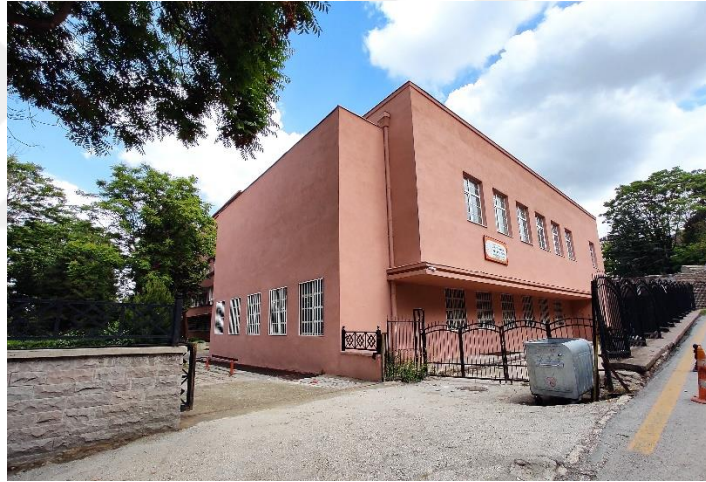
Şekil 4.59. Güney Cephe Ek Yapı Güncel Görünüm (Baloğlu 2022)
