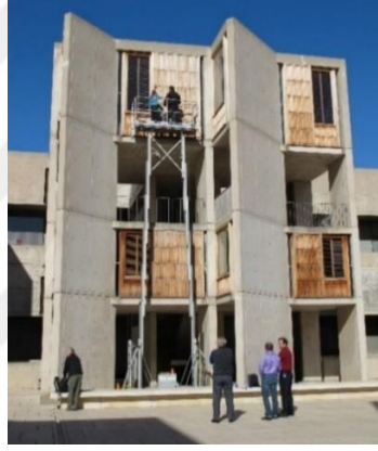
Şekil 2.14. Restorasyon uygulama aşaması (Anonim 2017b)
