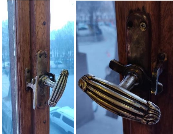
Şekil 4.84. A) B) Özgün pencere kolları (Baloğlu 2022)
