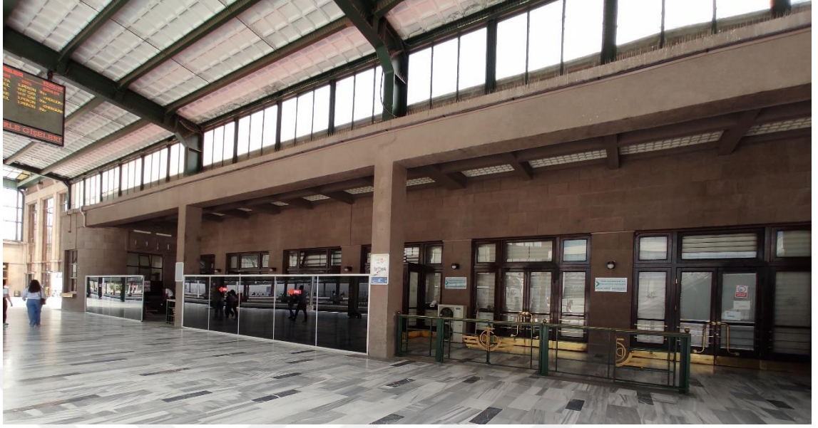
Şekil 4.18. Özgün Metal Korkuluk ve Niteliksiz Ek Güncel Durum (Baloğlu 2022)
