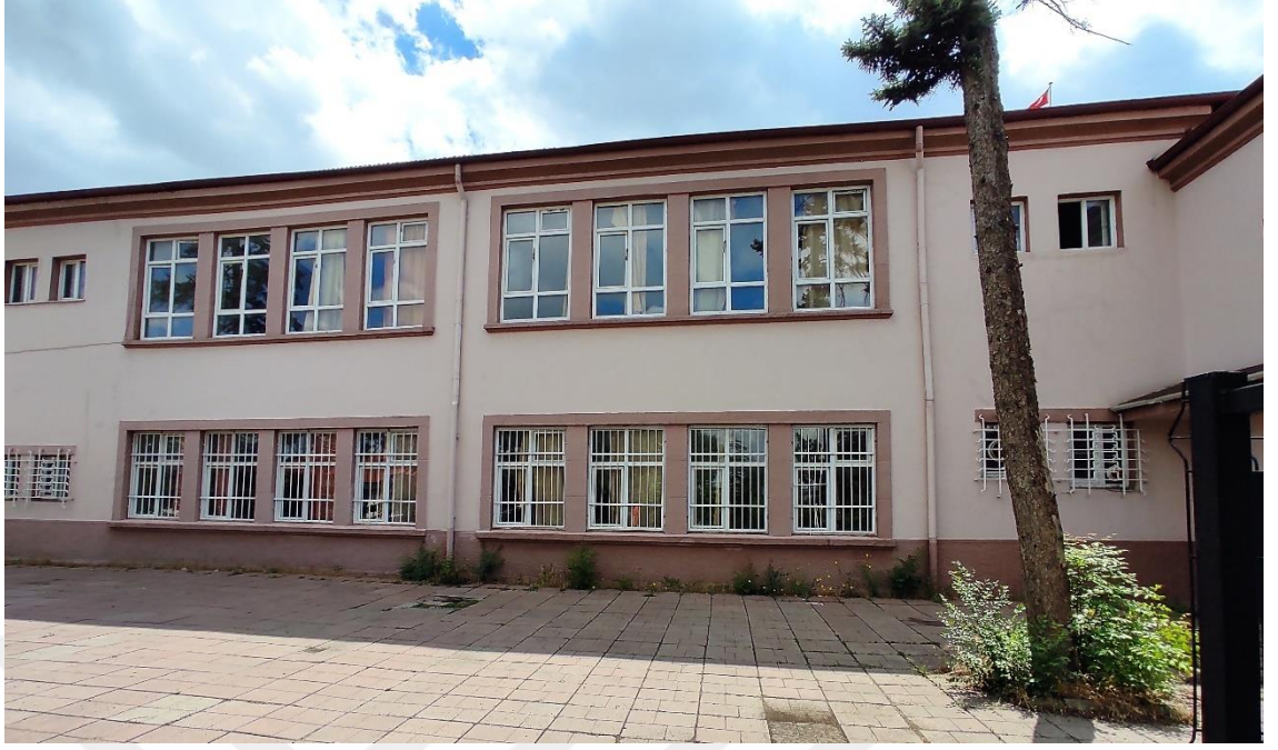
Şekil 4.47. Batı Cephesi birinci kat, altı bölümlü tek açılan kanatlı tepe ve alt pencere sistemli niteliksiz pencere tipolojisi (Baloğlu 2022)
