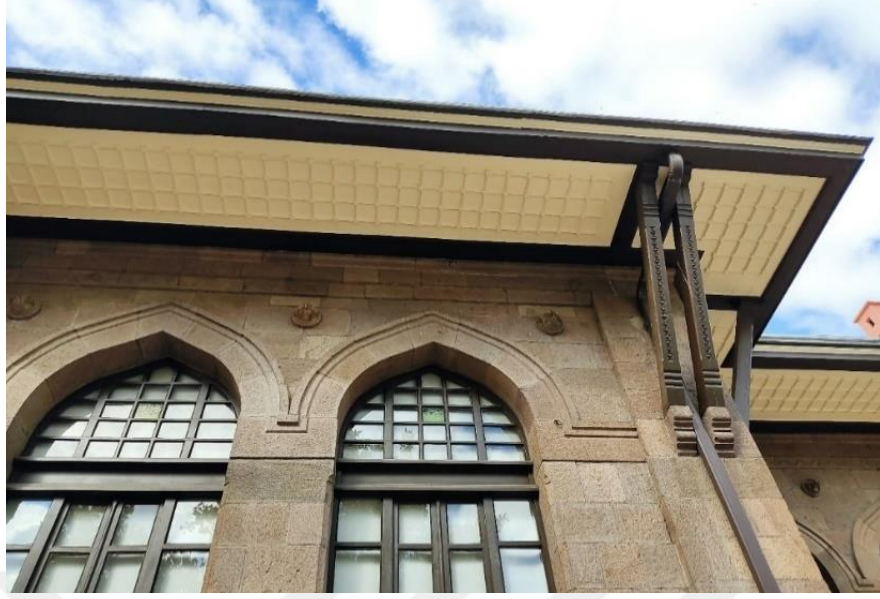
Şekil 4.64. I. TBMM Meclisi Saçak ve Sivri Kemer Detayı (Baloğlu 2022)
