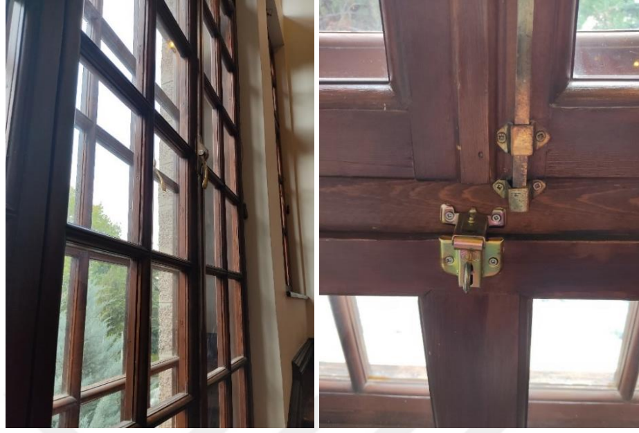
Şekil 4.76. A) II. TBMM Binası Merdiven Penceresi B) II. TBMM Binası Merdiven Penceresi Kilit Sistemi Detayları (Baloğlu 2022)
