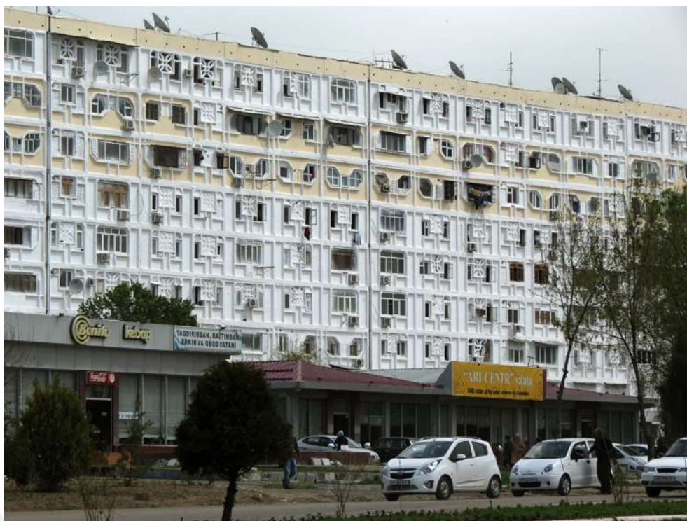
Пример зданий, построенных после землетрясения 79
