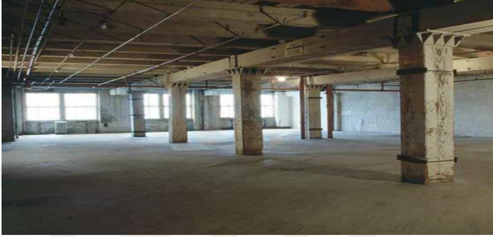
Şekil 7. Doğal Loft: Tipik Bir Doğal Loft, Yıpranmış Kolon Ve Kirişler, Duvarların Alçı Sıvalı Bırakılmış Ve Elektrik Tesisatının Açıktan Geçmiş
