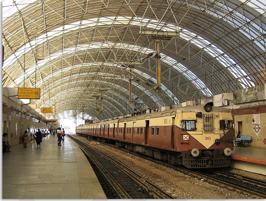
Şekil 39. Thirumailai Tren İstasyonu'nun çatısı, Chennai, Hindistan (URL-14).
