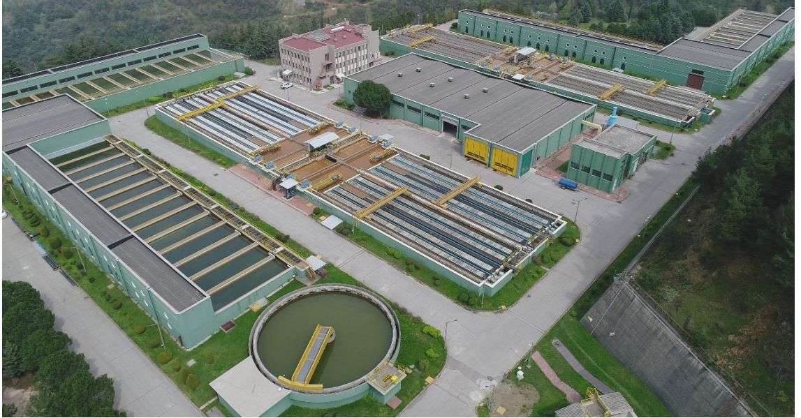
Şekil 8. Dobruca İçme Suyu Arıtma Tesisi Havadan Çekilmiş Görüntüsü (Dobruca İçme Suyu Arıtma Tesisinden temin edilmiştir)
