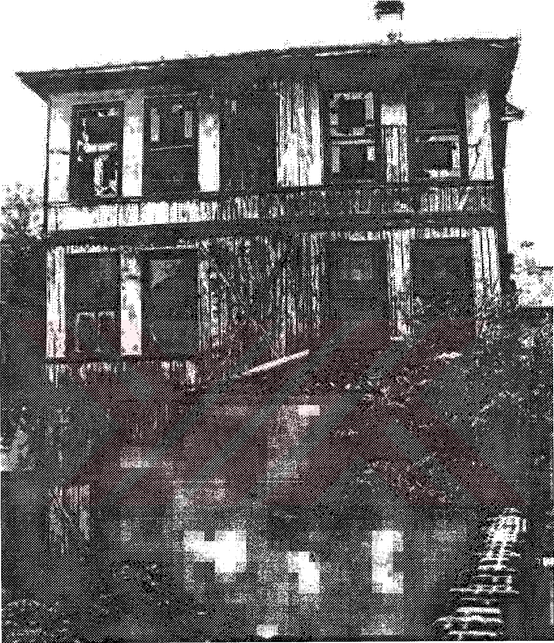
Şekil 3.28 Ahşap konstrüksiyon arası ahşap dolgu üzeri sıva
