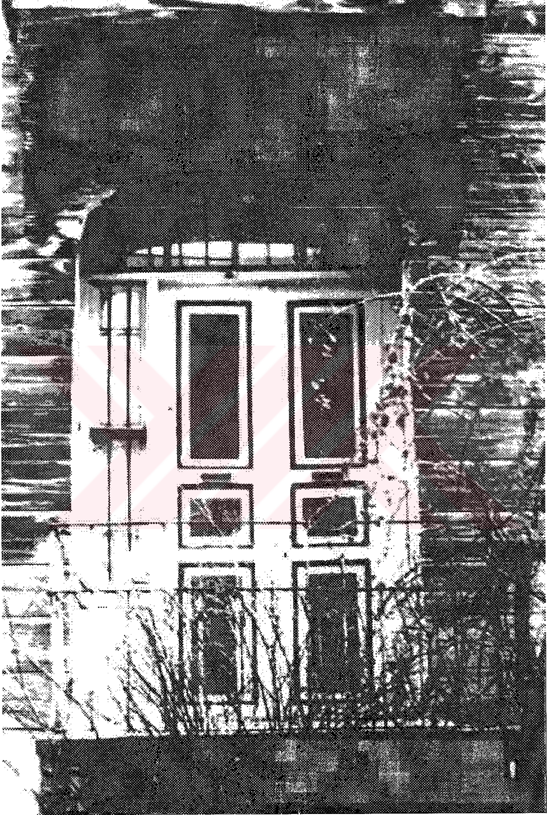
Şekil 3.18 Kapı Kenarında ve Üzerinde Pencere Kullanımı
