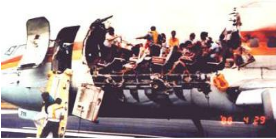
Şekil 2.2. Korozyona bağlı yorulma kırılımı (ALOHA) [16]
