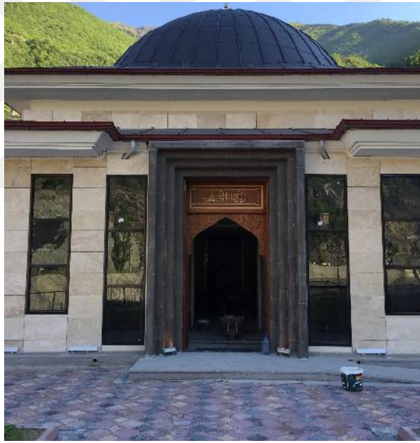
Şekil 3.86. Dış ana ahşap kapı (taç kapı) ön cephe.
