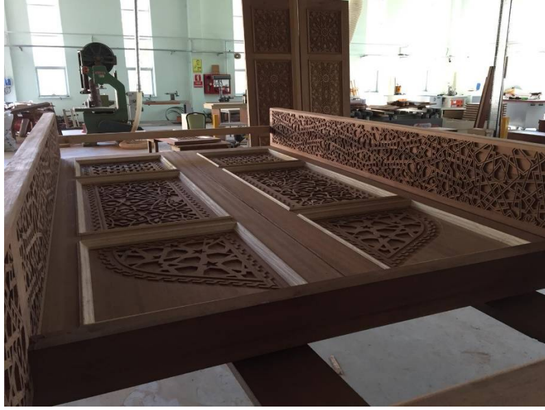
Şekil 3.85. Dış ana ahşap kapı (taç kapı) konstrüksiyon işlemi.
