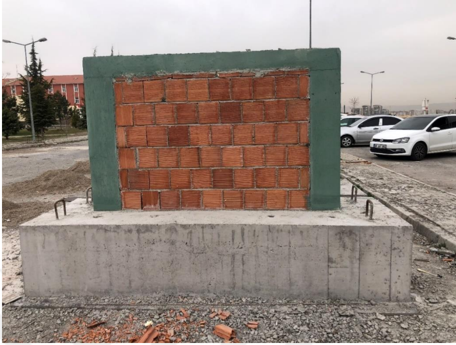
Şekil 2.14. Betonarme yüzeylere astar uygulaması
