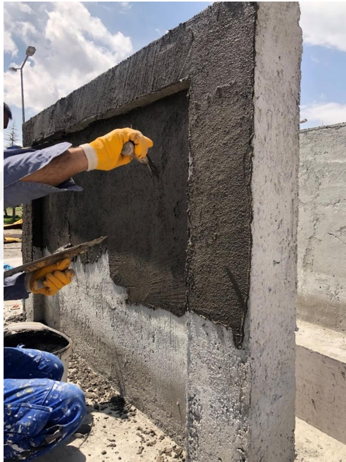
Şekil 2.16. TEKNOREP 300 harcının ilk katının uygulanması
