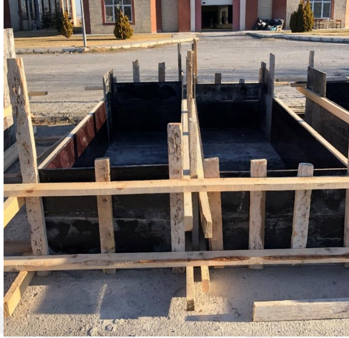
Şekil 2.7. Temel kalıplarının hazırlanması
