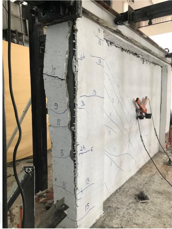
Şekil 3.15. Güçlendirme malzemesinin yüzeyden ayrılması
