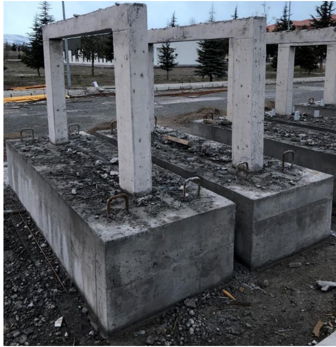
Şekil 2.12. Betonarme çerçevelerin kalıplarının sökülmüş hali
