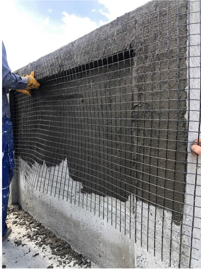
Şekil 2.17. FRCM güçlendirme malzemesinin uygulanması
