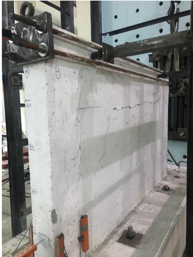
Şekil 3.7. Altıncı döngü sonunda oluşan çatlaklar
