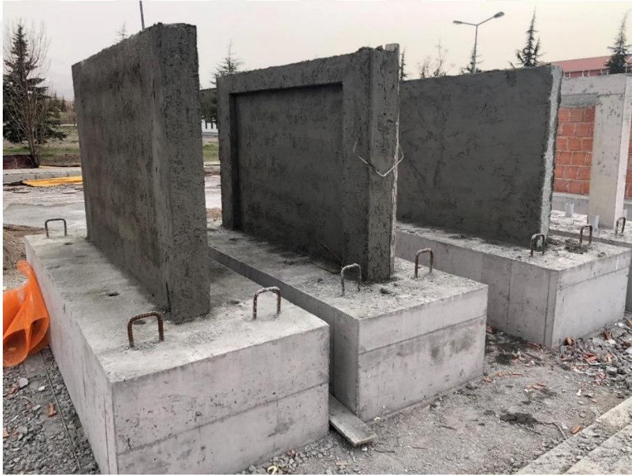
Şekil 2.15. Sıva uygulaması bitmiş betonarme çerçeveler
