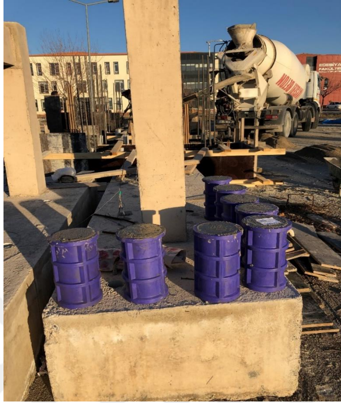
Şekil 2.10. Temellerin betonundan alınan numuneler
