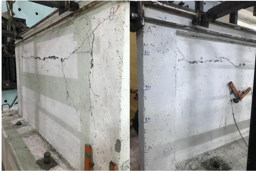
Şekil 3.8. Sekizinci döngü sonunda oluşan çatlaklar
