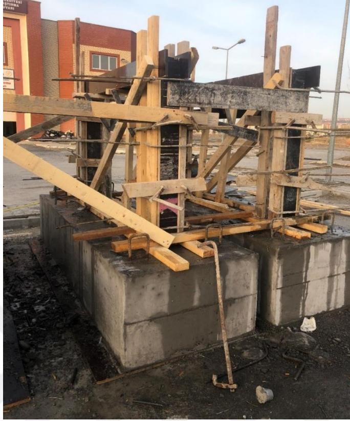
Şekil 2.11. Temellere kür işleminin uygulanması
