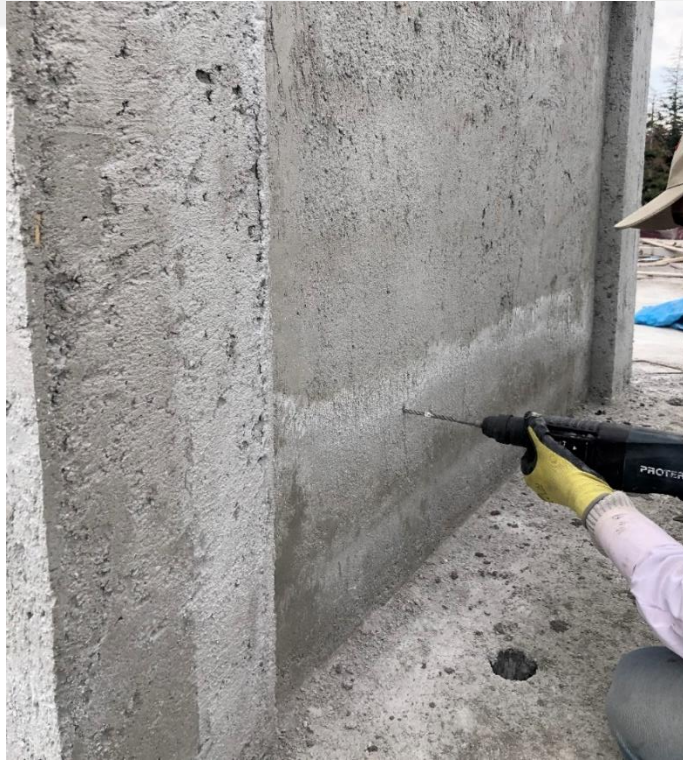
Şekil 2.20. Ankraj uygulanacak noktaların matkap ile delinmesi
