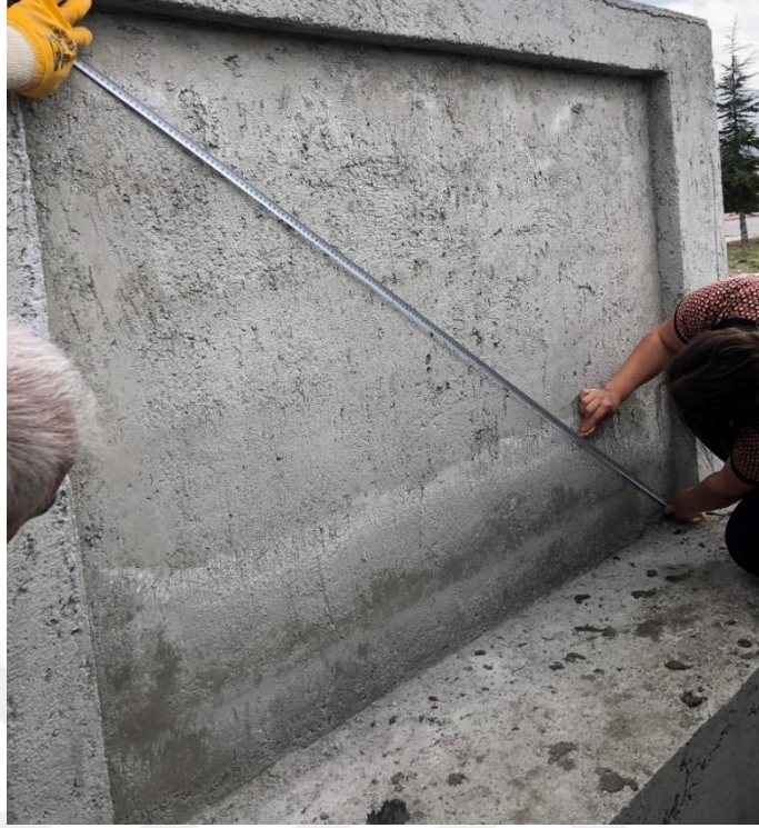
Şekil 2.19. Ankraj uygulanacak yerlerin İşaretlenmesi
