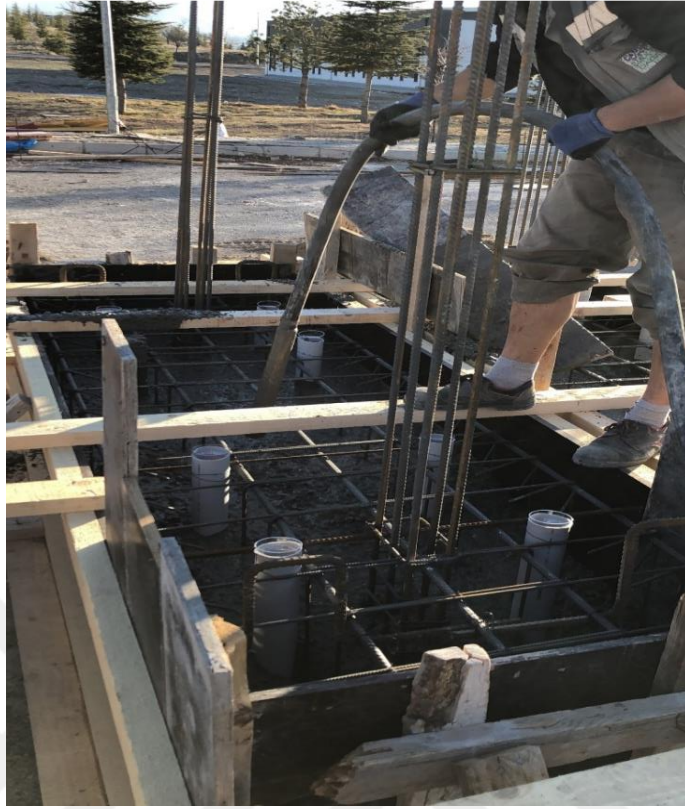
Şekil 2.9. Bağlantı boşluklu temellerin beton dökümü
