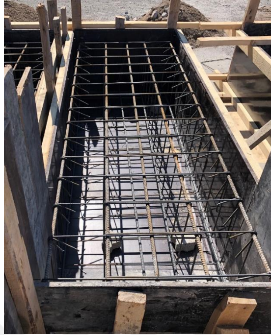
Şekil 2.8. Temel donatılarının hazırlanması
