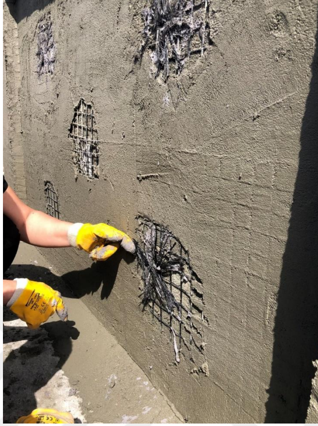
Şekil 2.21. Ankraj uygulaması
