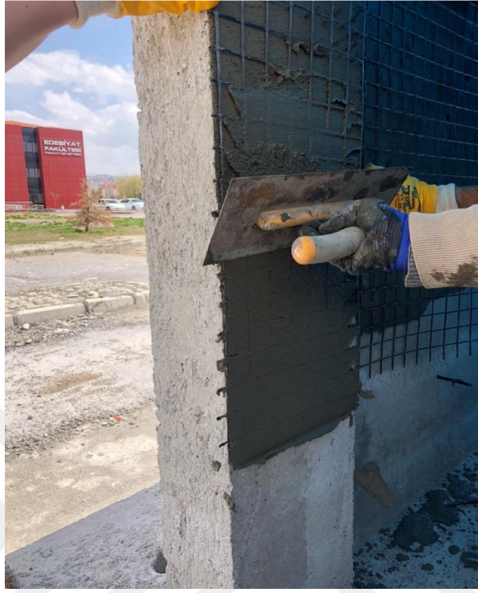
Şekil 2.18. FRCM güçlendirme malzemesinin üzerine harç uygulanması
