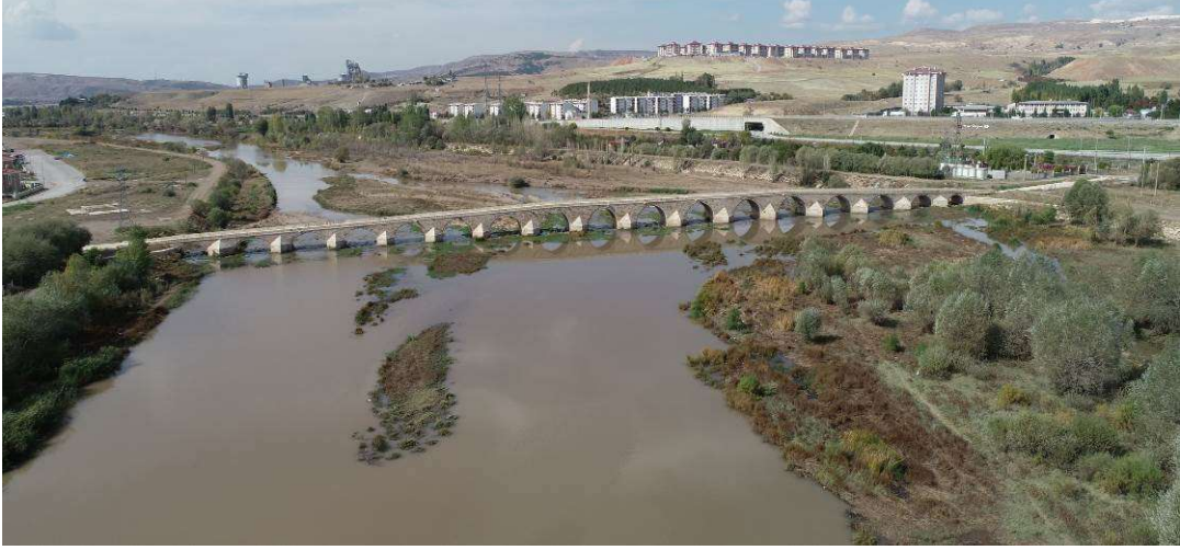
Şekil 4.30. Kesik Köprü (Sivas Belediyesi Arşivi, 2022)
