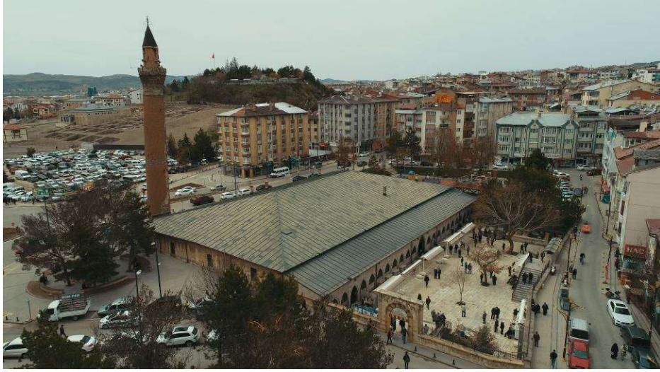
Şekil 4.6. Sivas Ulu Camii (Sivas Belediyesi Arşivi, 2022)
