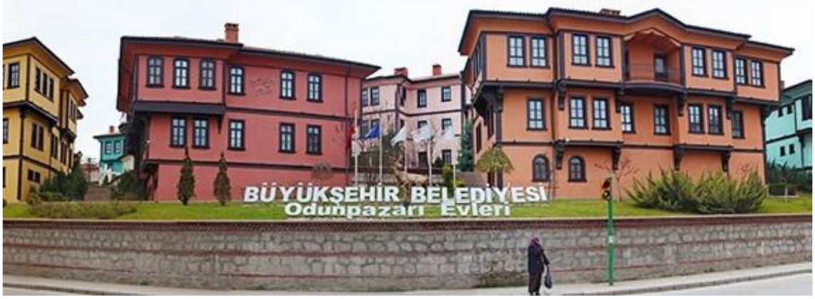
Şekil 3.10. Eskişehir Odunpazarı Evleri
