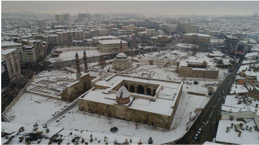
Şekil 4.11. Şifaiye Medresesi (Sivas Belediyesi Arşivi, 2022)
