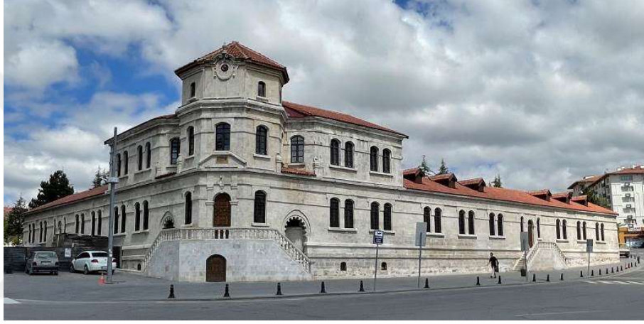
Şekil 4.74. Jandarma Binası (Türk, 2022)
