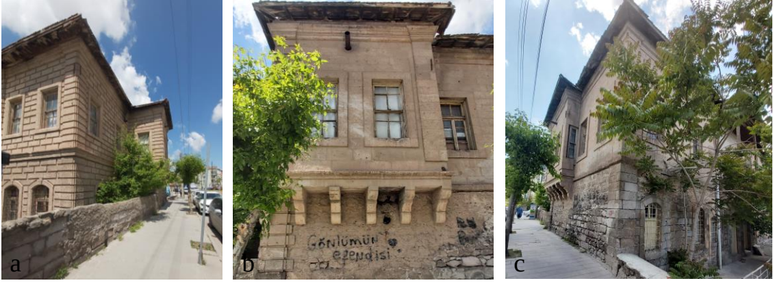
Şekil 4.194. a) Güneydoğu cephesi, b) doğu cephesindeki cumba, c) kuzeydoğu cephesi
