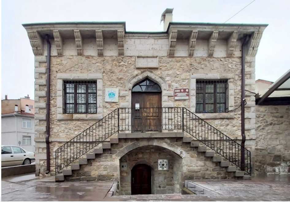
Şekil 4.157. Konut-14 batı (giriş) cephesi
