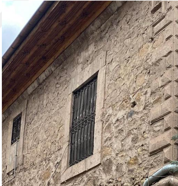
Şekil 4.33. Konut-2 doğu cephesi birinci kat penceresi ve bezemeli ahşap saçığı
