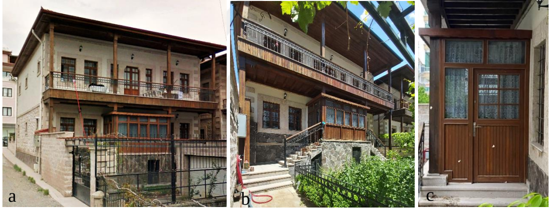
Şekil 4.129. a) Batı cephesi, b) batı cephesi arka bahçeden görünüşü, c) bahçe çıkış kapısı sahanlığı
