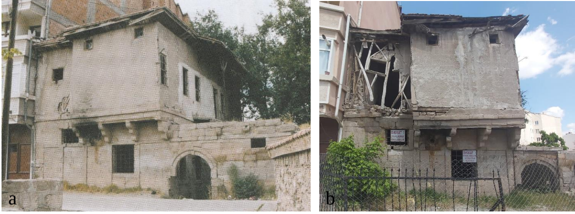
Şekil 4.179. a) Konut-17 güney cephesi yıkılmadan önceki hali (Erdal, 2016), b) günümüz güney cephesi
