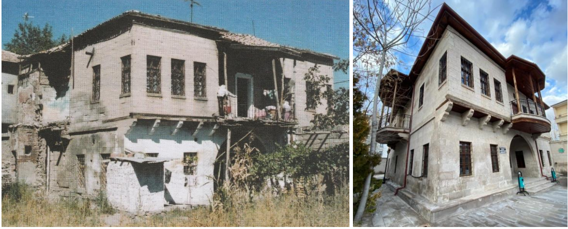
Şekil 4.148. Konut-13 restorasyon öncesi güneybatı cephesi (Erdal, 2016) ve günümüz güneybatı cephesi
