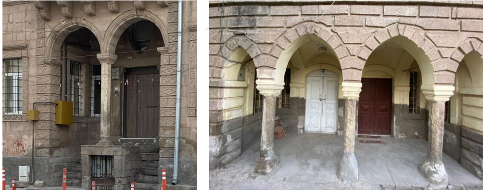
Şekil 5.3. Nişli girişe sahip Konut-15(solda) ve Konut-18 (sağda)
