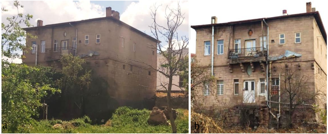
Şekil 4.170. a) Konut-15 kuzeybatı cephesi, b) kuzey cephesi
