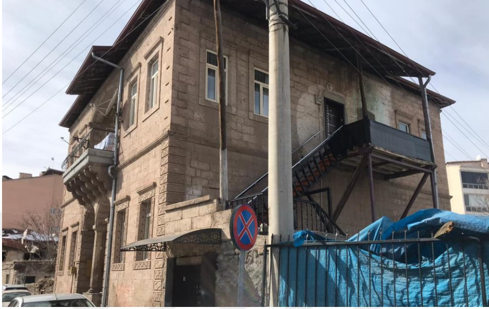
Şekil 4.172. Konut-15 güneydoğu cephesi
