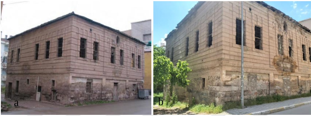
Şekil 4.207. a) Konut-20 geçmiş tarihli kuzeydoğu cephesi (Erdal,2016), b) günümüz kuzeydoğu cephesi
