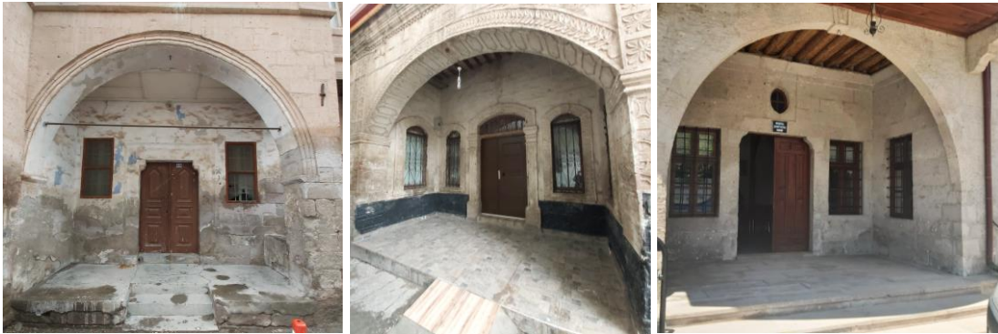
Şekil 5.4. Nişli girişe sahip Konut-6(solda), Konut-7 ve Konut-13(sağda)
