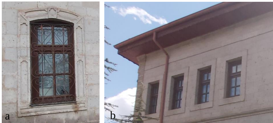
Şekil 4.73. a) Zemin kat penceresi, b) birinci kat penceresi
