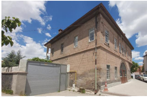
Şekil 4.41. Konut-3 güneydoğu cephesi
