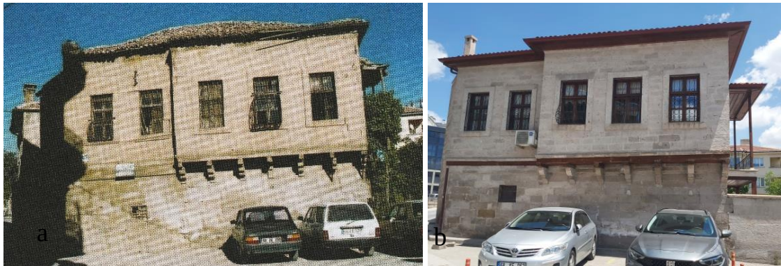
Şekil 4.138. a) Restore edilmeden önceki batı cephesi (Erdal, 2016), b) günümüz batı cephesi
