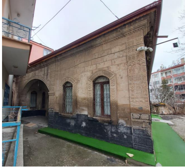
Şekil 4.87. Konut-7 doğu(giriş) cephesi
