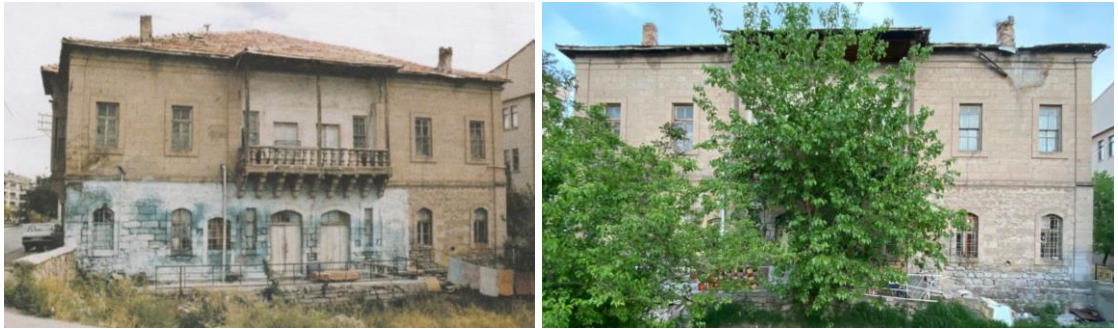
Şekil 4.190. Konut-18 kuzey cephesi (Erdal, 2016) ve günümüz kuzey cephesi
