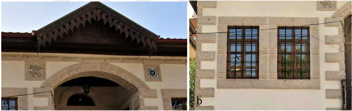
Şekil 4.120. a) Kemerin köşelerinde bulunan yapı kitabesi ve çinili süsleme, b) yapının birinci kat pencereleri
