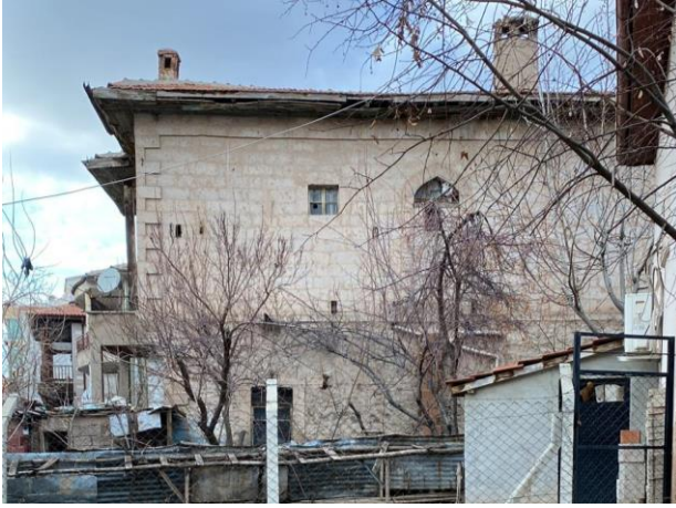
Şekil 4.113. Konut-9 güney cephesi
