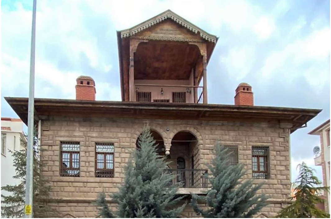
Şekil 5.34. Konut-2 köşk yapısında yapılan çatı alınlığı
