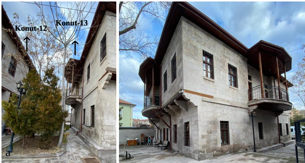
Şekil 4.149. a) Konut-13 batı cephesi ve Konut-12 doğu cephesi, b) Konut-13 kuzeybatı cephesi
