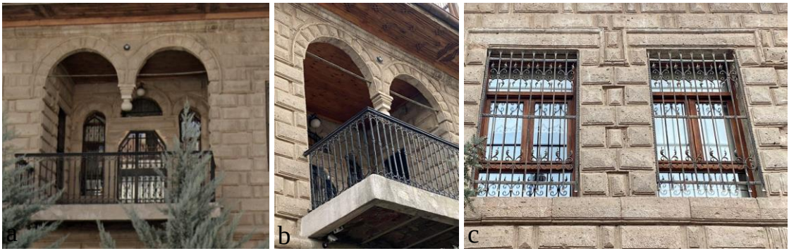
Şekil 4.30. a) Birinci kat cephenin merkezindeki balkon, b) balkon detayları ve c) Birinci kat pencereleri
