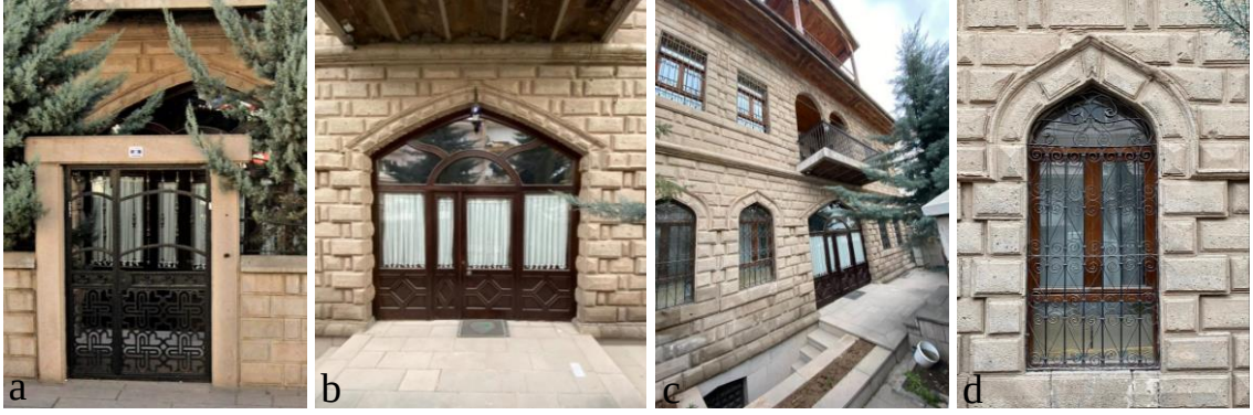
Şekil 4.29. Konut-2 a) avlu kapısı, b) giriş kapısı, c) kuzey cephesi avlusu ve d) zemin kat penceresi
