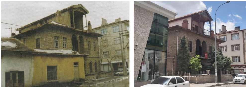
Şekil 4.27. Konut-2 onarım geçirmeden önceki görünüşü (Erdal, 2016) ve günümüz genel görünüşü
