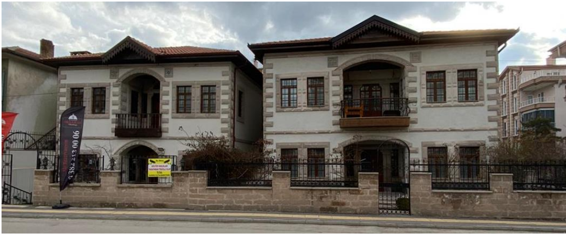
Şekil 4.124. Konut-10 (solda) ve Konut-11'in sokaktan görünümü
