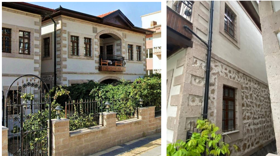
Şekil 4.128. Konut-11 güneydoğu ve kuzeydoğu cephesi
