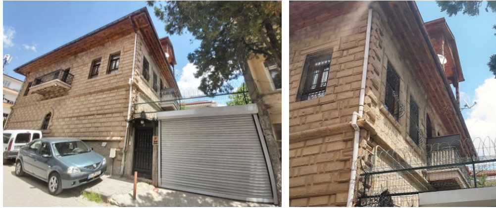
Şekil 4.32. Konut-2 güneybatı cephesi (solda) ve güney cephedeki cumbalı pencereleri (sağda)
