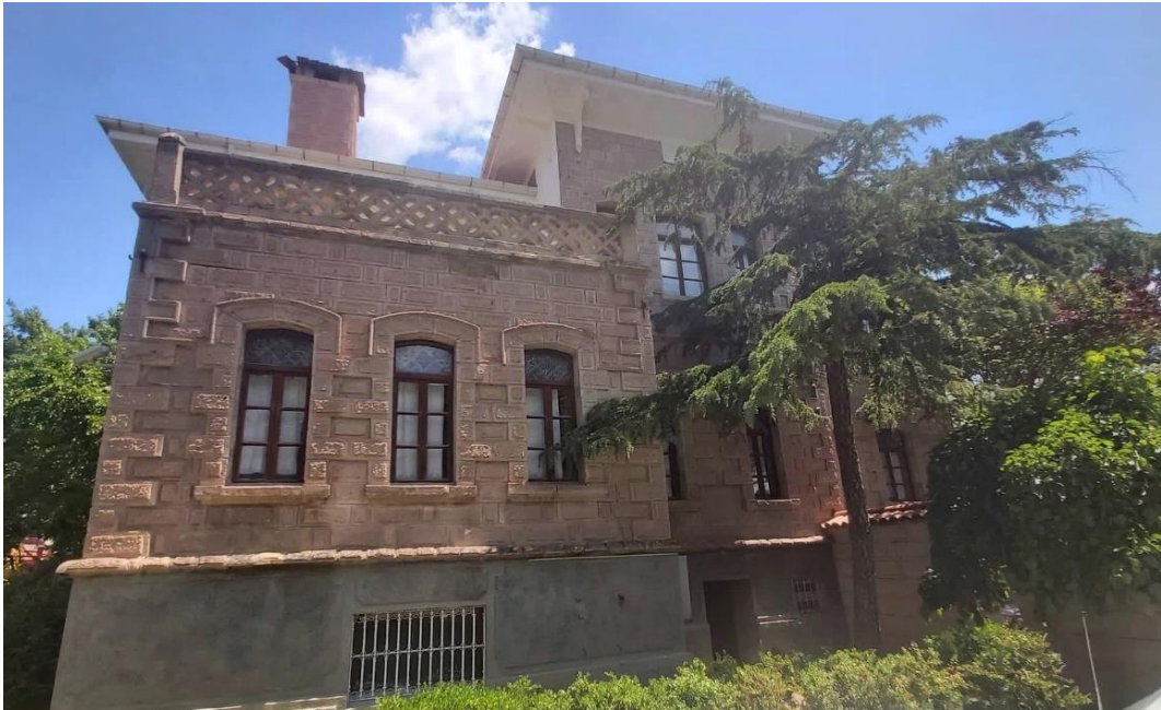
Şekil 4.101. Konut-8 güney cephesi
