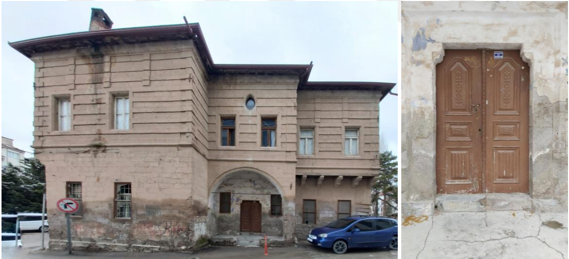
Şekil 4.76. Konut-6 kuzey(giriş) cephesi ve ahşap giriş kapısı
