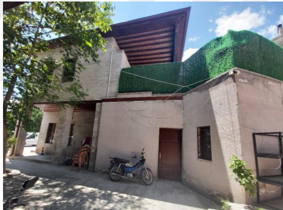
Şekil 4.143. Konut-12 doğu cephesi
