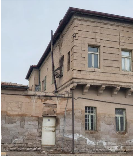
Şekil 4.82. batı cephesindeki bahçeye sokaktan geçişi sağlayan doğu cephedeki bahçe kapısı
