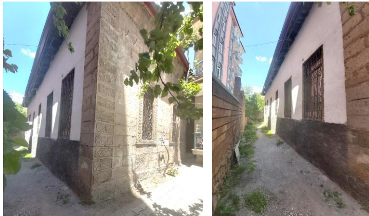
Şekil 4.91. Konut-7 güneydoğu(solda) ve güney cephesi(sağda)
