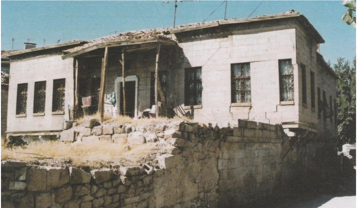
Şekil 4.155. Konut-13 restorasyon öncesi güneydoğu cephesi (Erdal, 2016)
