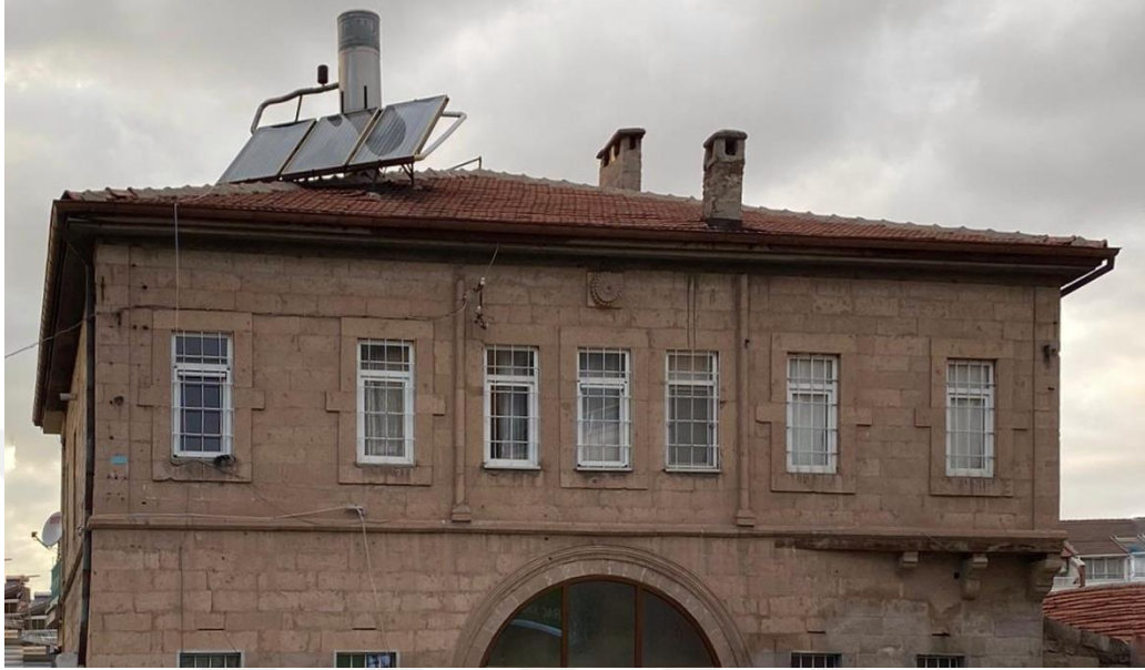
Şekil 4.39. Konut-3 doğu(giriş) cephesi birinci katı
