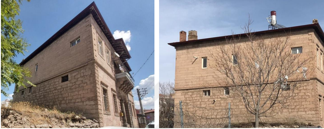
Şekil 4.168. Konut-15 güneybatı ve batı cephesi
