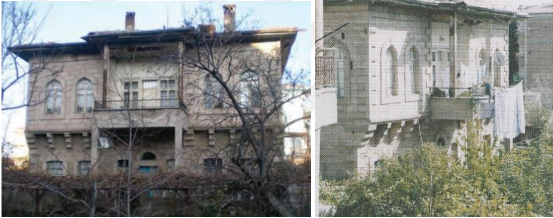
Şekil 4.115. Konut-9 batı cephesi(solda) ve kuzeybatı cephesi (Erdal, 2016)
