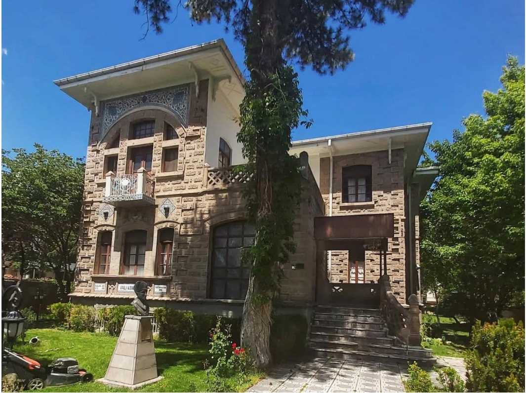
Şekil 4.97. Konut-8 doğu cephesi
