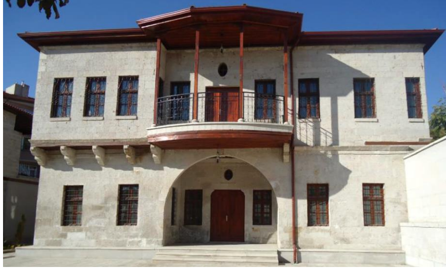
Şekil 4.145. Konut-13 güney cephesi
