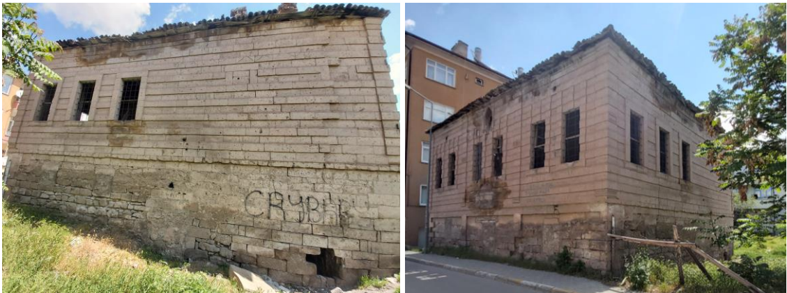
Şekil 4.211. Konut-20 batı cephesi ve kuzeybatı cephesi
