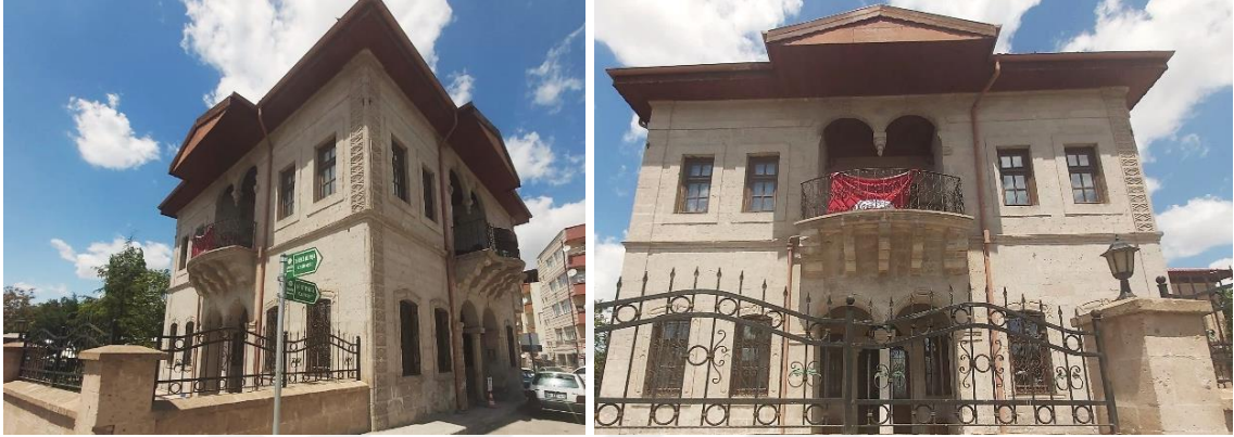
Şekil 4.69. Konut-5 güneydoğu (solda) ve güney cephesi (sağda)
