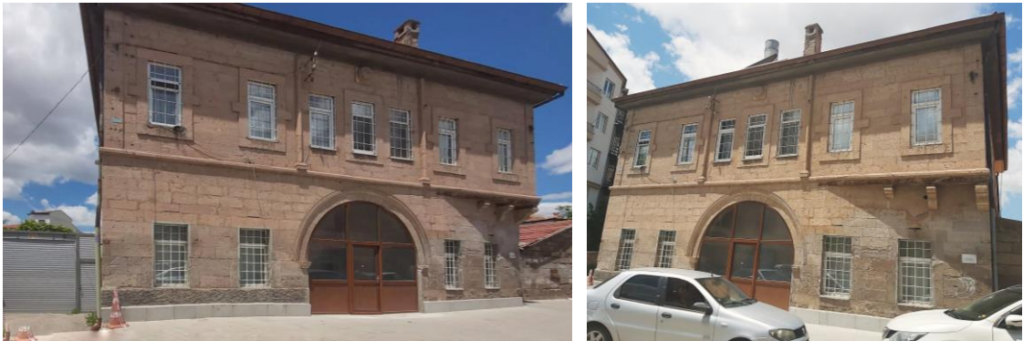
Şekil 4.36. Konut-3 doğu(giriş) cephesi
