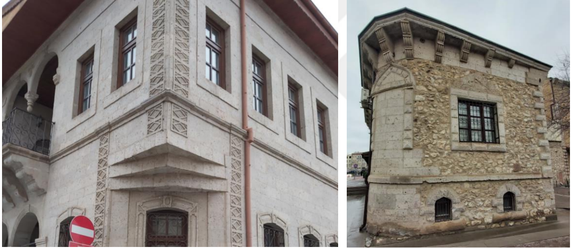
Şekil 5.14. Konut-5(solda) ve Konut-14 sade kat silme örneği
