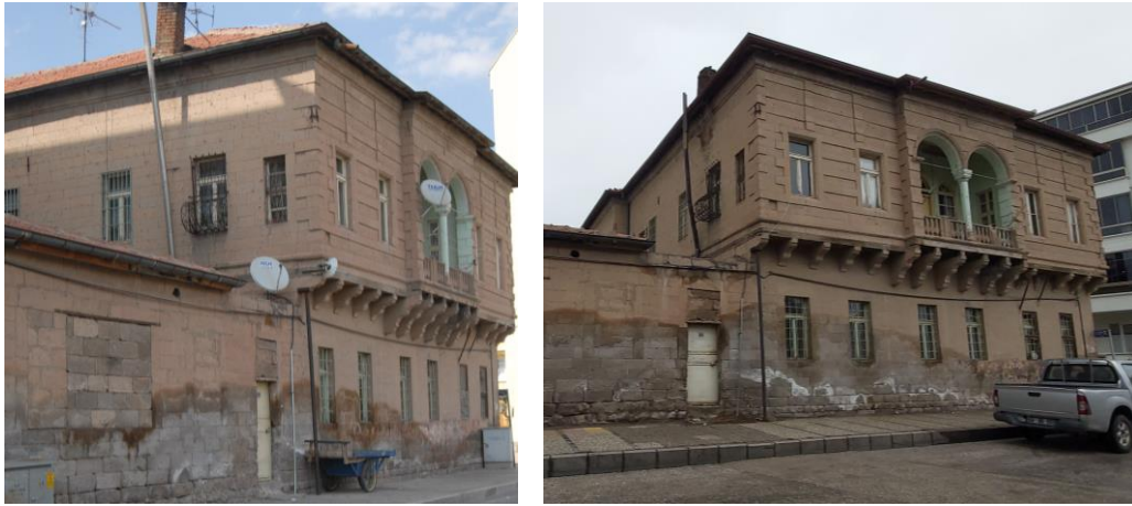
Şekil 4.81. Konut-6 güneydoğu cephesi 2011 yılı (Aksaray İl Kültür ve Turizm Müdürlüğü arşivi) ve günümüz güneydoğu cephesi
