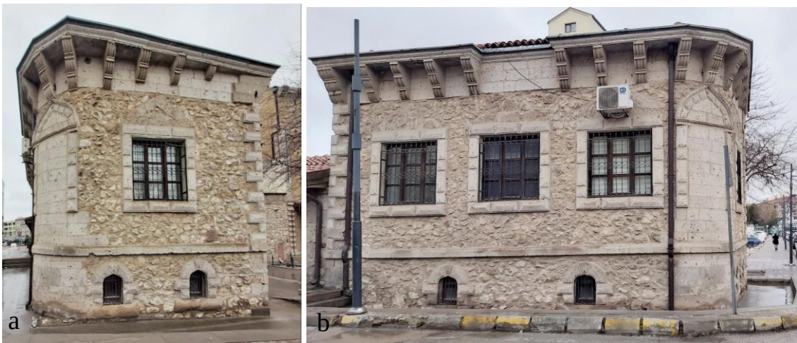
Şekil 4.160. a) Konut-14 kuzey cephesi, b) yapı doğu cephesi
