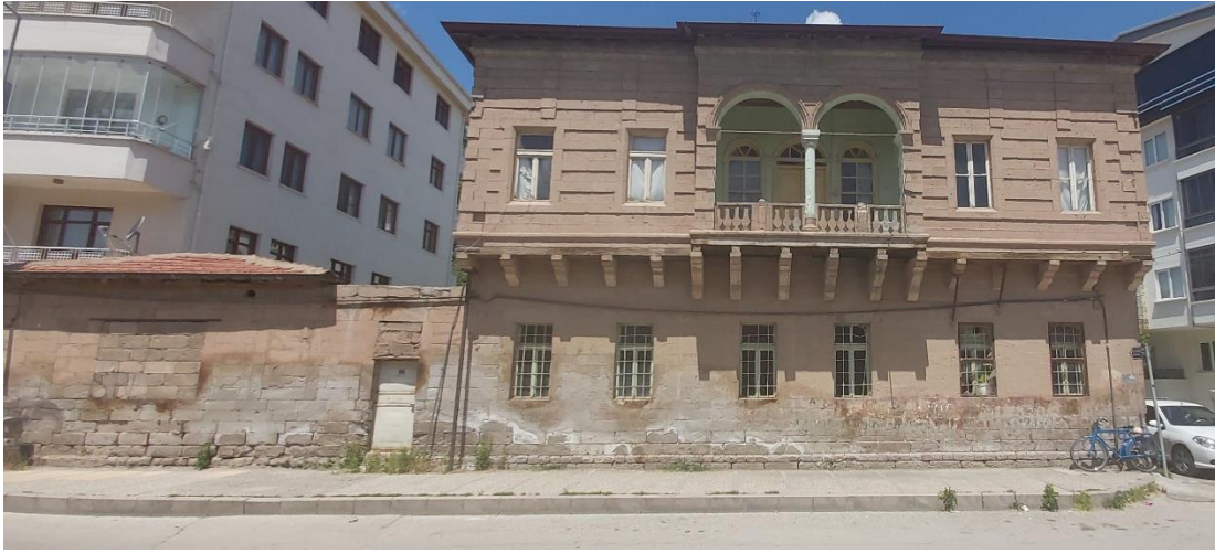
Şekil 4.79. Konut-6 doğu cephesi
