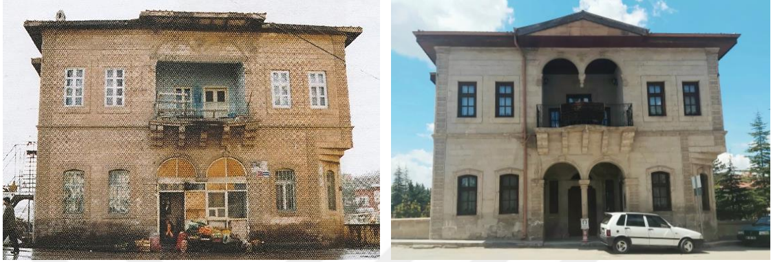
Şekil 4.67. Konut-5 restorasyon öncesi doğu cephesi (Erdal, 2016) ve günümüzdeki doğu cephesi
