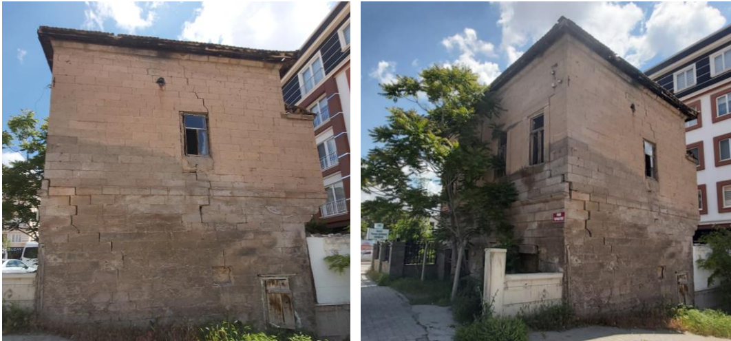
Şekil 4.202. Konut-19 batı cephesi (solda) ve kuzeybatı cephesi (sağda)
