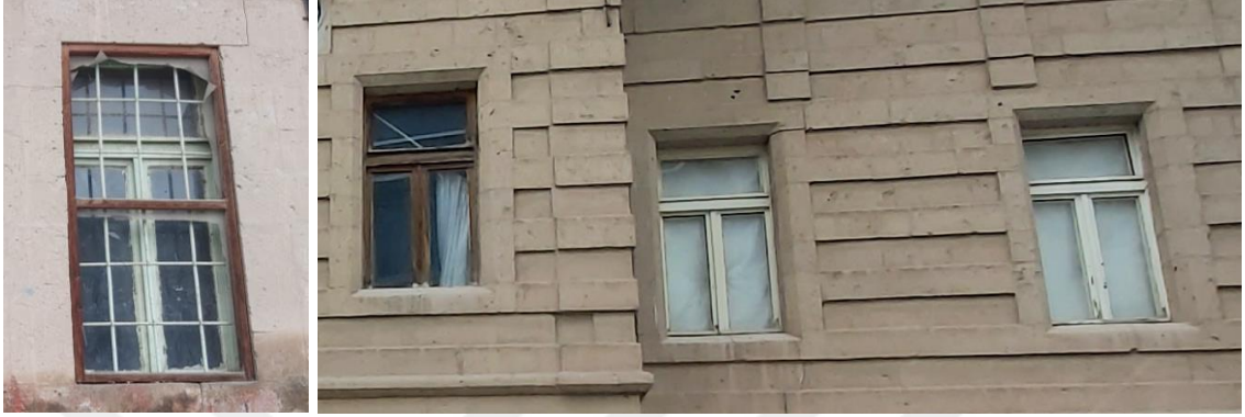
Şekil 4.77. Konut-6 zemin kat penceresi(solda) ve birinci kat pencereleri (sağda)
