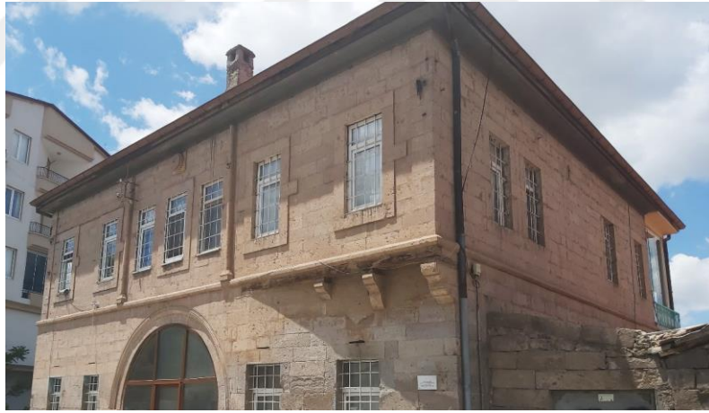
Şekil 4.43. Konut-3 kuzeydoğu cephesi
