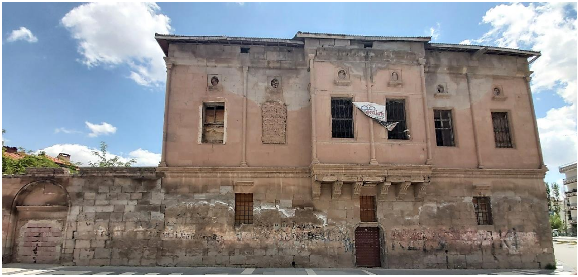
Şekil 4.13. Konut-1 batı cephesi
