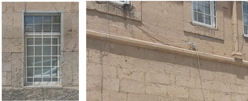
Şekil 4.38. Konut-3 zemin kat penceresi ve sade kat silmesi
