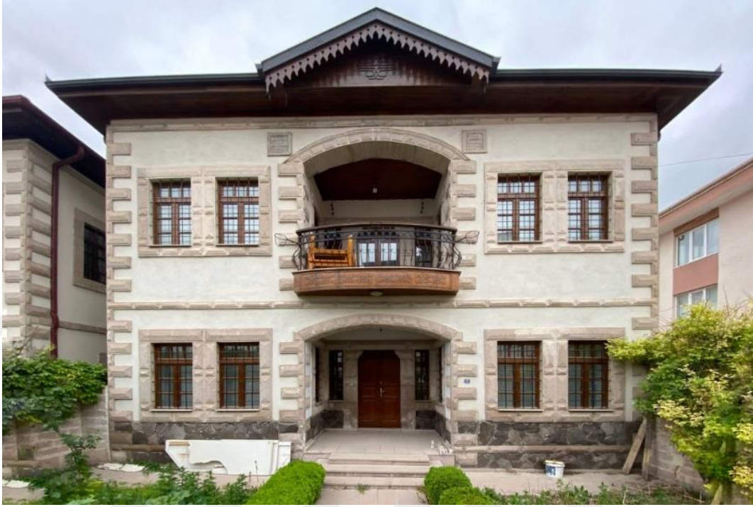
Şekil 4.125. Konut-11 doğu cephesi
