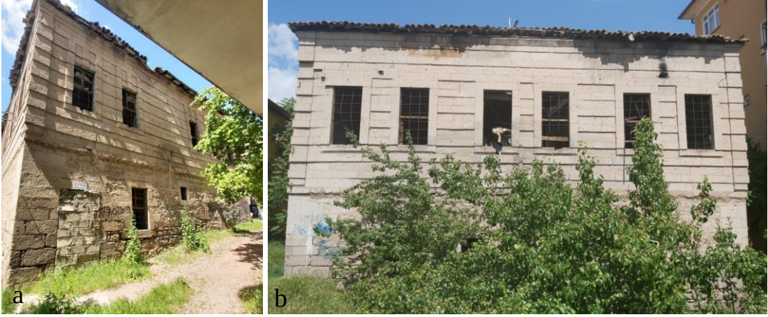
Şekil 4.208. a) Konut-20 doğu cephesi, b) güney cephesi
