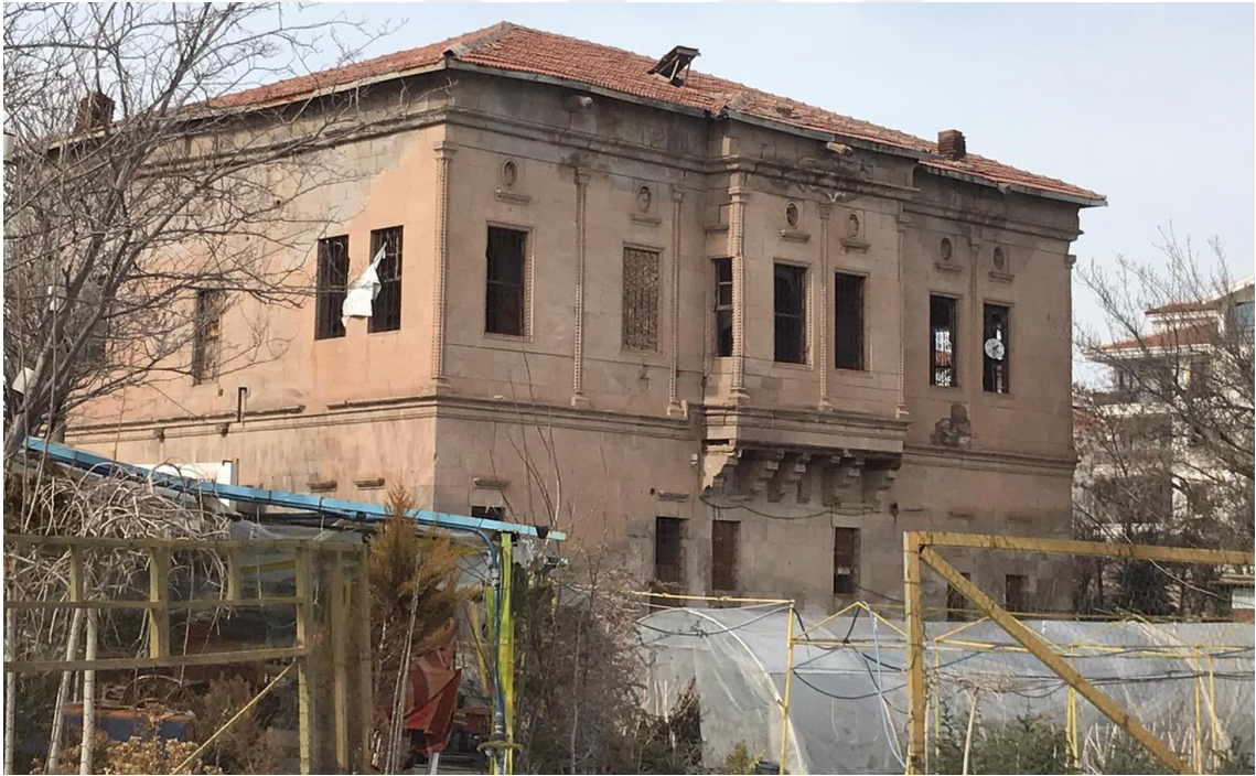
Şekil 4.22. Konut-1 güneydoğu cephesi
