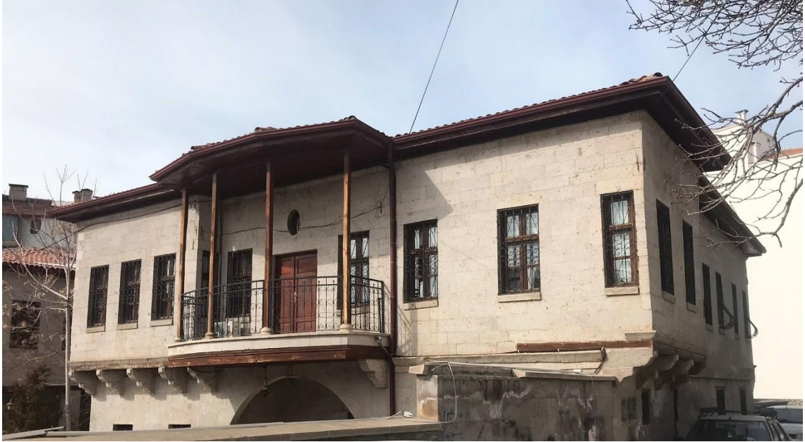
Şekil 4.154. Konut-13 güneydoğu cephesi
