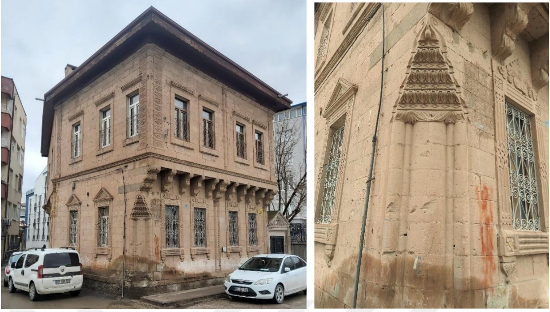
Şekil 4.51. Konut-4 güneybatı cephesi ve bezemeli köşe geçiş pahtı
