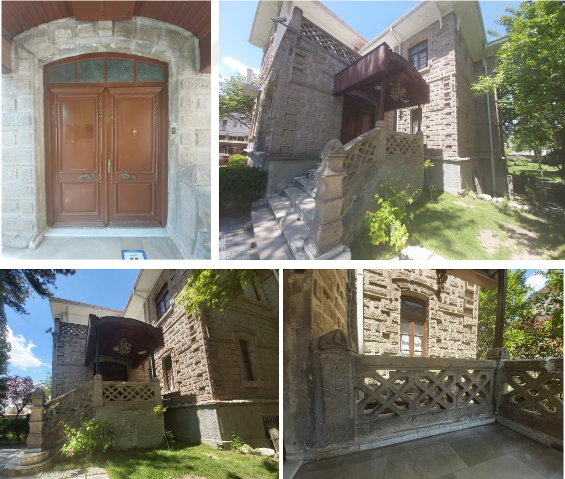
Şekil 4.105. Konut-8 giriş kapısı, giriş merdiveni ve taş korkuluk detayı
