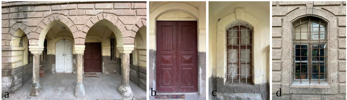
Şekil 4.186. a) Konut girişi, b) giriş kapısı, c) giriş açıklığına bakan oda penceresi, d) zemin kat penceresi
