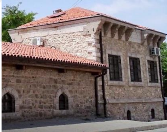
Şekil 4.161. Konut-14 güneydoğu cephesi
