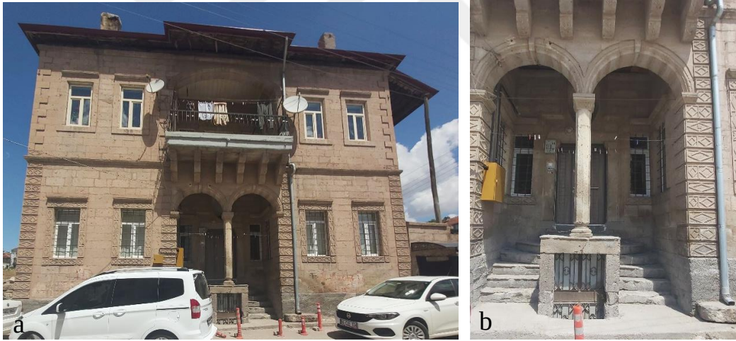
Şekil 4.165. a) Konut-15 güney cephesi, b) giriş sahanlığı
