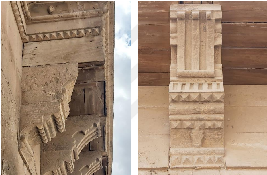
Şekil 4.15. Batı cephesindeki kapalı çıkma altında bulunan bezemeli konsollar
