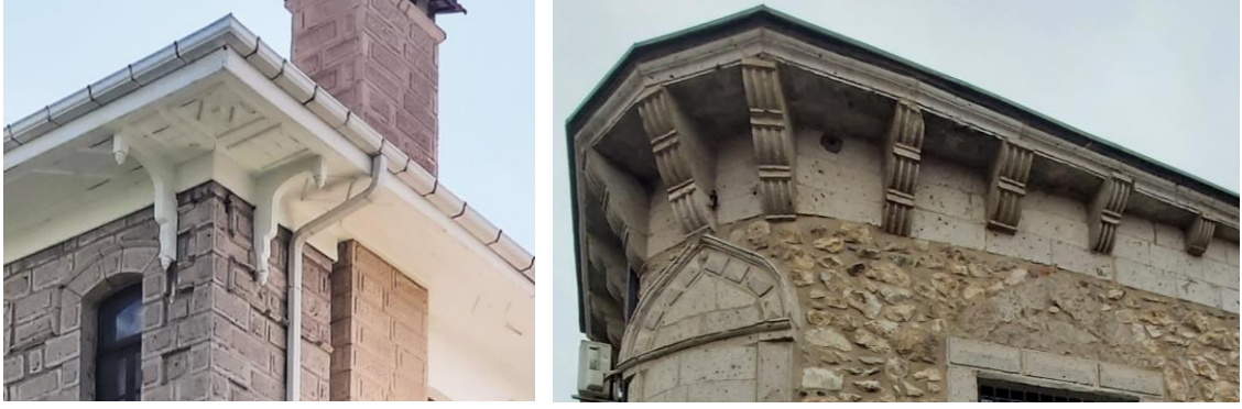
Şekil 5.29. Konut-8 (Eski Vali konağı) ahşap konsol örneği (solda) ve Konut-14 taş konsol örneği (sağda)
