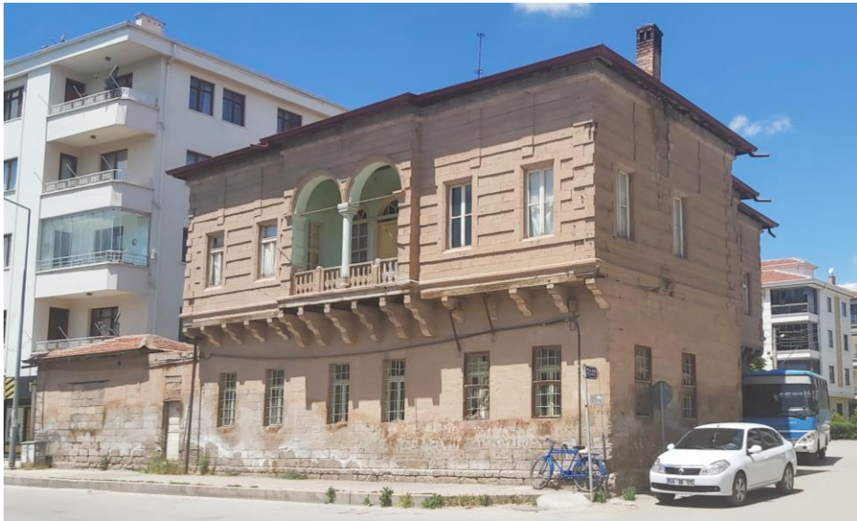
Şekil 4.78. Konut-6 kuzeydoğu cephesi
