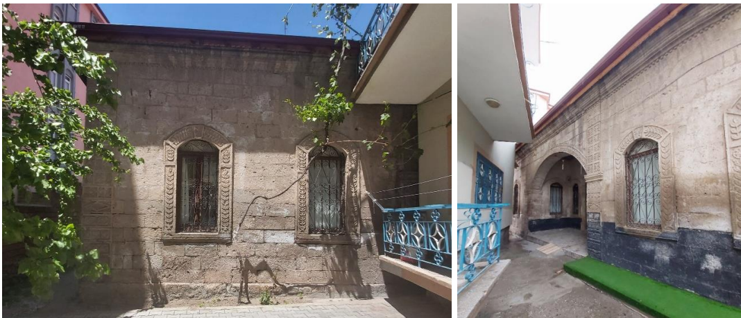
Şekil 4.90. Konut-7 doğu(giriş) cephesi ve cephenin apartman arkasında kalan bölümü
