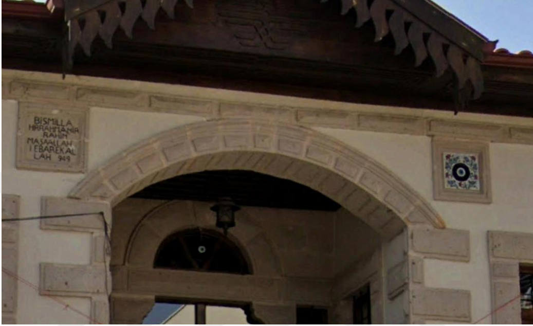
Şekil 5.48. Konut-10 balkon açıklığının sağ üst köşesindeki nazar boncuklu çini örneği
