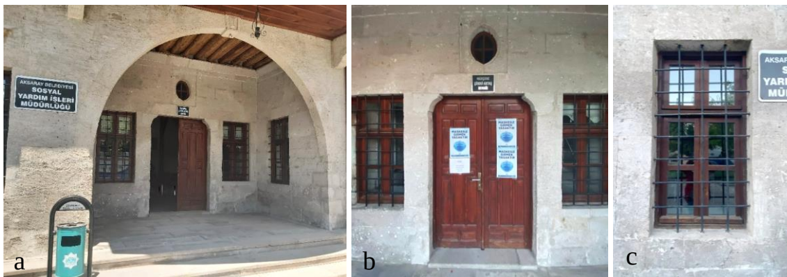
Şekil 4.146. a) Giriş açıklığı ve tavan detayı, b) giriş kapısı ve pencere detayları, c) zemin kat penceresi
