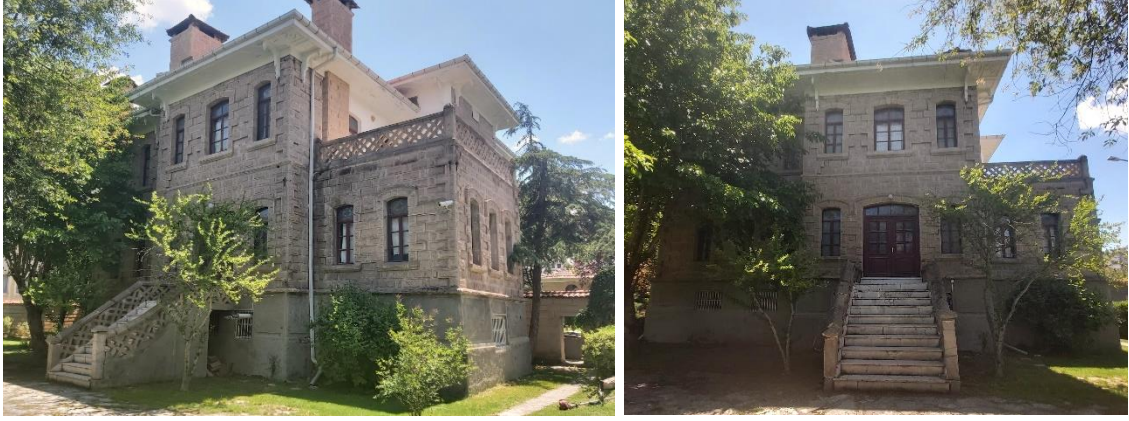
Şekil 4.103. Konut-8 güneybatı ve batı cephesi
