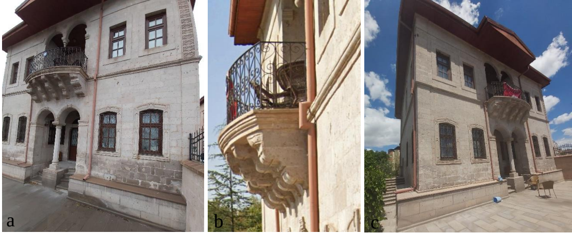
Şekil 4.70. a) Güney cephesi bahçe çıkışı, b) çıkma detayı, c) güneybatı cephesi
