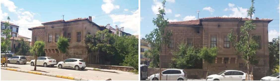
Şekil 4.193. Konut-18 kuzeydoğu ve doğu cephesi sokaktan görünümü
