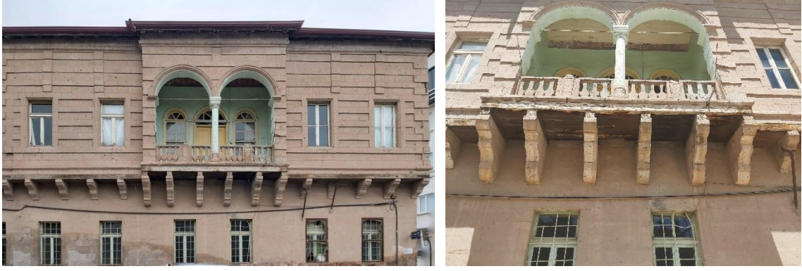
Şekil 4.80. Konut-6 doğu cephesindeki balkon ve konsol
