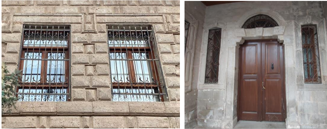
Şekil 5.45. Konut-2 birinci kat pencere parmaklığı (solda) ve Konut-5 süslü aydınlatma penceresi parmaklığı (sağda)
