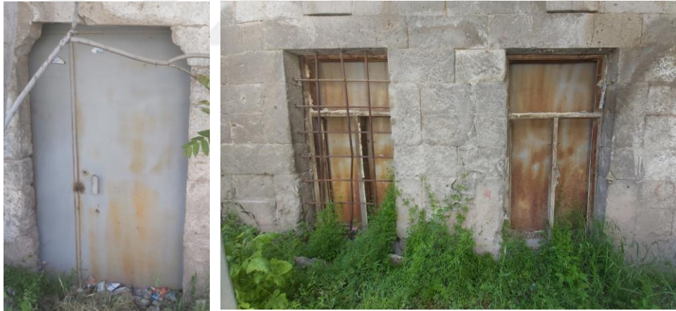
Şekil 4.198. Konut-19 kuzey(giriş) cephesi giriş kapısı ve zemin kat pencereleri
