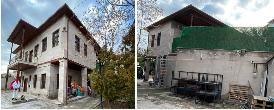
Şekil 4.142. Konut-12 güneydoğu (solda) cephesi ve kuzeydoğu cephesi
