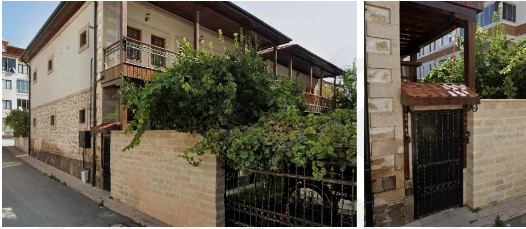
Şekil 4.130. Konut-11 kuzeybatı cephesi ve bahçe avlu kapısı
