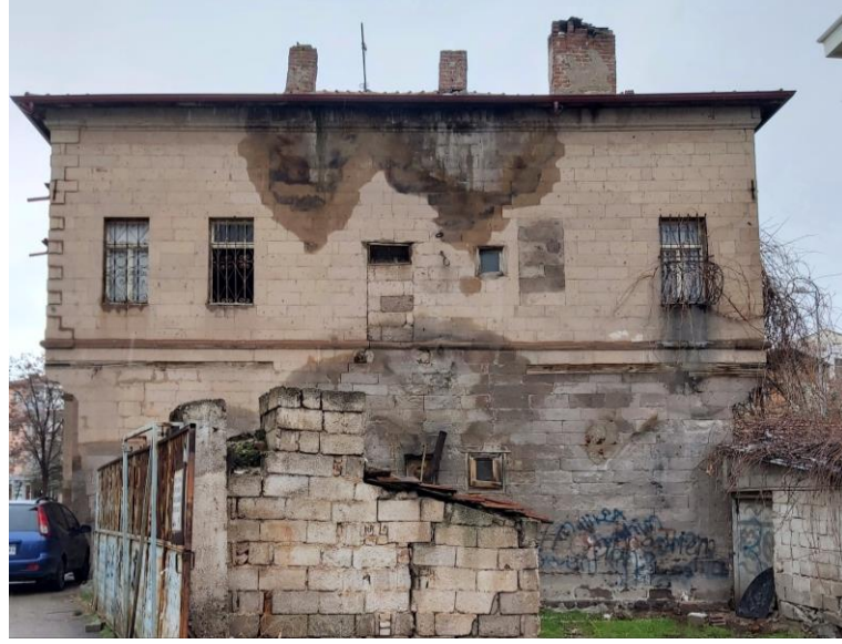
Şekil 4.84. Konut-6 batı cephesi
