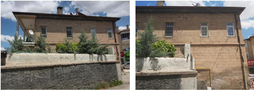
Şekil 4.42. Konut-3 güney cephesi
