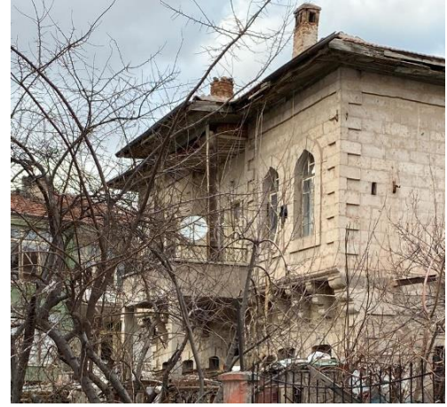
Şekil 4.114. Konut-9 güneybatı cephesi
