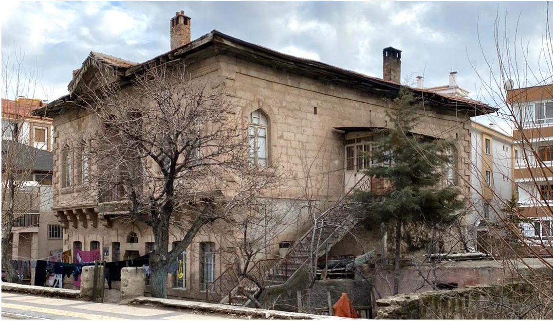
Şekil 4.116. Konut-9 kuzeydoğu cephesi
