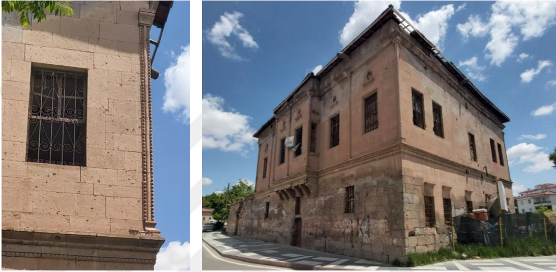
Şekil 4.25. Konut-1 güney cephesindeki bezemeli köşe geçişi (solda) ve güneybatı cephesi (sağda)
