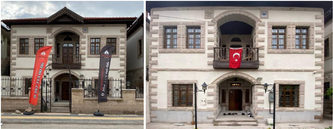
Şekil 4.118. Konut-10 doğu cephesi sokaktan görünümü ve yapı avlusundan görünümü
