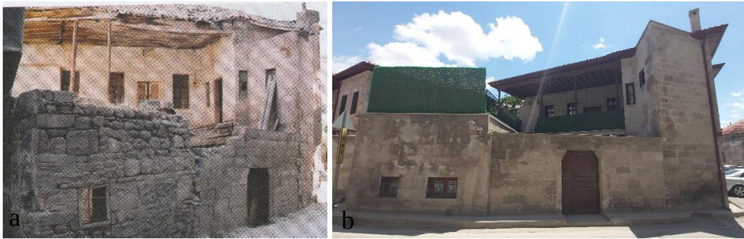
Şekil 4.140. a) Restore edilmeden önceki kuzey cephesi (Erdal, 2016), b) günümüz kuzey cephesi
