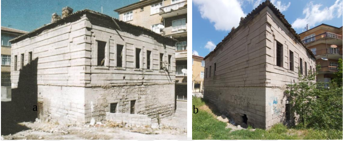
Şekil 4.210. a) Konut-20 eski tarihli güneybatı cephesi (Erdal, 2016), b) günümüz güneybatı cephesi
