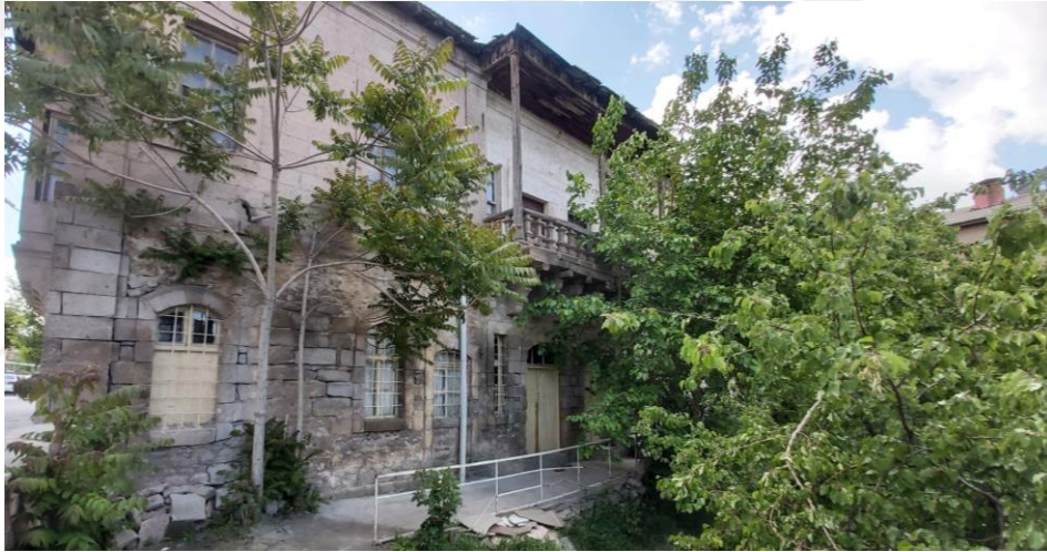
Şekil 4.191. Konut-18 kuzey cephesi bahçe çıkışı ve balkonu
