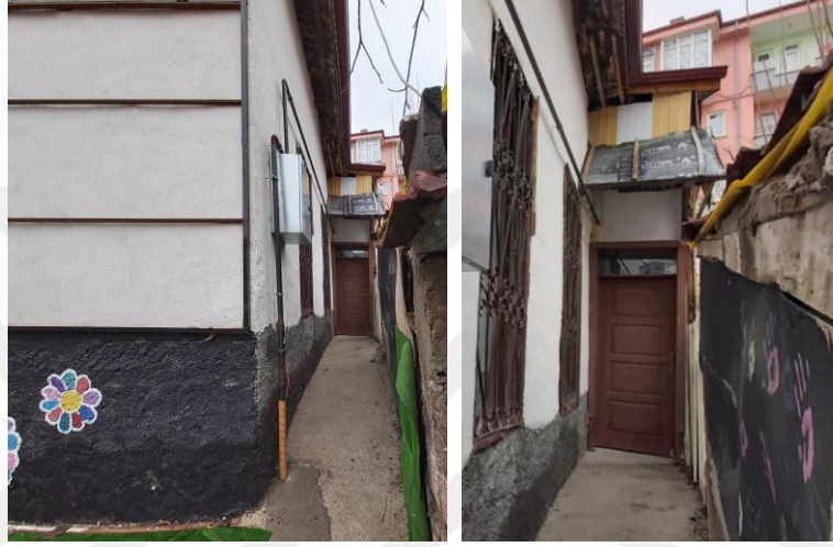
Şekil 4.92. Konut-7 batı cephesindeki sonradan kapatılan açıklık
