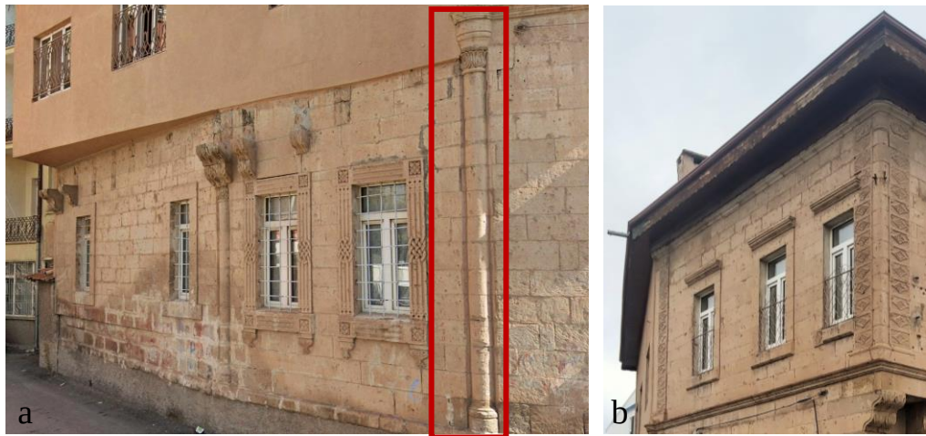
Şekil 4.59. a) Batı cephesi zemin kat sütun ve pencereleri, b) batı cephesi birinci kat pencereleri ve köşebendi
