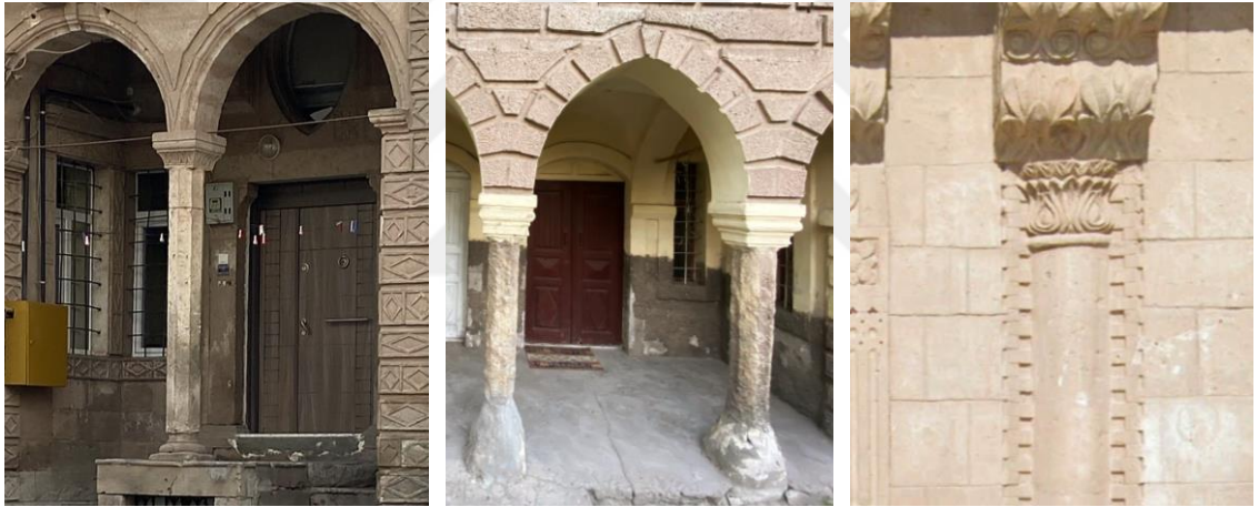
Şekil 5.12. Konut-15 giriş sahanlığındaki kademeli ve bezemeli sütun(solda), Konut-18 giriş revakında bulunan kademeli başlıklı sütun (ortada) ve Konut-4 cephesindeki bezemeli sütunce başlığı(sağda),
