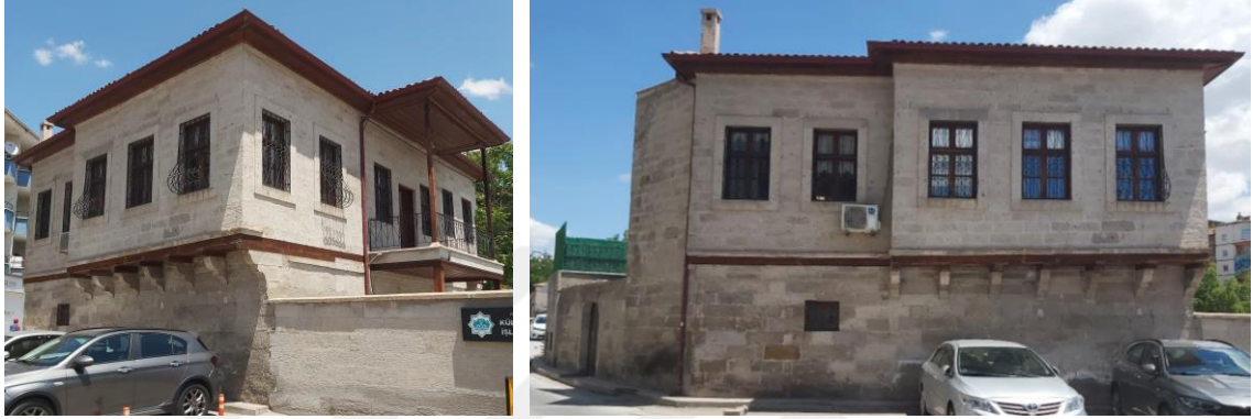
Şekil 4.137. Konut-12 güneybatı (solda) ve batı cephesi (sağda)
