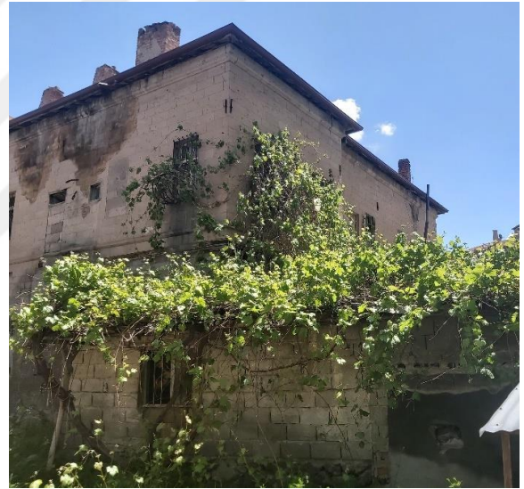
Şekil 4.83. Konut-6 güneybatı cephesi
