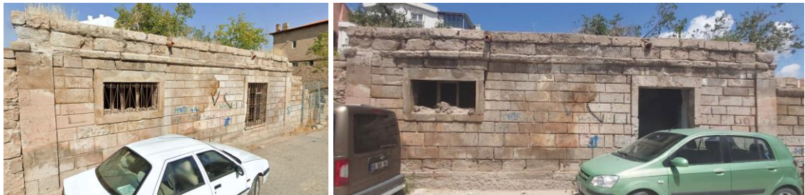
Şekil 4.174. Konut-16, 2020 yılı güney cephesi (solda) ve günümüz güney cephesi (sağda)
