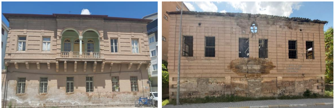
Şekil 5.15. Konut-6(solda) ve Konut-20 yapı cephesinin genelinde kullanılan silme örneği
