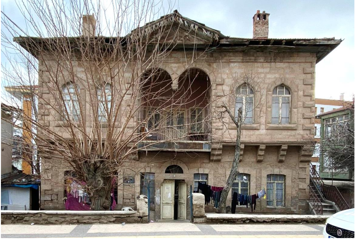
Şekil 4.110. Konut-9 doğu cephesi
