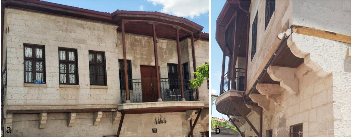
Şekil 4.151. a) Kuzey cephe balkon detayı, b) kapalı çıkmayı destekleyen payandalar
