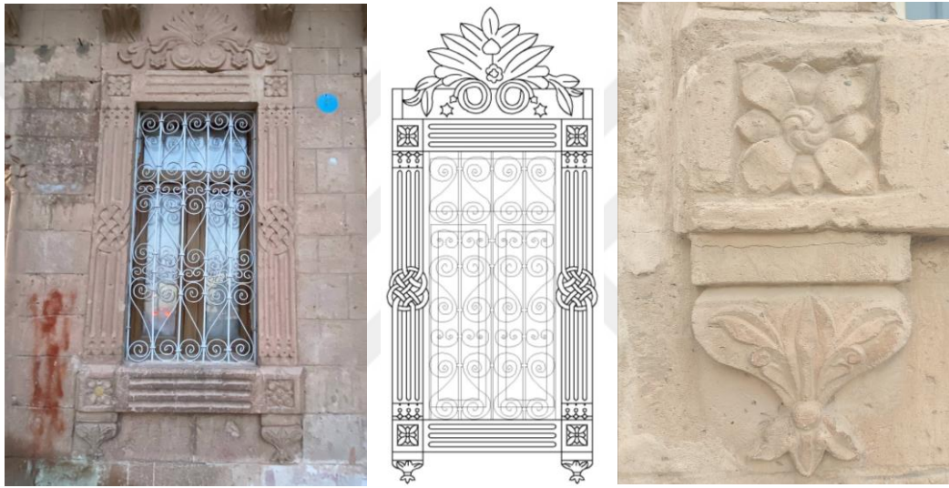
Şekil 4.50. Konut-4 güney cephesi zemin kat penceresi ve süsleme detayı
