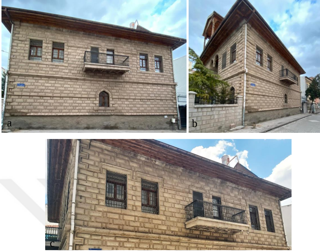
Şekil 4.34. Konut-2 a) batı cephesi, b) kuzeybatı cephesi c) batı cephesi birinci kat düzeni ve ahşap saçak
