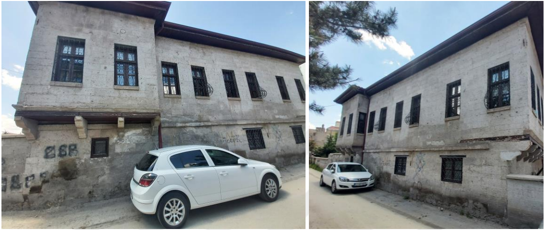
Şekil 4.152. Konut-13 doğu cephesi
