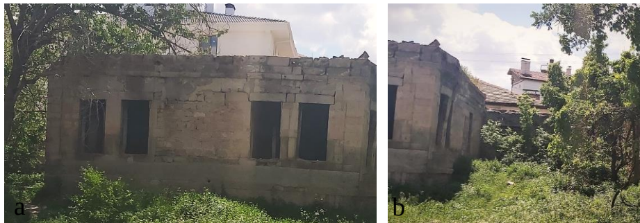
Şekil 4.176. a) Konut-16 kuzey cephesi, b) kuzeybatı cephesi
