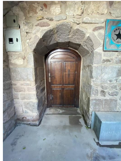
Şekil 4.159. Bodrum kat giriş kapısı
