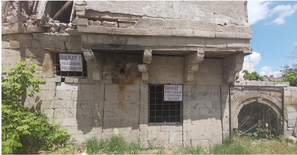
Şekil 4.180. Konut-17 güney cephesi zemin kat görünümü
