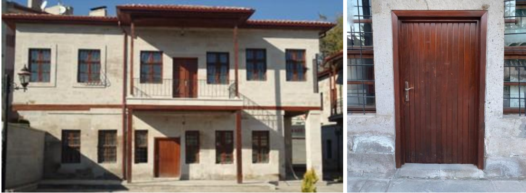
Şekil 4.135. Konut-12 güney cephesi ve giriş kapısı
